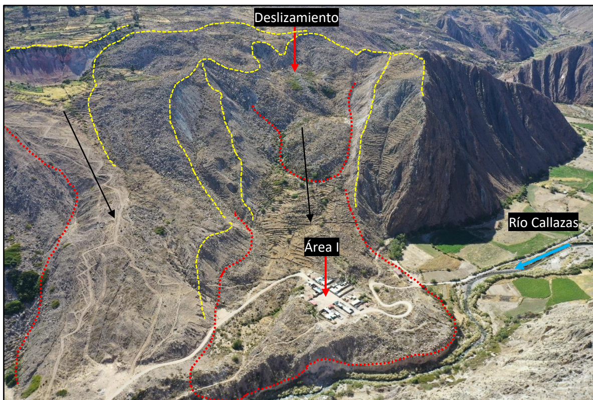
Figura 9. Procesos de deslizamientos en la primera zona de acogida para el anexo Marjani.
