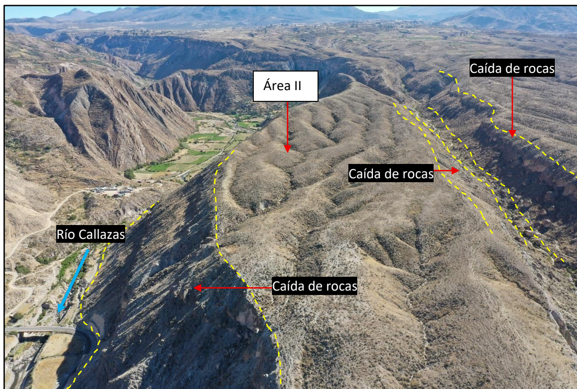
Figura 11. Procesos de caída de rocas en inmediaciones del área II, propuesto por la municipalidad para la reubicación del anexo Marjani.
