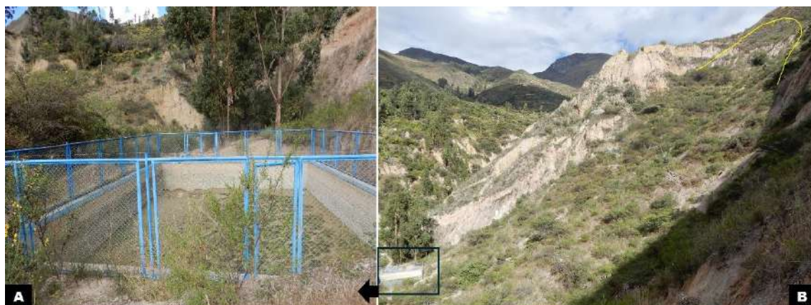
Figura 22. A. Reservorio de agua con fines de regadío. B. El reservorio se ha construido en el cuerpo de un deslizamiento antiguo.
