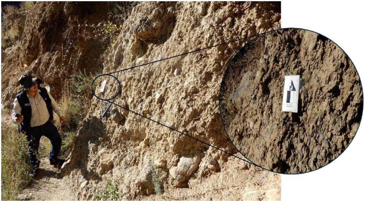
Figura 7. Vista del depósito coluviodeluvial conformado por clastos angulosos a subangulosos heterométricos con tamaños que van de 0.01-0.8 m. envueltos en una matriz arcillo-limo-arenosa, el depósito se muestra algo húmedo. Coordenadas UTM 18L 272167E; 8964257N.
