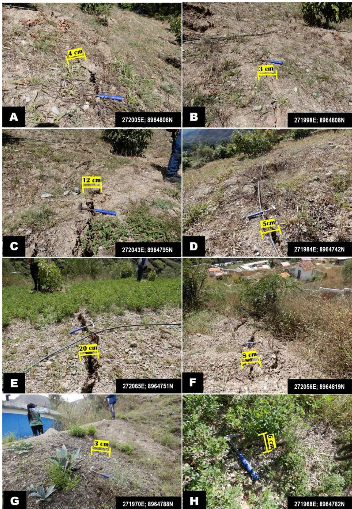
Figura 18. Vista de grietas longitudinales y transversales que presentan un ancho que varían entre 0.03m y 0.25m mientras que su profundidad varia de 0.10m y 0.50m.
