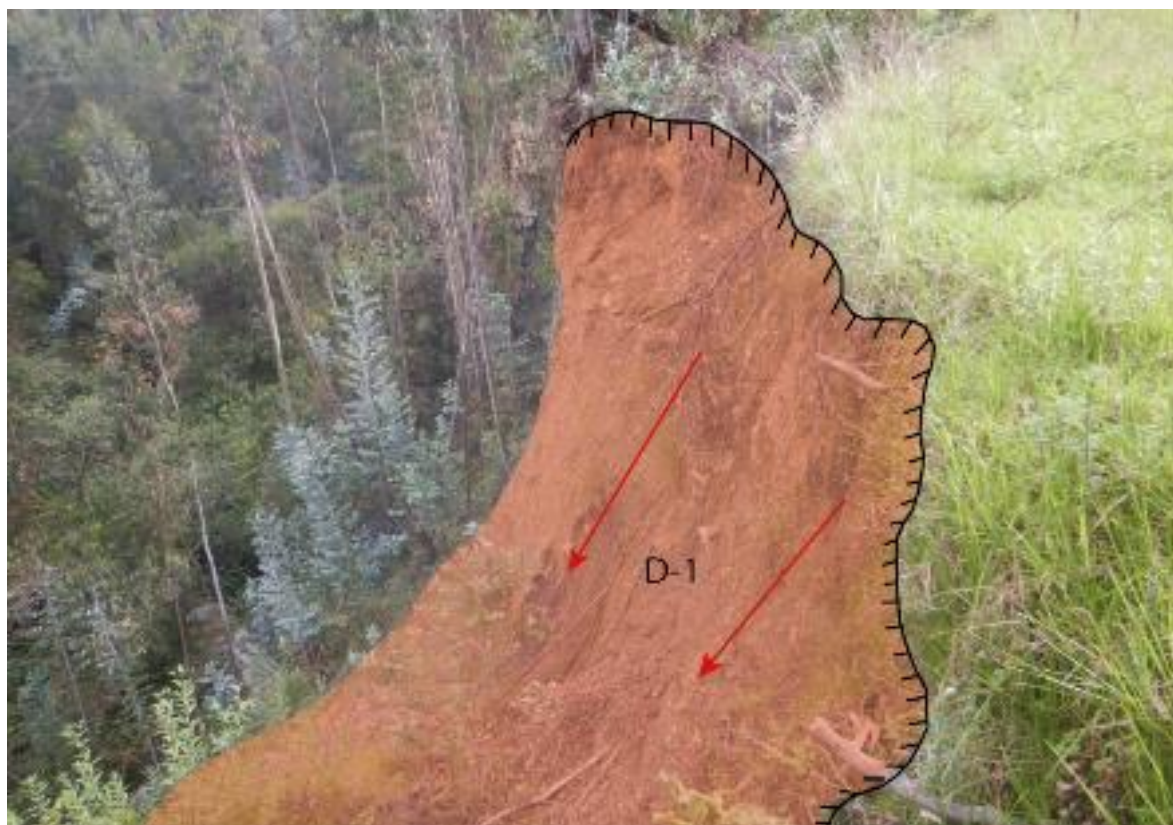
Figura 7. Vista del derrumbe D-1, el cual tiene una longitud de arranque de 14.5 m, altura de 21 m, que ocurre con dirección de movimiento de noroeste a sureste, donde se puede distinguir material coluvial que fue depositado al pie del talud, susceptibles a ser removidos con facilidad durante lluvias excepcionales.
