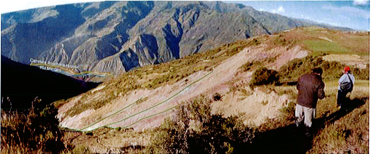
Foto 11: Vista aguas debajo de la quebrada Yanapaccha, desde la zona de derrumbe (D2), se ha resaltado el abanico proluvial formado por la quebrada en su desembocadura al río Mantaro.
