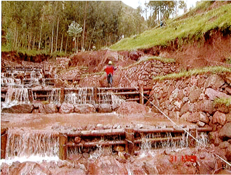
Foto 14: Otra vista de los diques transversales contruidos con troncos.
