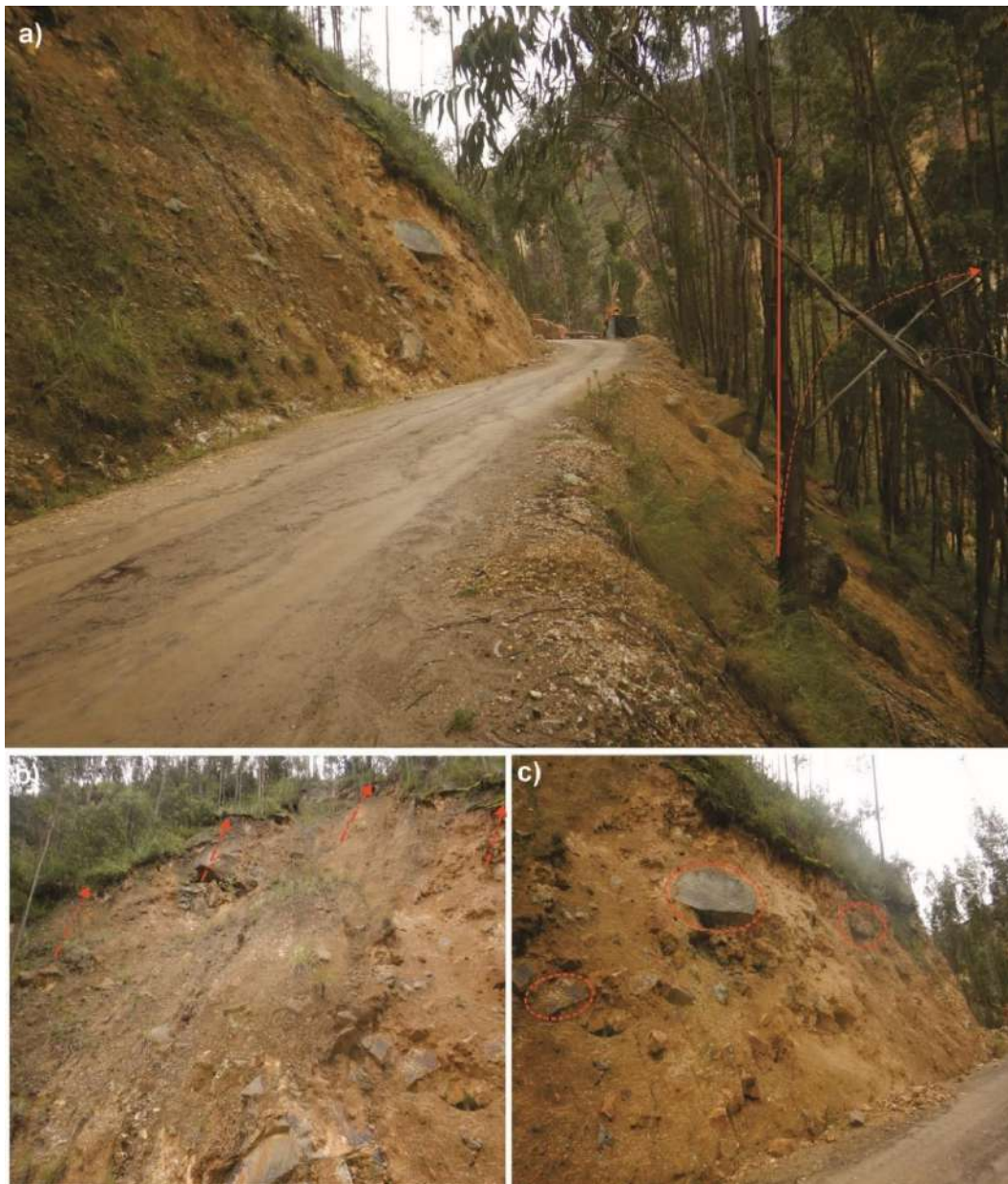
Figura 16. Vista del derrumbe a) afectó directamente a la vía; actualmente se encuentra transitable, se observa algunos bloques inclinados y otros caídos, b) vista de la zona de arranque, así mismo se evidencia árboles y vegetación característica de la zona, y c) bloques colgados en la ladera que llegan a 2.5 m.
