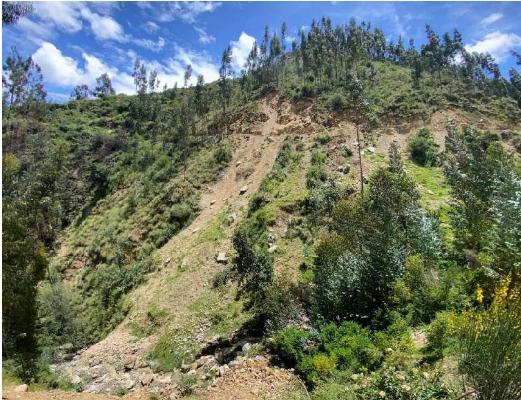
Fotografía 3. Vista panorámica del derrumbe reactivado el 6 de marzo del 2025, el cual afectó por dos días el tránsito vehicular y peatonal.
