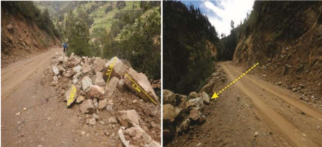
Figura 21. Se observan bloques acarreados a un lado de la vía removidas con maquinaria.
