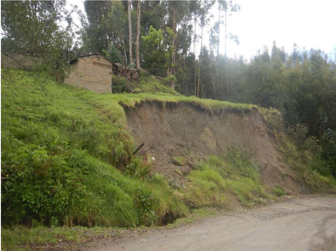
Fotografía 7. Vista del deslizamiento rotacional ( Desl_01 ), generado el 02 de marzo del 2025, por temas de salvaguardar la seguridad de los dueños, ellos han deshabitado la vivienda.
