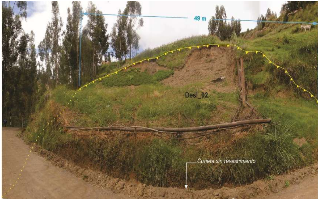
Figura 24. Vista del deslizamiento ( Desl_02 ), presenta una escarpa de 49 m, así mismo se puede visualizar la cuneta, que recientemente realizaron mantenimiento.
