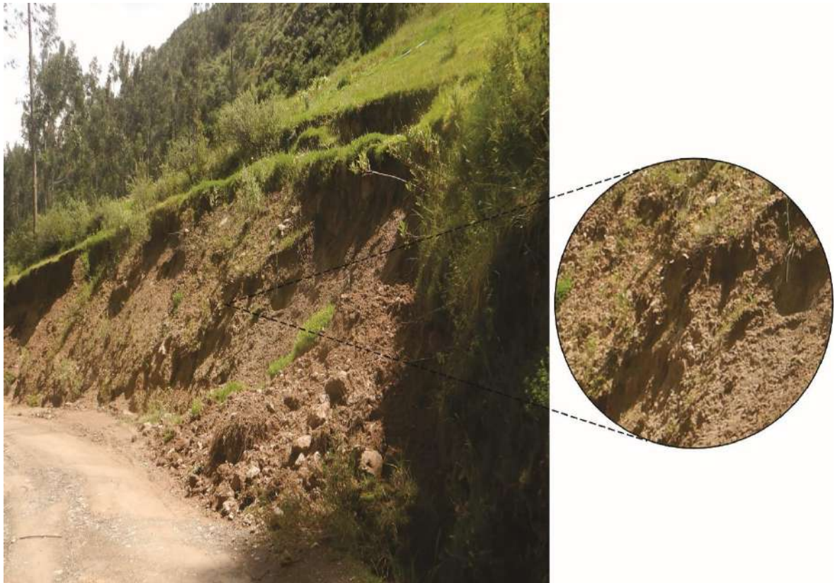
Figura 9. Vertiente coluvio-deluvial identificado en la margen derecha de la quebrada Hualcor, donde se observan bloques y gravas de naturaleza volcánica, subangulosas a redondeados, envueltas en matriz limo arcilloso - arenoso .
