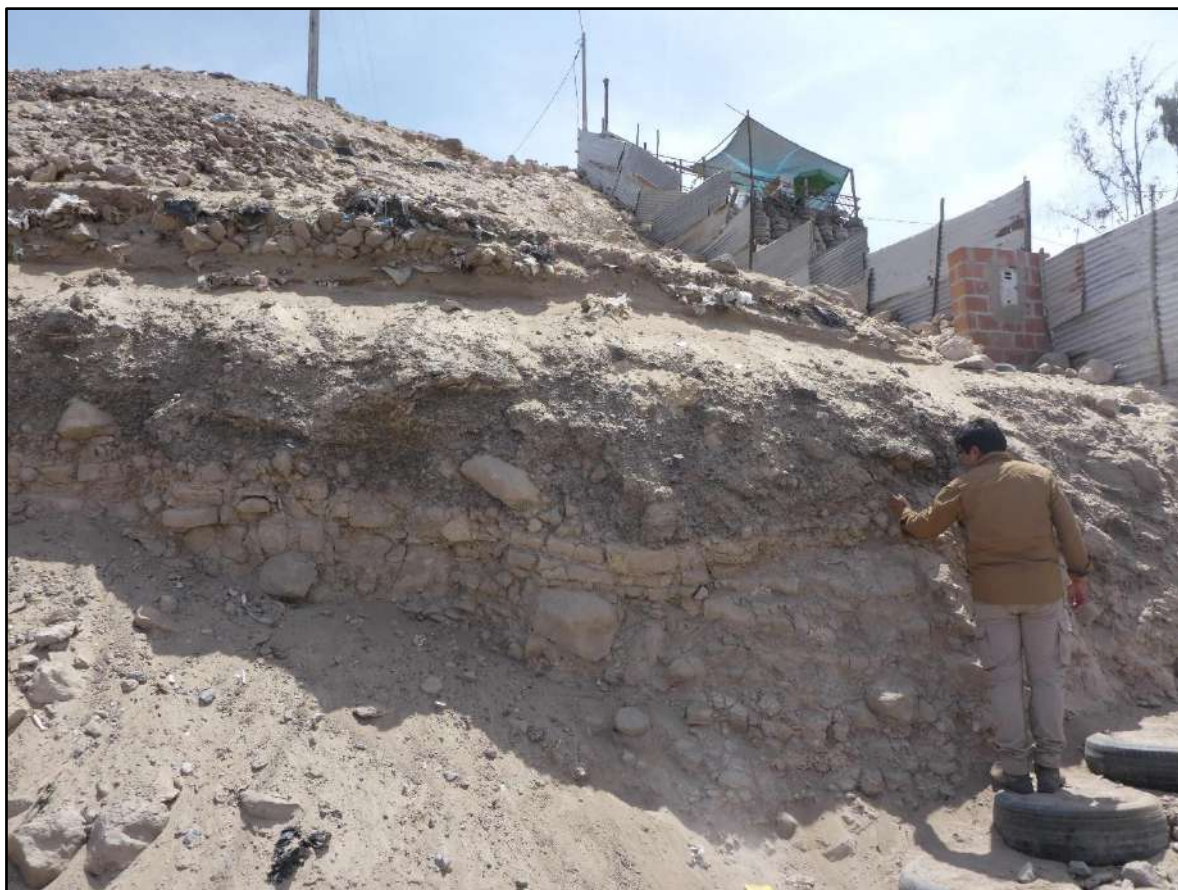
Fotografía N° 1. Afloramiento de depósitos aluviales, en la ladera Sureste de cerro Intiorko.
