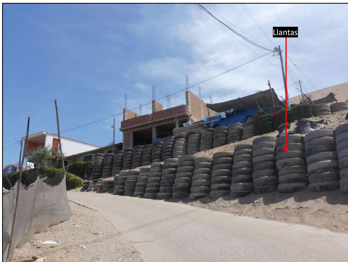
Figura 2. Viviendas sobre terraplenes contruidos con llantas, sector Intiorko.
