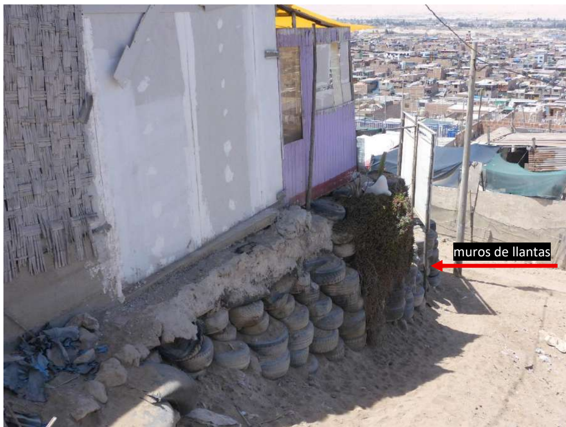
Figura 8. Sector Intiorko, viviendas asentadas sobre muros de llantas.
