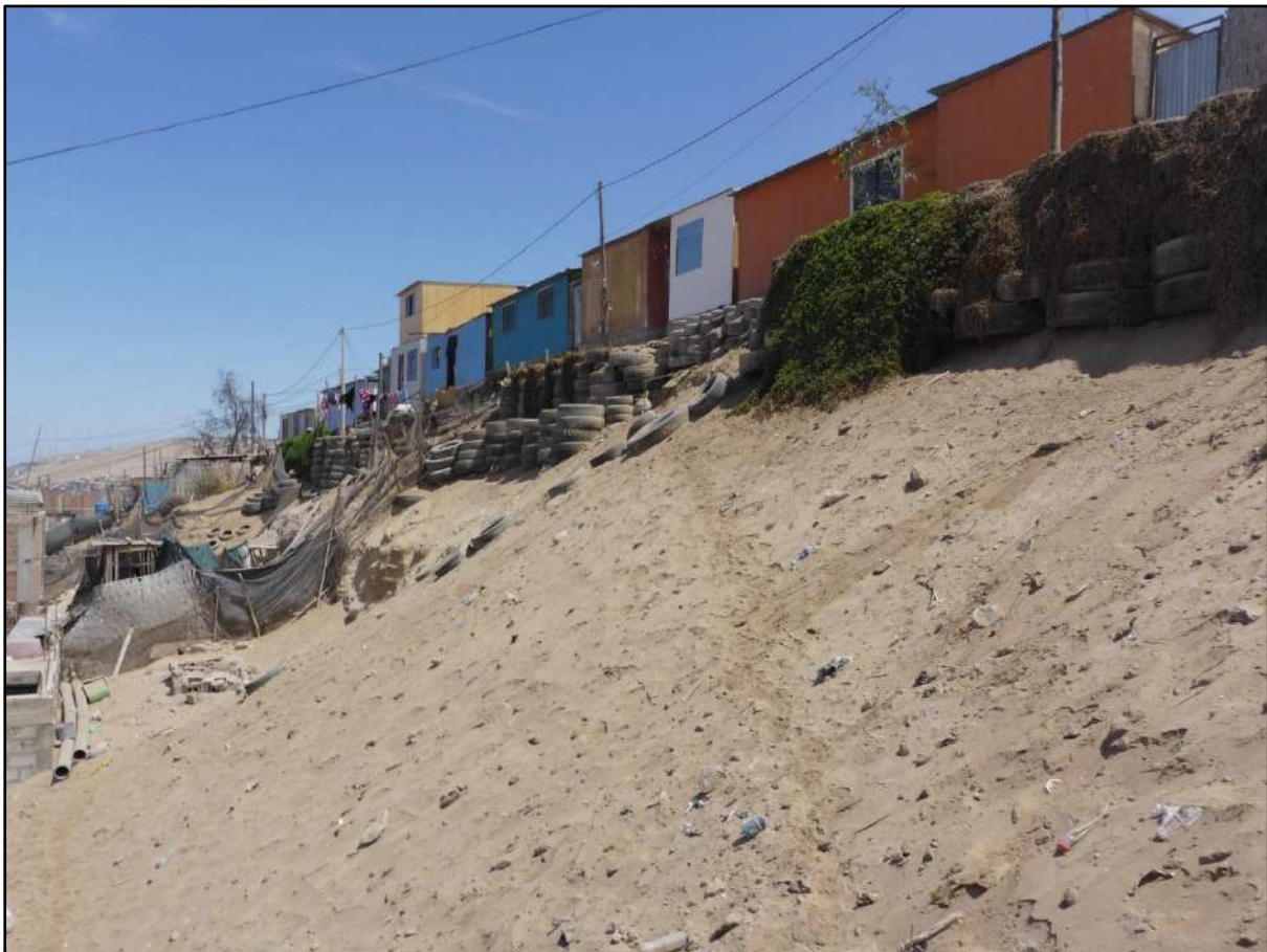
Figura 10. Sector Intiorko, viviendas asentadas sobre muros de llantas.
