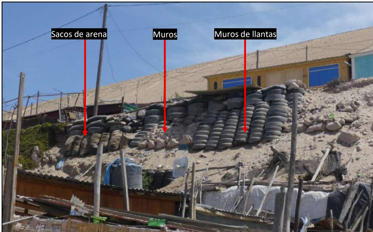
Figura 9. Sector Intiorko, viviendas asentadas sobre muros de llantas, sacos de arena y muros.
