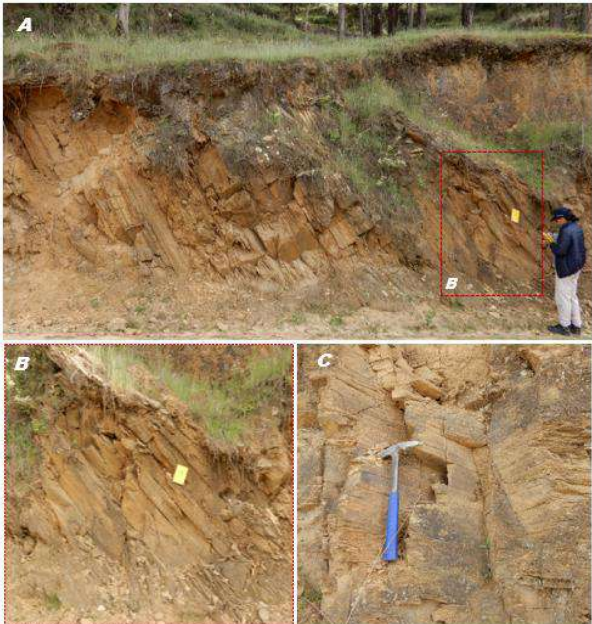
Figura 4. A) Afloramiento rocoso compuesto por esquistos y metareniscas, altamente meteorizadas debido. B) Presenta 4 familias de discontinuidades y se rompe con un golpe del martillo (picota).
