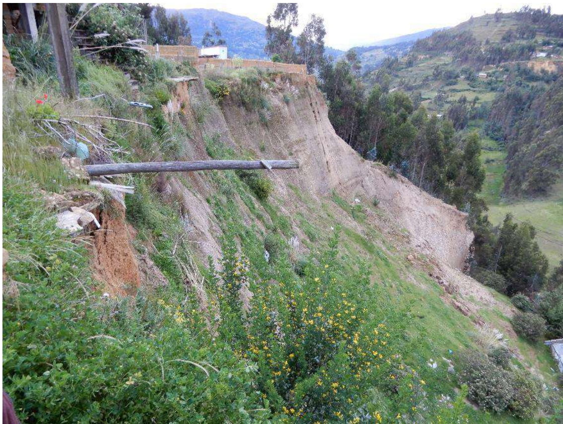
Fotografía 5. Condiciones actuales del escarpe del deslizamiento producido el 2019.
