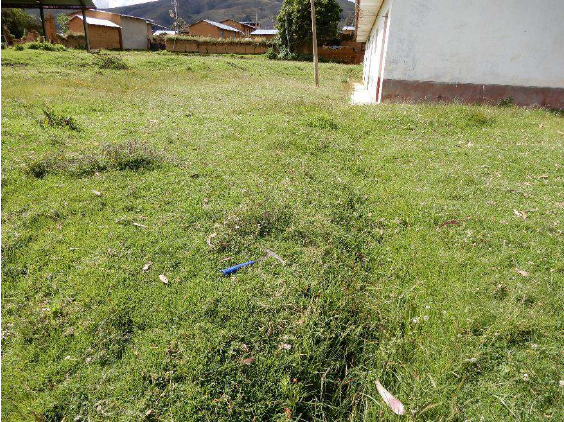
Fotografía 8. Canal de drenaje sin revestir, que canaliza sus aguas hacia la zona de carcavamiento 1.
