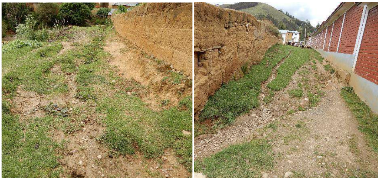
Figura 21. Vista del Jr. Dos de Mayo e Izcuchaca, por donde se canaliza y discurre el agua de lluvia en dirección hacia la zona de carcavamiento 2.
