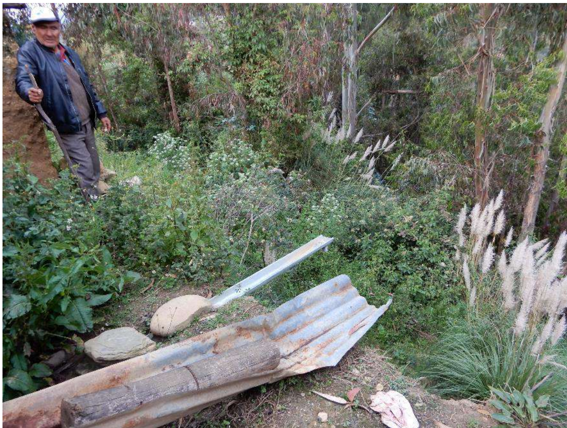
Fotografía 6. Vista de calaminas implementadas como canales recolectores de agua de lluvia, que son vertidos directamente a la zona de deslizamientos.
