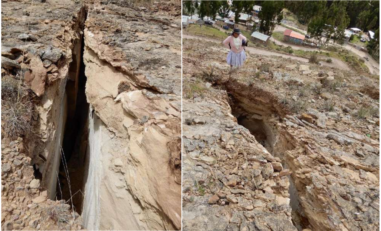
Figura 10. Vista de las aperturas y profundidad de las grietas producidas en la ladera del cerro Pucara.
