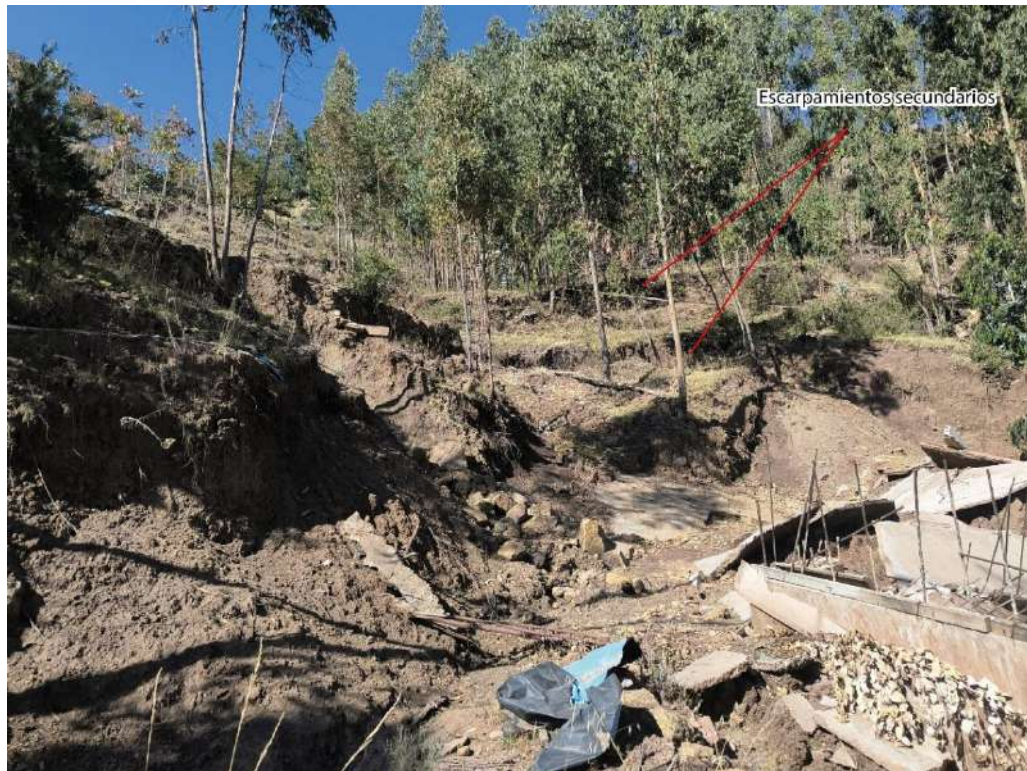
Figura 12. Cuerpo del deslizamiento rotacional Dr-1, se observan escarpes en el terreno.
