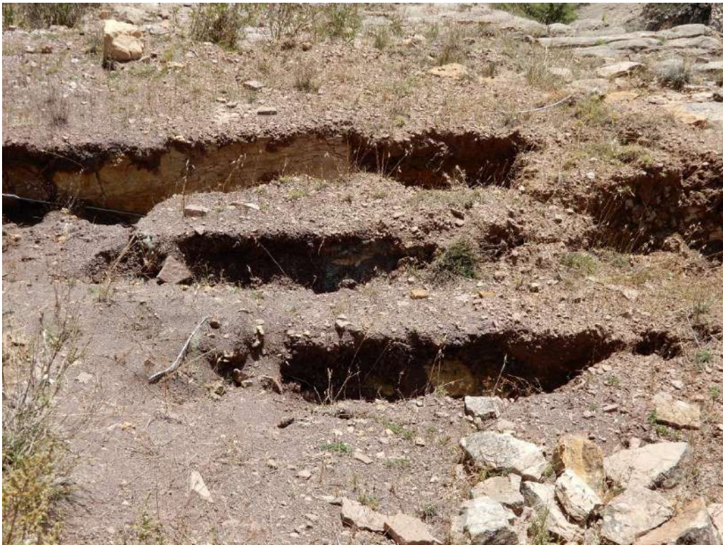
Fotografía 5. Agrietamientos en la ladera media del cerro Pucará.
