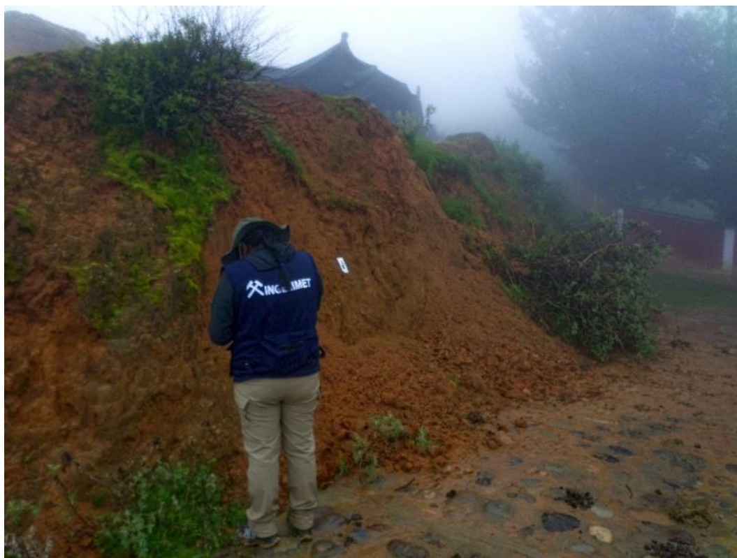
Fotografía 3. Derrumbe 3 (D-3), se da sobre depósito coluvial correspondiente al cuerpo de un deslizamiento antiguo, presenta una longitud de arranque de 6 m y altura de 1.90 m.
