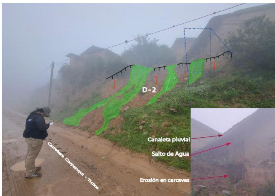
Figura 10. Derrumbe 2 (D-2) disectada por erosión en cárcavas producto del escurrimiento de las aguas pluviales.
