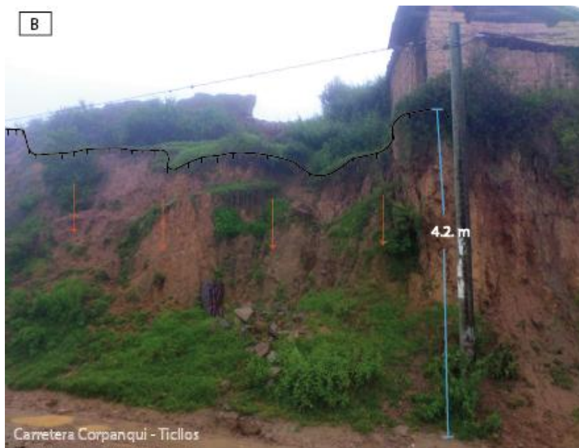
Figura 8. A) Derrumbe D-1, donde se muestra la reactivación con longitud de arranque de 2.5 m y altura de arranque 4.2 m; B) Derrumbe D-1 con una altura de arranque de 4.2 m, apreciándose una vivienda de adobe al borde de la zona de arranque del derrumbe, donde se puede distinguir material coluvial depositado al pie del talud, susceptibles a ser removidos con facilidad durante lluvias excepcionales.
