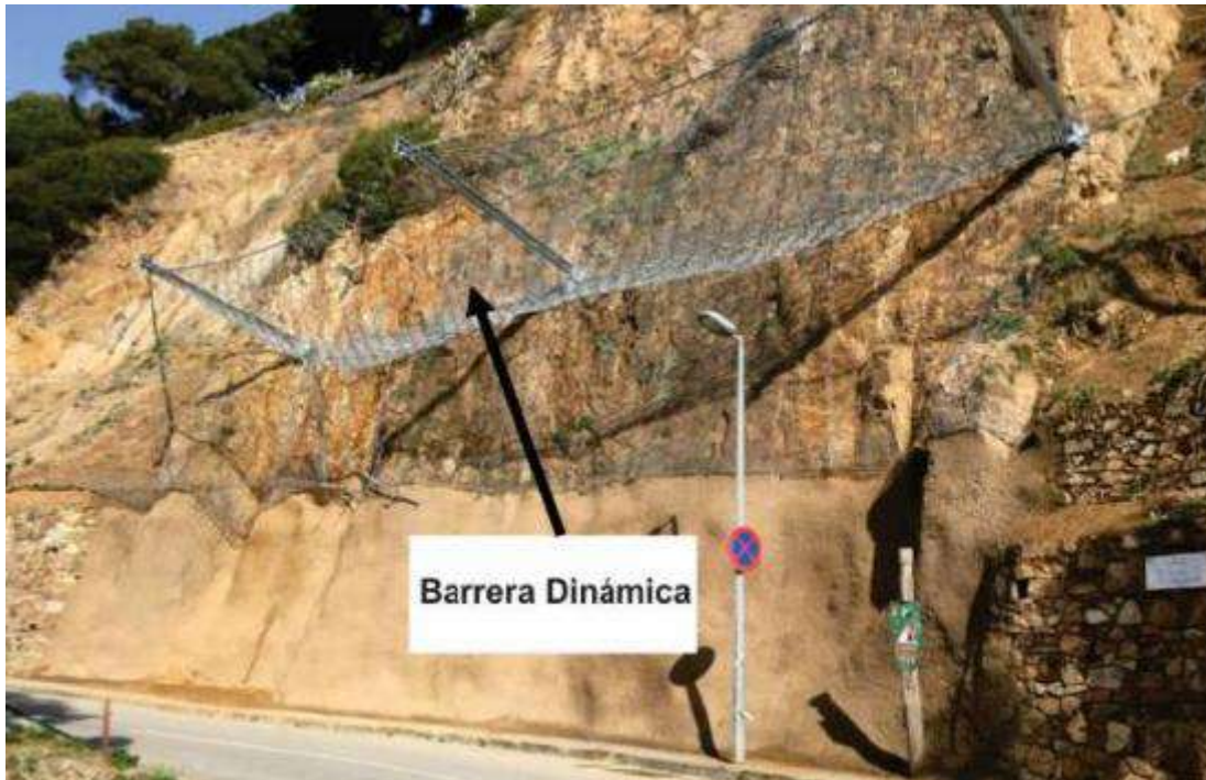
Figura 30. Ejemplo de barreras dinámicas.
