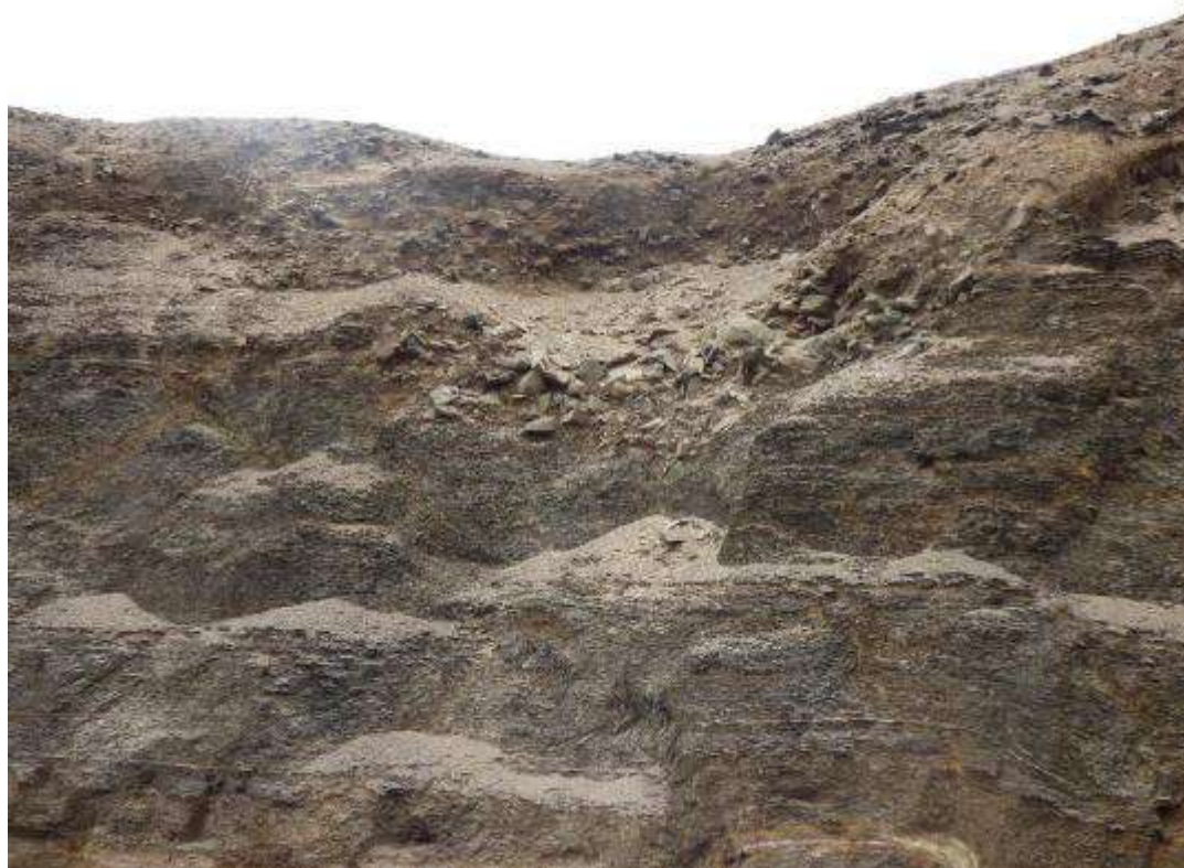
Fotografía 5. Depósitos coluviales dispuesto de manera discordante sobre la parte superior del talud en el sector del Morro Solar. Vista mirando al noreste.
