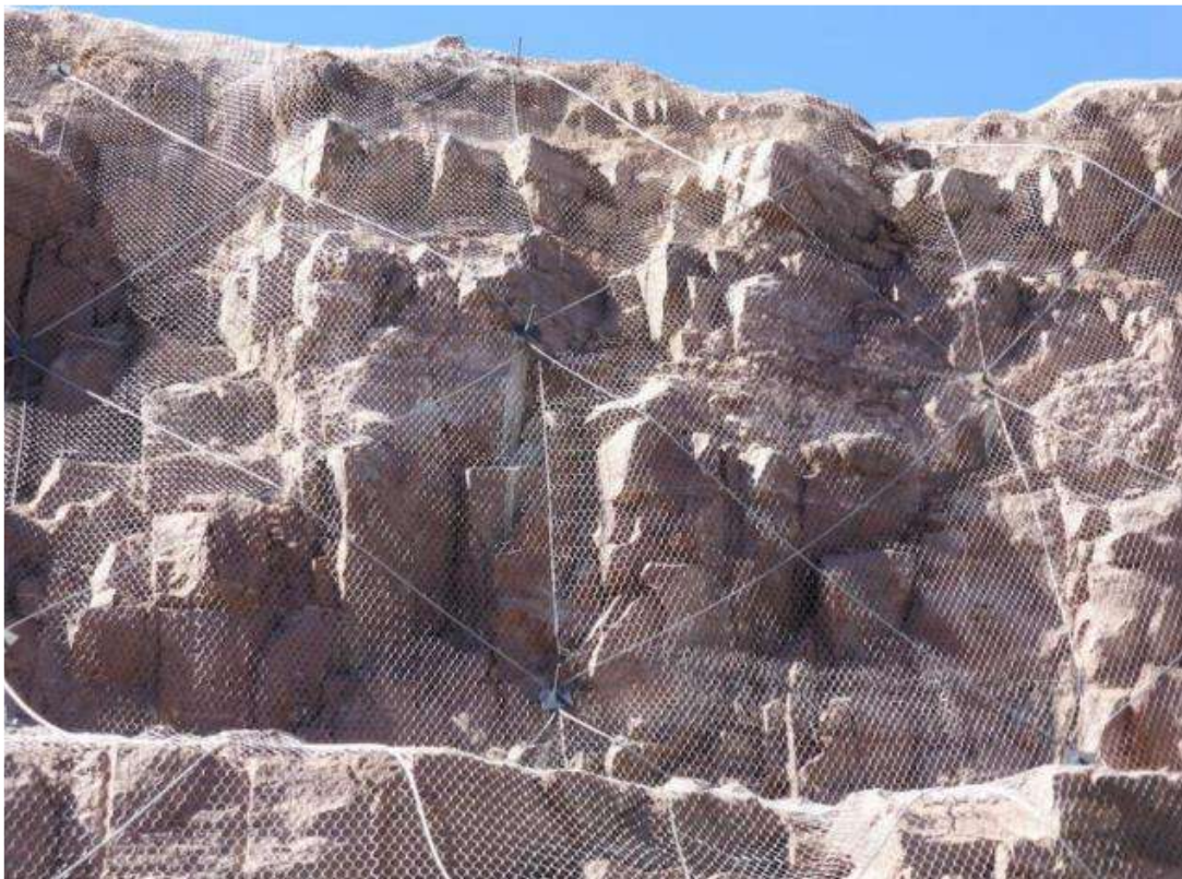
Figura 28. Ejemplo de implementación de mallas ancladas para el control de caída de rocas o bloques rocosos.
