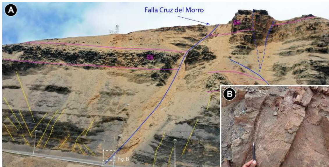
Figura 10. A) Falla Cruz del Morro que afecta a las rocas de la Formación La Herradura y al sill andesítico, se observa un fuerte fracturamiento en la parte inferior del talud. Vista mirando al noreste. B) Detalle de la falla donde se observa una fuerte esquistosidad paralela al trazo de la falla.
