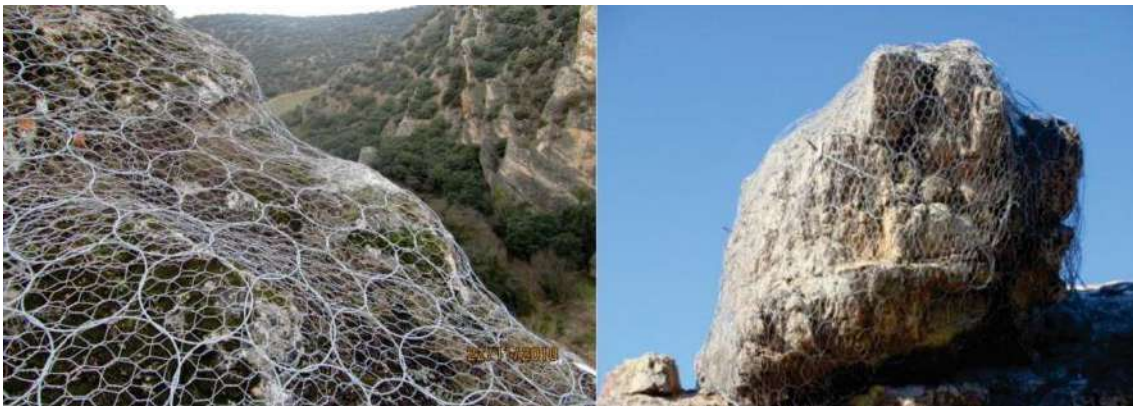
Figura 29. Ejemplo de estabilización de rocas o bloques rocosos con red de anillos.
