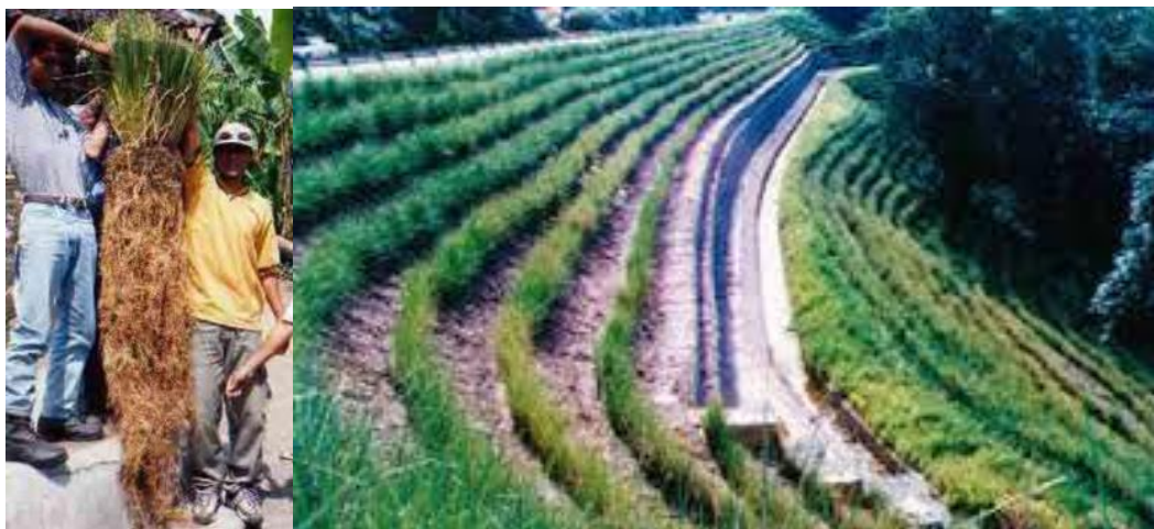
Fotografía 18. Ejemplo de bioingeniería con arbusto (vetiver) en taludes de materiales.
