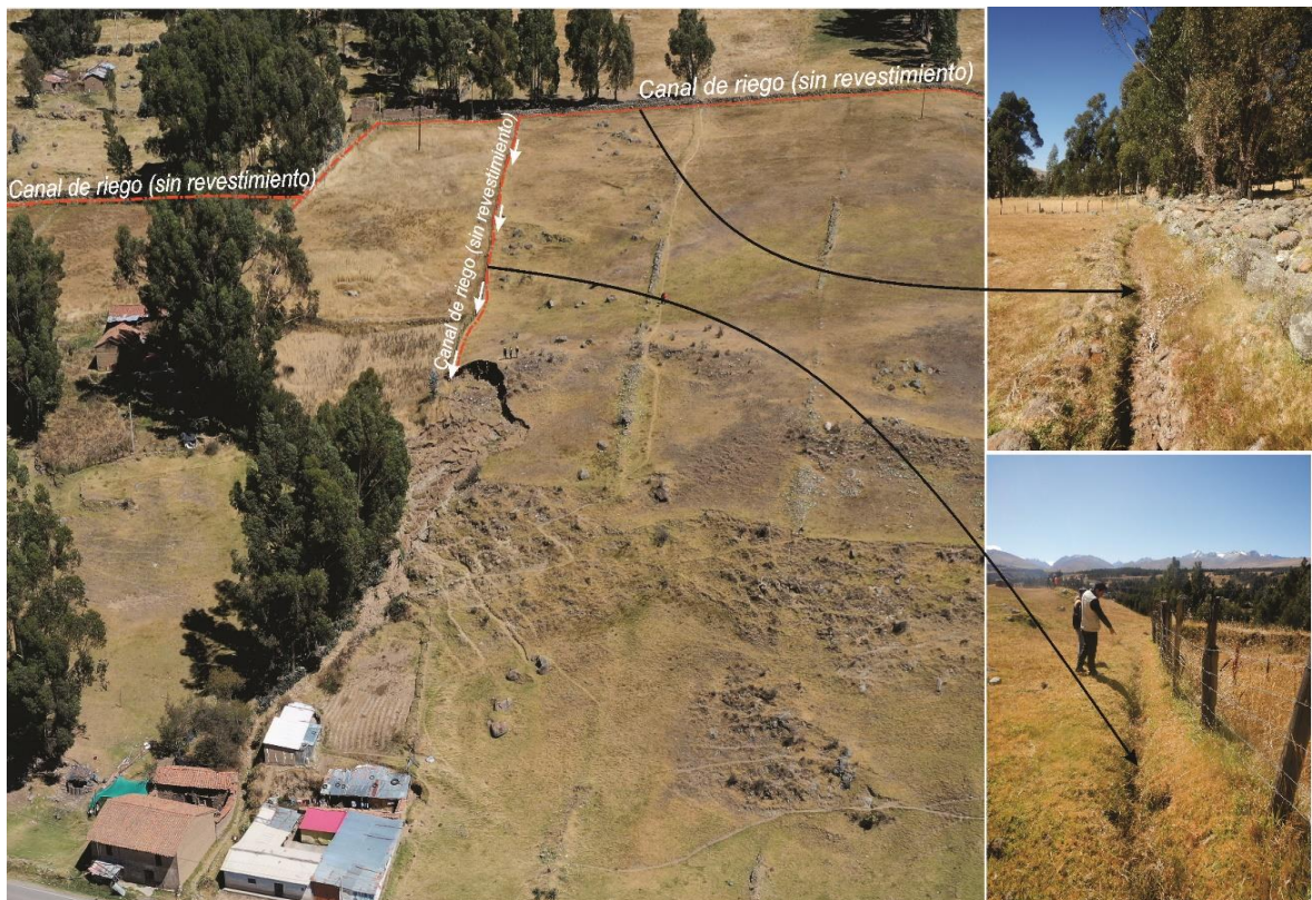
Figura 18. Vista panorámica, de canales de riego sin revestimiento (líneas de color naranja, margen izquierda), canales de tienen un ancho de 0.35 m, profundidad de 25 m
