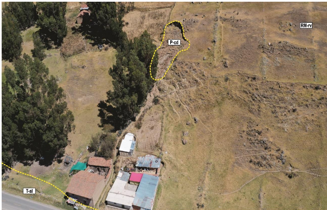
Figura 13. Vista de la subunidad de piedemonte coluvio-deluvial, próximos a las viviendas.
