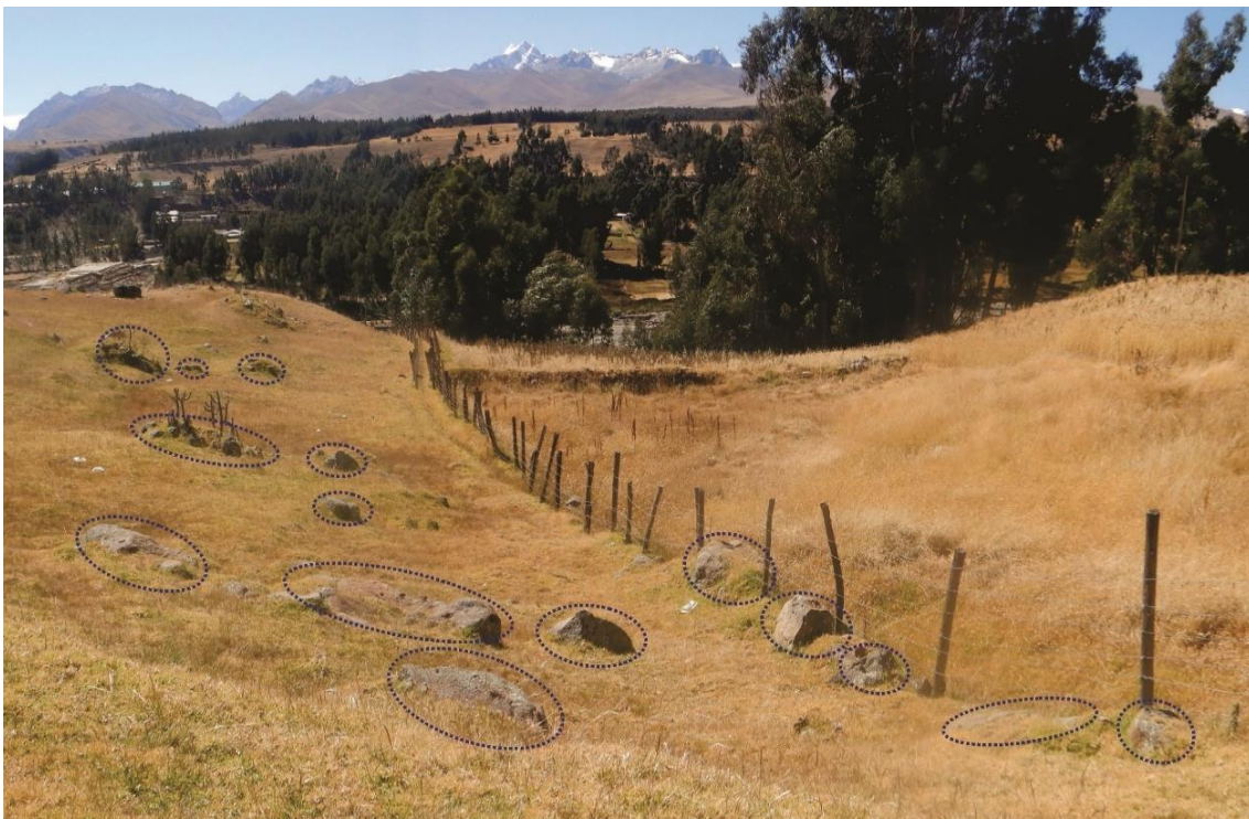
Figura 23. Bloques desplazados muy próximo a la escarpa del deslizamiento el mismo que se encuentra entre las coordenadas UTM 8916936 N, 232415 E.
