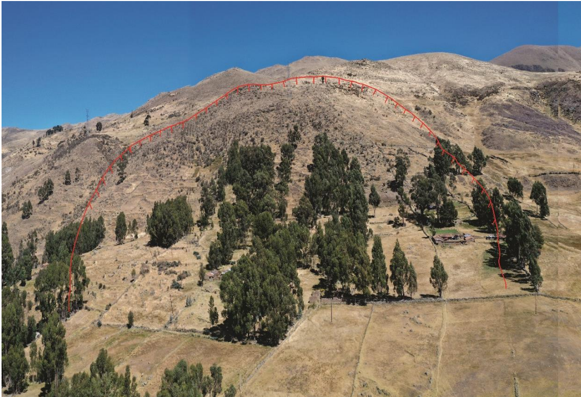
Figura 22. Vista de la escarpa de la avalancha de rocas, ubicada en la parte alta del centro poblado de Parco.
