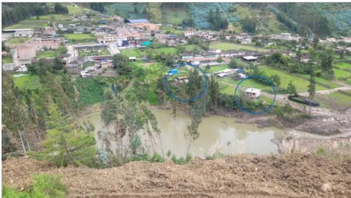
Figura 21. Viviendas que pueden ser afectadas por el flujo de detritos.
