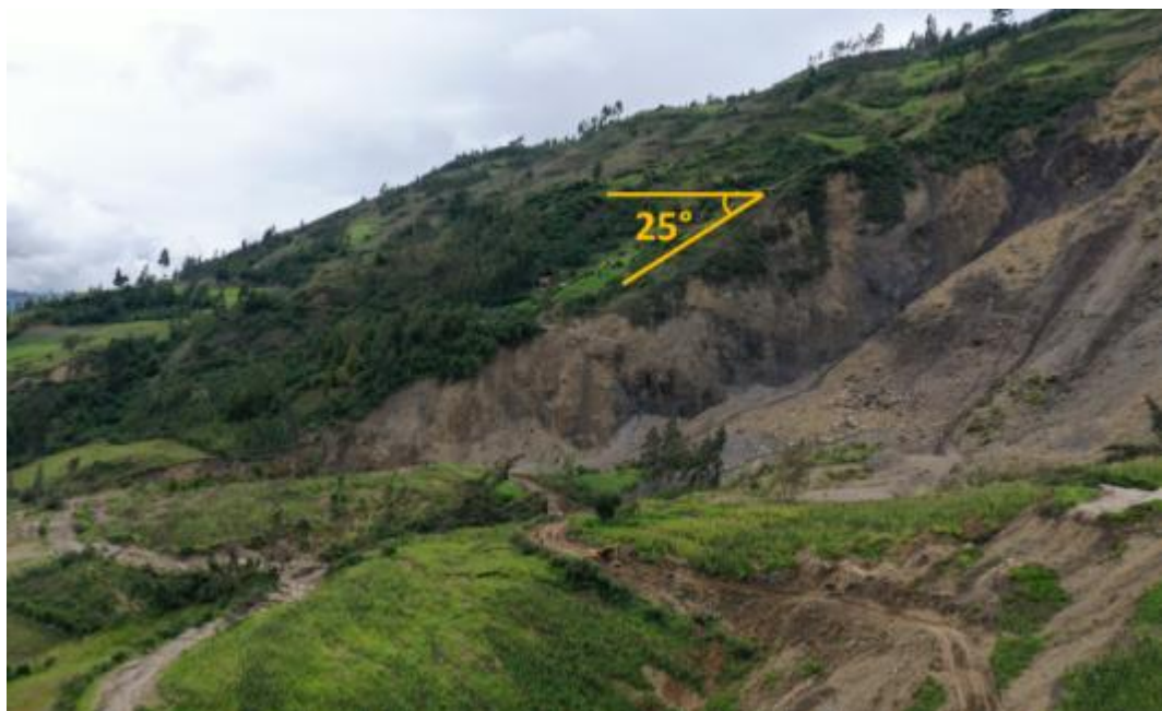
Figura 10. Laderas con pendiente fuerte, ubicadas en la parte alta del sector evaluado.
