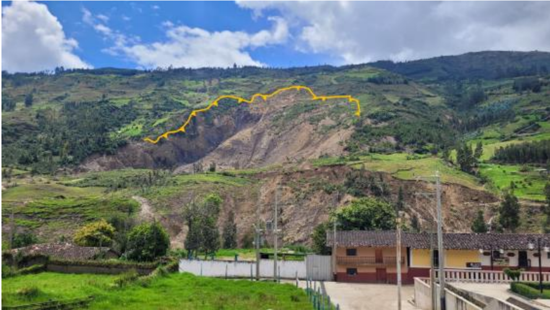
Figura 14. En la imagen se observa una vista del deslizamiento desde la zona urbana. Se distingue el escarpe principal cuya longitud es 810 m de longitud.
