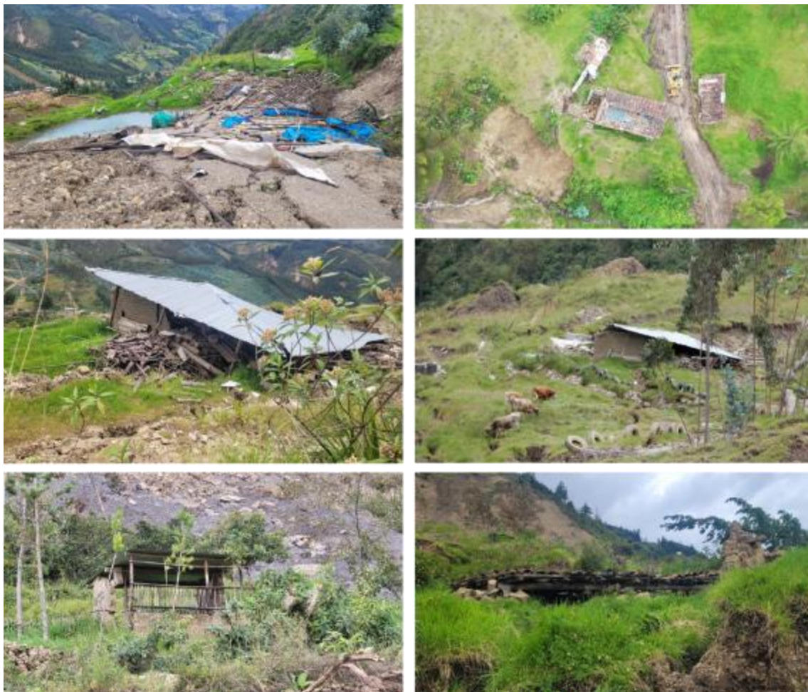
Figura 17. En las imágenes se observan 7 viviendas que han sido afectadas y se hallan dentro del deslizamiento.
