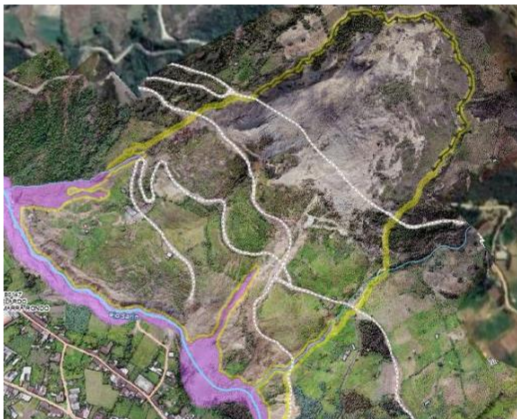
Figura 12. Vista del deslizamiento cuya extensión horizontal es de 450 m. Se visualiza los tramos de vías que cortan el talud (línea negra discontinua).
