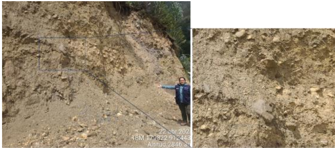
Figura 7. Depósito coluvio - deluvial, ubicado en la zona de deslizamiento en Sarín.
