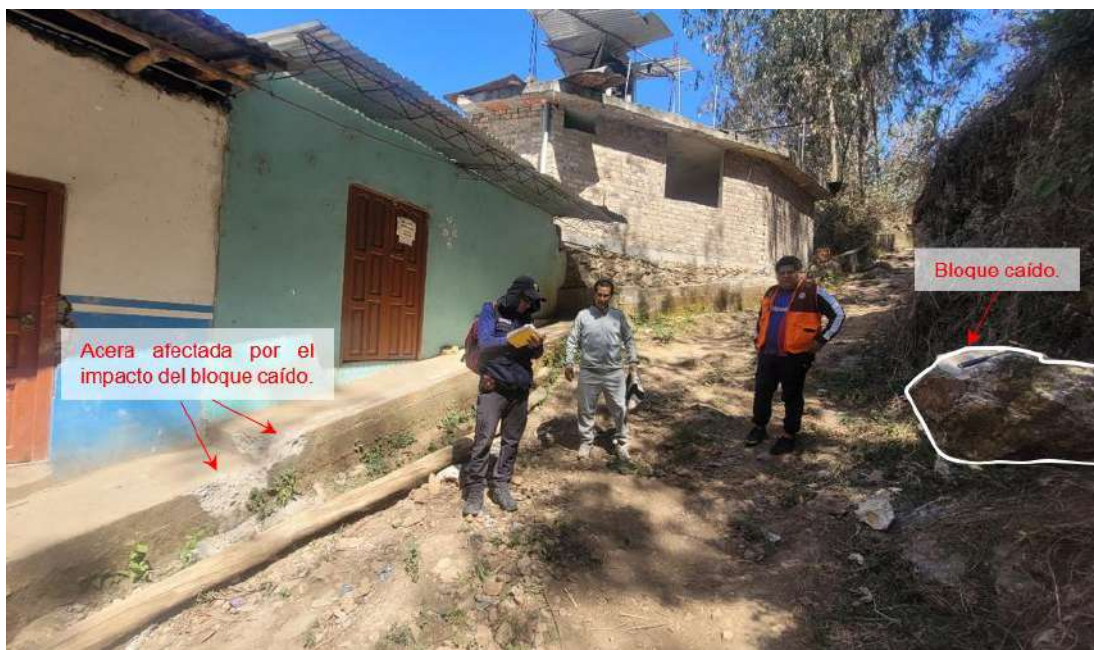
Figura 6. Bloque que afectó acera, la caída de las rocas suspendidas en la ladera, podrían afectar las viviendas ubicadas en la parte baja.
