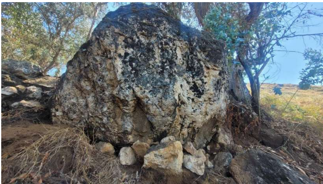
Fotografía 7. Se observa la erosión en la base del bloque. Ubicación: E 741003 y N 9213376.
