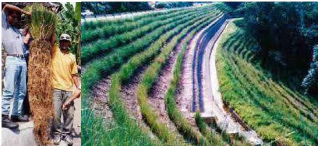
Fotografía 9. Ejemplo de bioingeniería con arbusto (vetiver) en taludes de materiales
