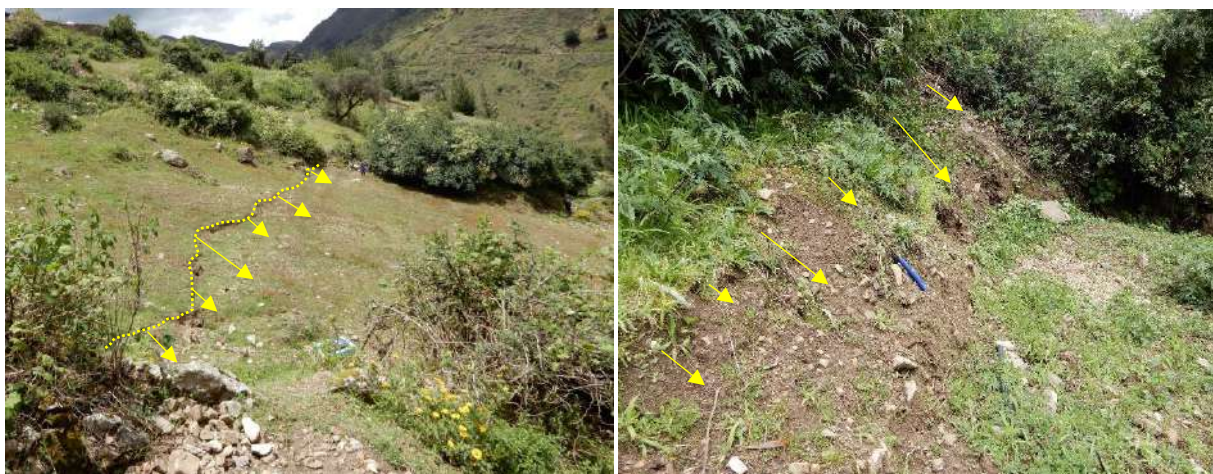
Figura 6. Desplazamientos de 30 cm a 60 cm en el cuerpo del deslizamiento inactivo latente.
