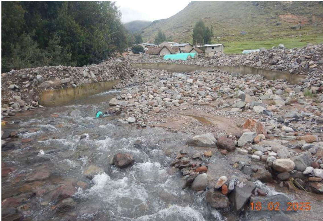
Fotografía 1: Vista aguas arriba de la quebrada Totora, que muestra todo el material detrítico, reactivado en marzo del 2024 y viviendas colindantes a la quebrada.
