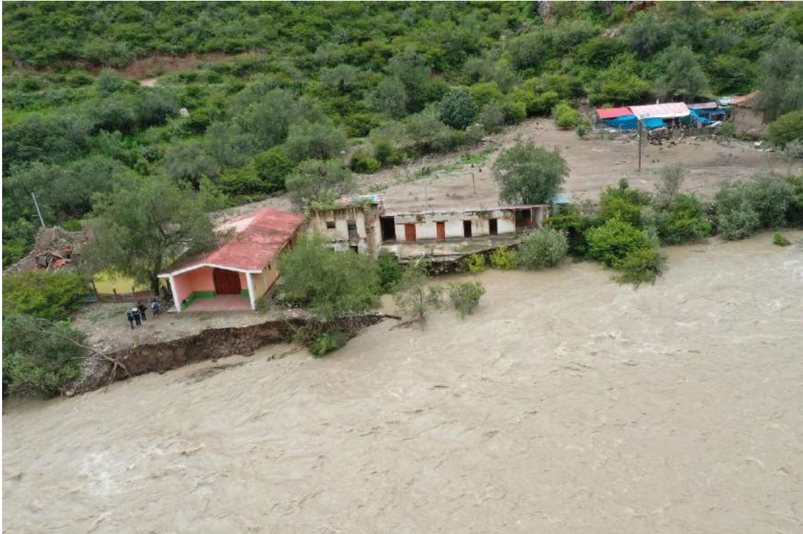
Fotografía 29: sector Chismapampa, afectado por erosión fluvial de la margen derecha del río Chaluancal; afectó tierra adentro en 8 a 10 m. aprox. Se observa viviendas deshabitadas, excepto la iglesia que sigue siendo utilizada para sus liturgias.
