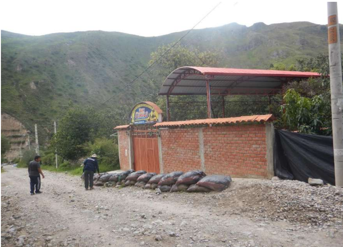
Fotografía 42: Como medida correctiva, se observan sacos terrosos posterior al huaico sucitado el 11 de febrero del 2025, cabe mencionar que estas fueron instaladas por los pobladores.
