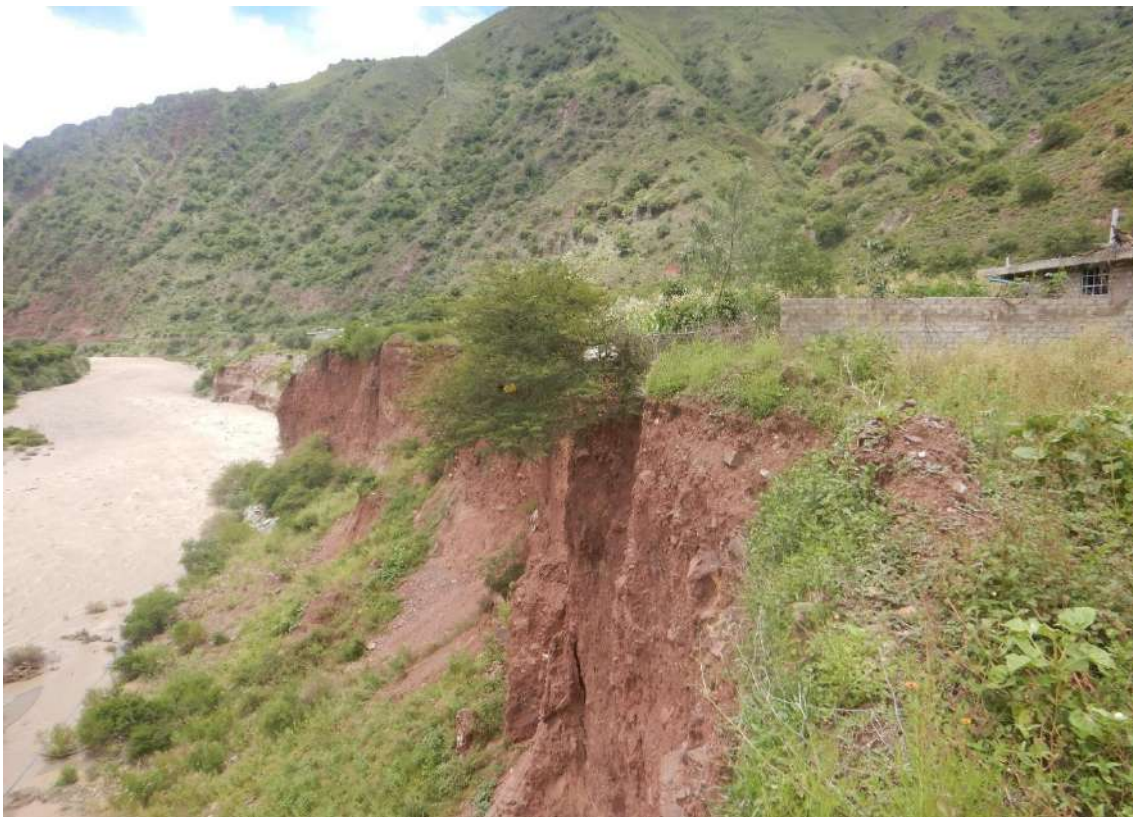
Fotografía 46: Entre las coordenadas n 8454255 E 699250 se observaron 9 viviendas ubicadas en la margen derecha a menos de un metro, 5 de estas han sido deshabitadas por precaución.
