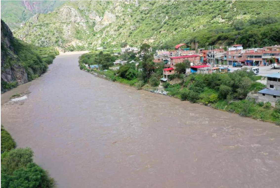
Fotografía 43: Erosión fluvial en la margen derecha del río Chalhuanca, podría afectar 8 viviendas, 2 de ellas se encuentra menos de 2 m del cauce del río, así como 3 postes de tendido eléctrico.
