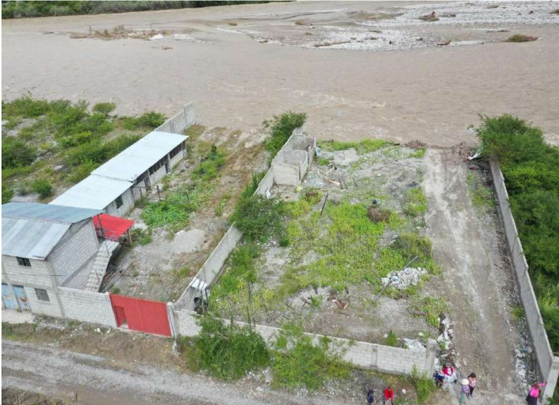
Fotografía 39: Erosión fluvial en la margen izquierda del río Chalhuanca, en este punto el evento destruyó una vivienda, y en la vivienda contigua una cocina y huerto; afecto tierra adentro 50 metros de la terraza.
