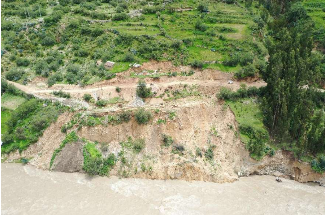
Fotografía 13: Vista del deslizamiento rotacional en el sector Chiripata (C.P. Chuquinga), el cual fue condicionado por el socavamiento del río Chalhuanca al pie de ladera y acontecido en febrero del 2024.
