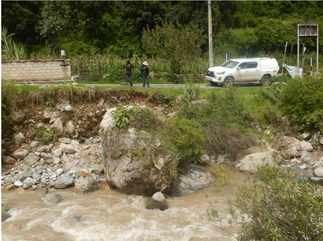
Fotografía 49: Erosión fluvial en un tramo de 10 m; bloque de 4.5 m de diámetro aprox. en el cauce del río Lucre; próximo al puente de acceso a Lucre – Nuevo Lucre.
