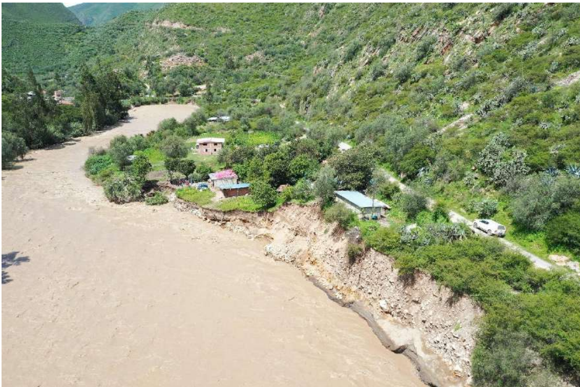
Fotografía 18: Viviendas asentadas sobre la terraza aluvial (margen derecho del río, sector Accopampa) en peligro, de continuar con el proceso erosivo del río Chalhuanca.
