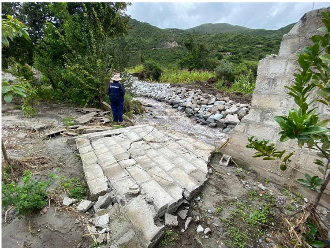
Fotografía 35: Muro de vivienda colapsada producto del huaico, el mismo que permitió el desfogó del material desplazado.
