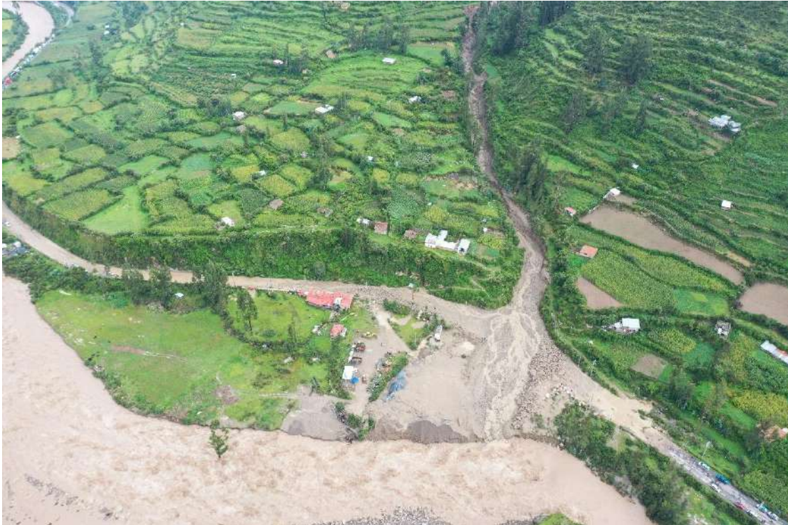
Fotografía 9: Vista panorámica del depósito en forma de abanico, dejado por el flujo de detritos del 19 de febrero, el cual obstruyó la vía nacional en aproximadamente 300 m lineales. Referencia: Progresiva 339+200, sector Huatercuya.
