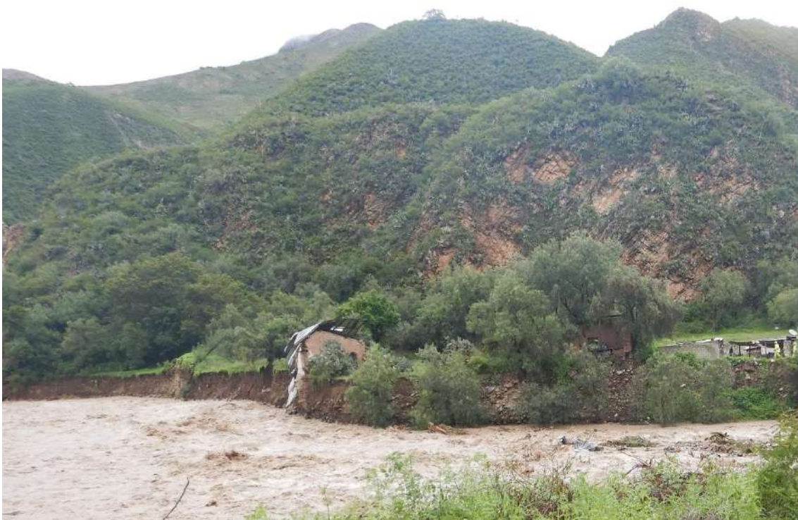
Fotografía 16: Vivienda ubicada al borde del margen izquierdo del río Chalhuanca, el cual, fue destruida por el aumento del caudal, el día 20 de febrero.
