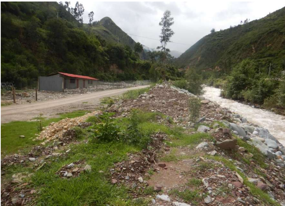
Fotografía 48: Flujo de detritos que afectó principalmente la margen derecha del río Lucre; erosión de 30 m del cauce afectando una piscigranja y vivienda. Se puede visualizar material acarreado por el huaico.
