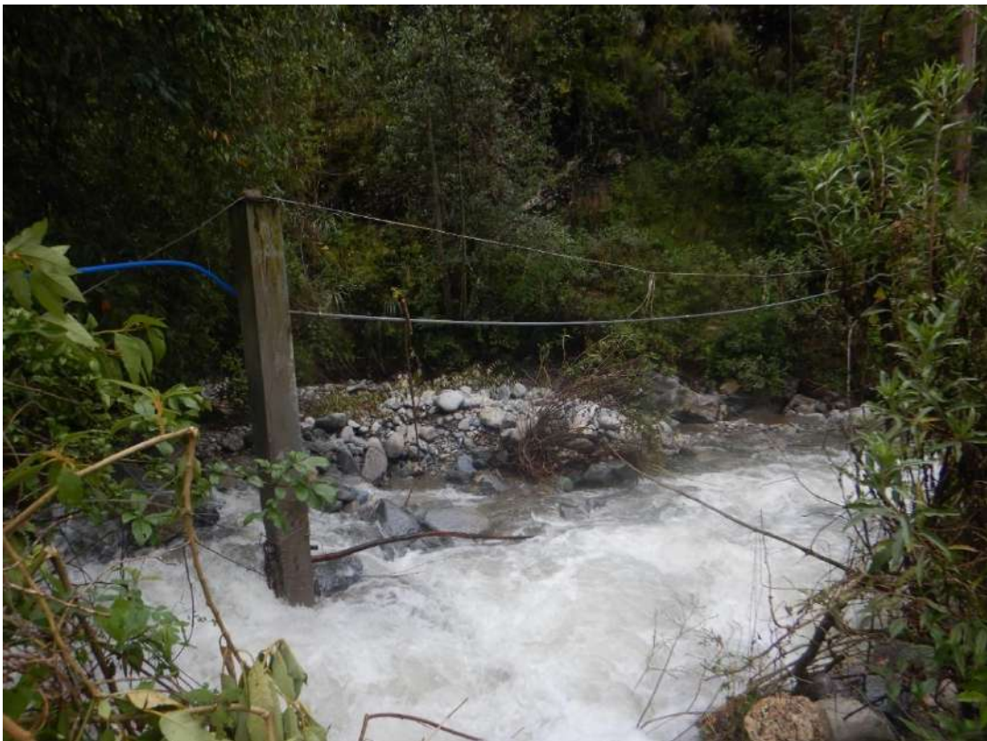
Fotografía 52: Flujo de detritos y erosión fluvial por la quebrada Ccalo que afectó puente aéreo donde cruza tubería de agua potable,
