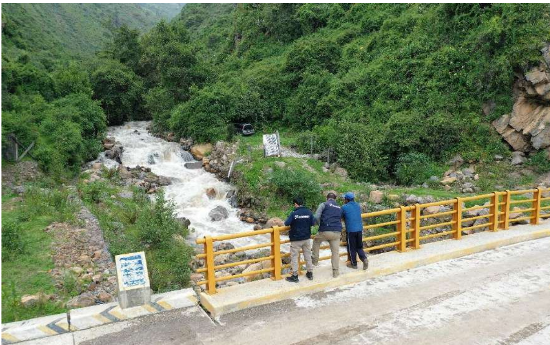
Fotografía 20: Vista aguas arriba de la quebrada Cuyo, el cual muestra el material detrítico reactivado en febrero del 2025, que destruyó 10 m de gaviones destinados para la protección del puente Chacahuaycco.
