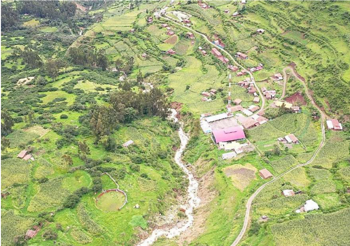
Fotografía 17: Viviendas e instituciones educativas (IEI 193, IEP 54324 Santa Rosa) de la comunidad de Ccarhuatani, asentadas en los márgenes de la quebrada Quellomayo.
