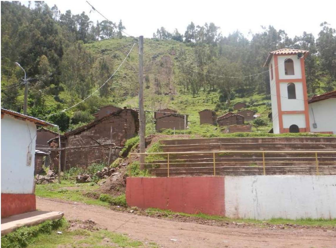
Fotografía 44: Comunidad de Pampallacta, considerado como zona crítica por deslizamiento, sobre el cuerpo del deslizamiento se están generando pequeños derrumbes – flujos. Así mismo se evidencia que algunas viviendas siguen siendo habitadas
