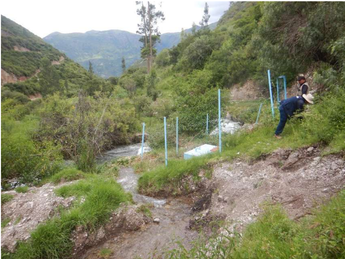
Fotografía 28: El flujo de detritos afectó la bocatoma del sector Chacapunte, ubicado a 1.5 m del río Huaccasa.
