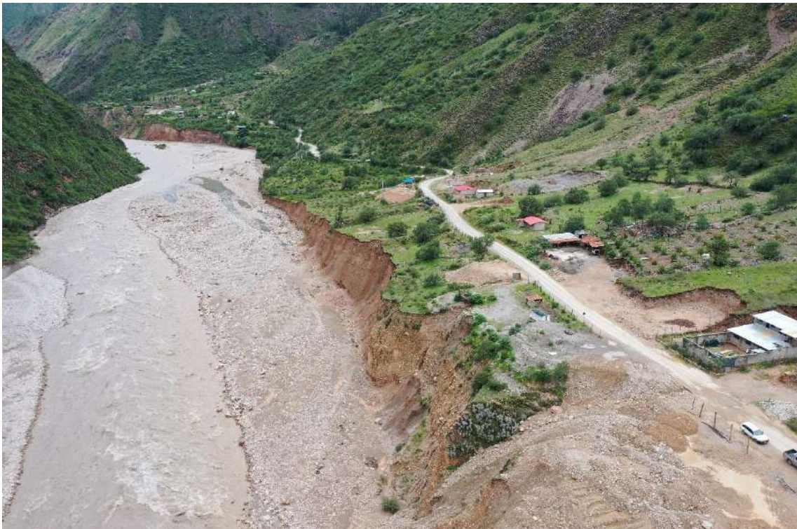
Fotografía 24: Vista del sector Tupac Amaru, afectado por procesos de erosión fluvial por aumento del caudal del río Antabamba, el cual ocasionó la pérdida de zonas de cultivo de maíz y palta en aproximadamente 0.5 ha.
