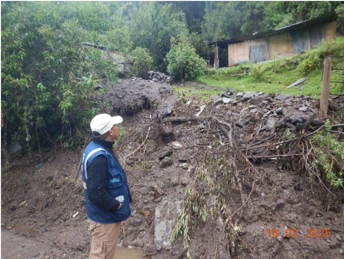
Fotografía 6: Flujo de detritos acontecido el 11 de febrero en la quebrada Sichi, el cual afectó 02 viviendas ubicadas en ambas márgenes de la quebrada.
