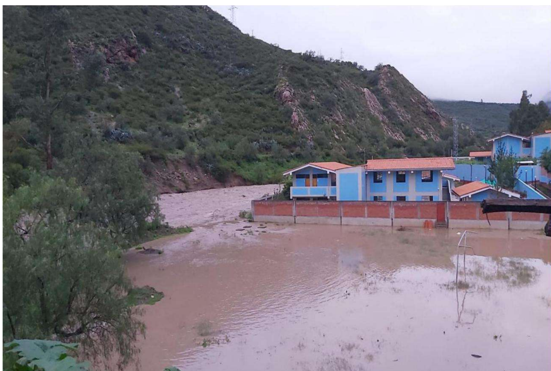
Figura 7: Inundación afectó instalaciones del colegio Horacio Zevallos Gámez, producto de las lluvias intensas y prolongadas suscitadas el 19 de febrero del 2025, el nivel del agua llegó a 20 cm y cubrió los 06 pozos de percolación y 01 pozo séptico del distrito de Capaya.
