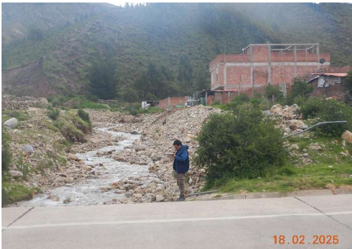
Fotografía 2: Vista aguas arriba de la quebrada Chincollana, que muestra todo el material detrítico reactivado en febrero del 2024 y viviendas colindantes dispuestas en la margen izquierda de la quebrada.
