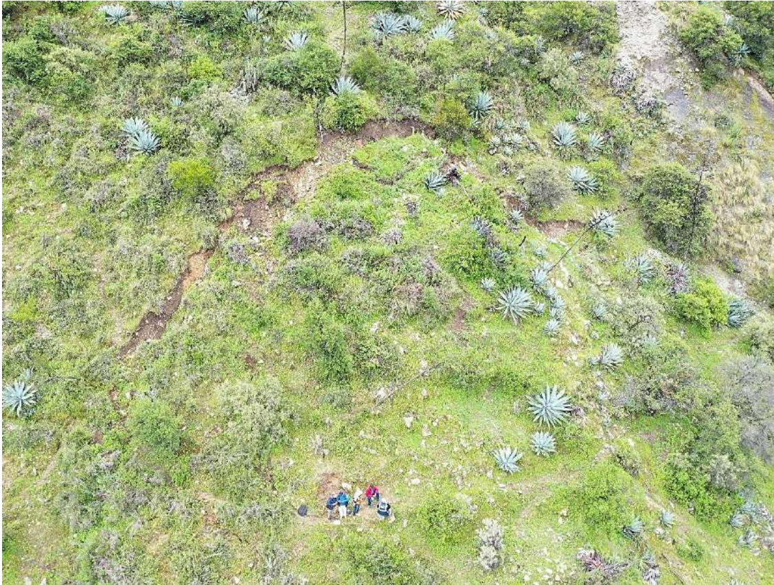
Fotografía 10: Reactivación de un deslizamiento antiguo en la margen derecha de la quebrada Molline (sector Unchiña), con un escarpe semicircular de \approx 40 m de longitud.
