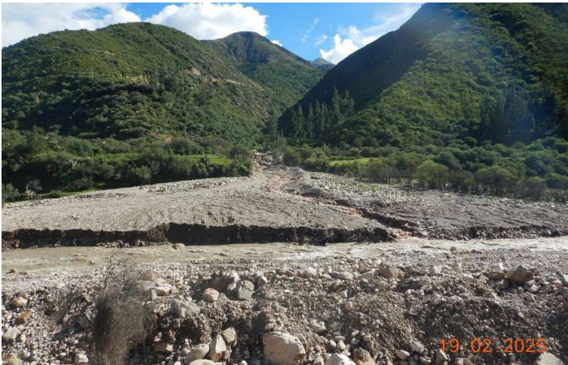
Fotografía 12: Vista de la quebrada Jayo, donde se puede visualizar el material depositado en forma de abanico, dejado por el flujo de detritos en abril del 2024 que afectó vía nacional PE-30A, en un tramo de \approx 80 m.
