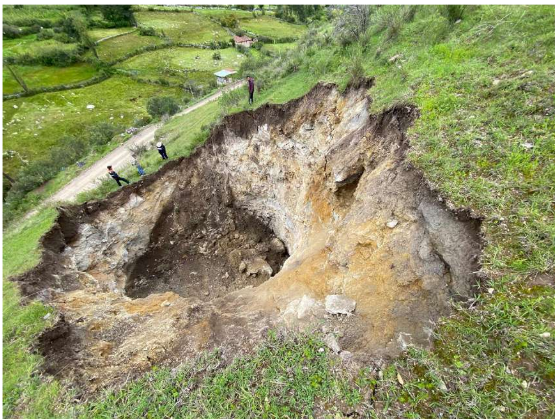
Fotografía 36: Vista del hundimiento ocurrido en el sector Jumaya, que se generó el 12 de octubre del 2024 y continúa hundiéndose en la actualidad, con las lluvias suscitadas.
