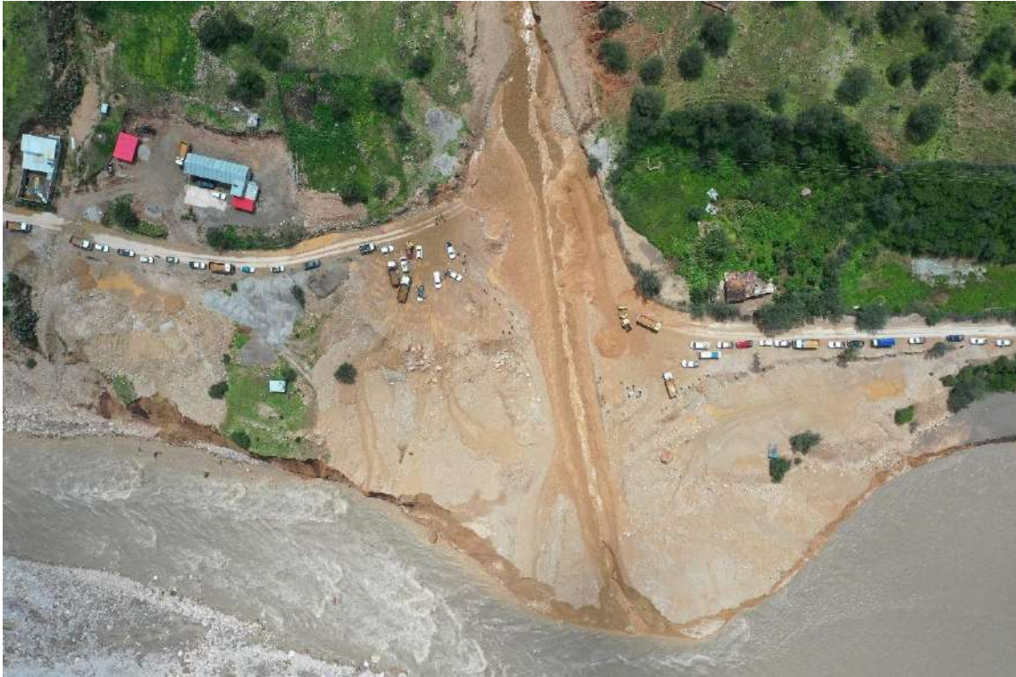
Fotografía 23: Flujo de detritos del 20 de febrero en el sector Mazupampa. En la fotografía se puede observar la depositación del material detrítico en forma de abanico y la obstrucción de la vía departamental Santa Rosa – Antabamba en aproximadamente 150 m lineales.
