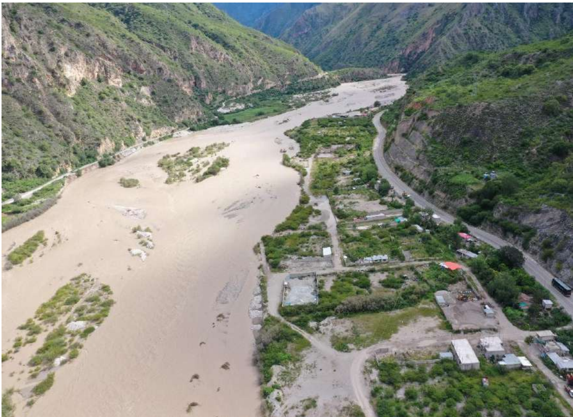
Fotografía 38: Vista panorámica donde se observa procesos de erosión e inundación fluvial a lo largo de 2100 m en la margen izquierda del río Chalhuanca (sector Auchá), afectó 81 m de ancho de la terraza fluvial, inundando 08 construcciones de concreto y 85 m de trocha.
