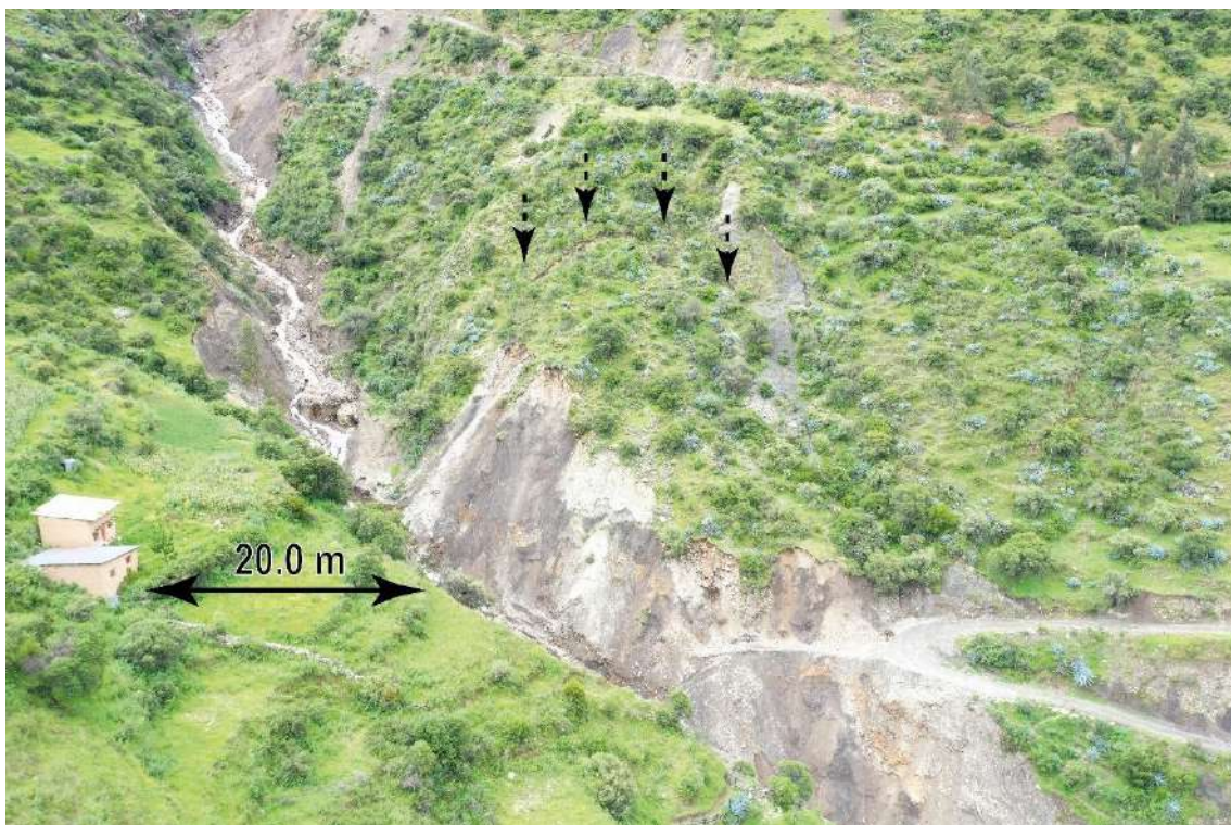
Figura 6: Vista de la quebrada Molline, donde se puede observar en flechas entrecortadas la reactivación del deslizamiento, y la ubicación de viviendas cercanas al cauce principal de la quebrada.
