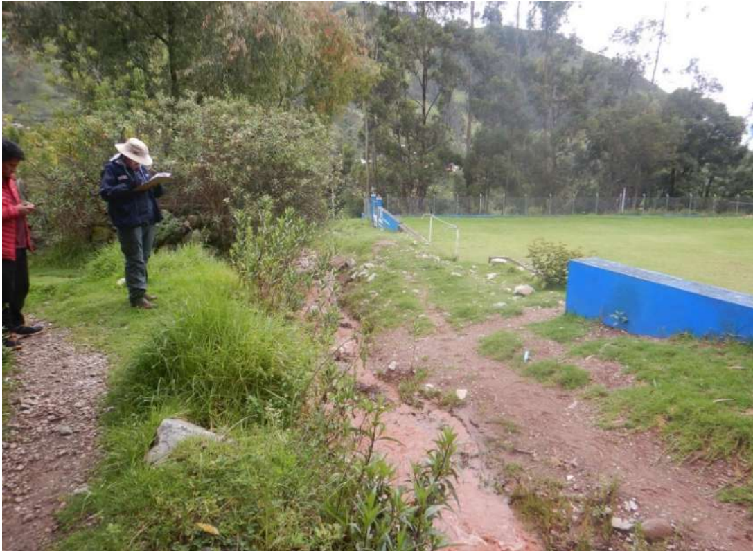
Fotografía 51: Vista de la quebrada donde se generó un flujo de detritos (huaico), posterior al evento las autoridades realizaron limpieza del cauce, para evitar afectaciones a la institución educativa y vía de acceso al poblado.
