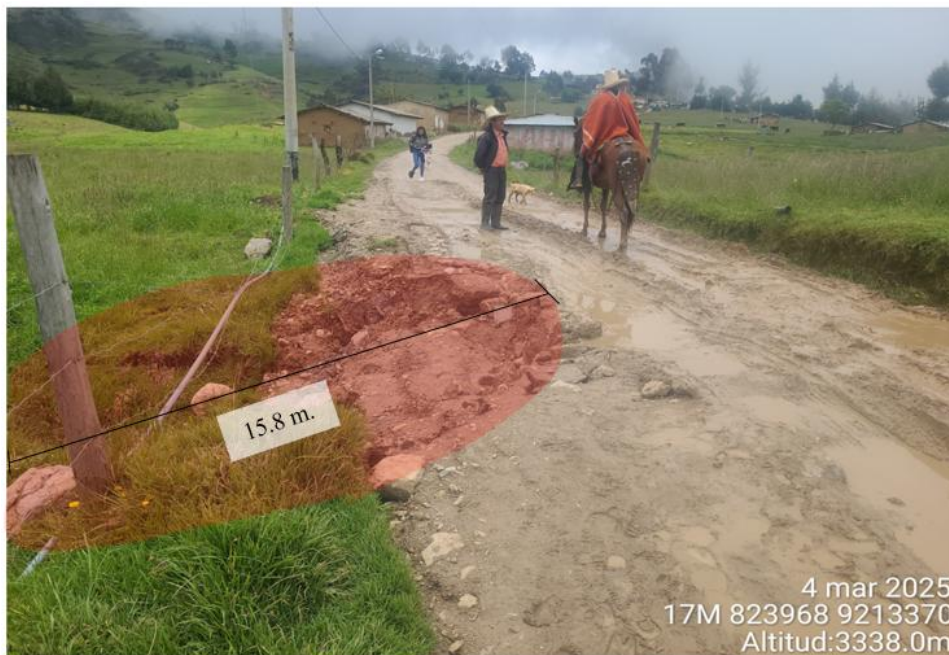
Figura 11: Hundimiento 01, ubicado al NW de la zona de estudio (E:824036 N: 9213287), con un área de 0.03 ha y 15.8 metros de diámetro.
