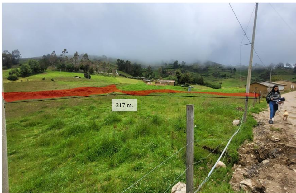
Figura 9: Hundimiento 01, ubicado al NW de la zona de estudio (E:823940 N: 9213329), con un área de 0.33 ha y 217 metros de longitud.
