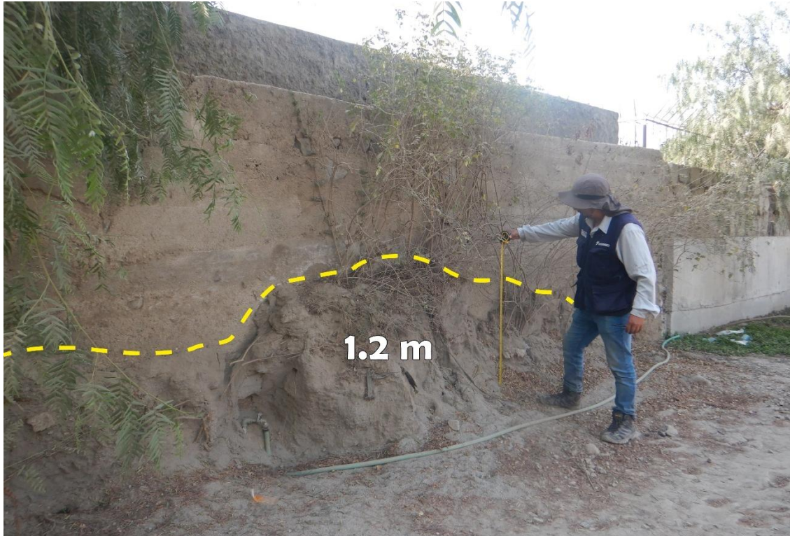
Figura 14. Altura de 1.2 m registrada en pared de vivienda a la altura de la calle Fontana, producto del último fenómeno del Ciclón Yaku, Coordenadas referenciales UTM WGS-84, 18S: E: 306738; N: 8674841.
