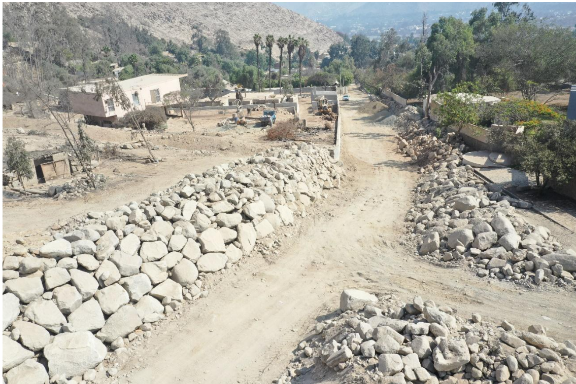
Fotografía 5. Muros de roca (enrocados) de aproximadamente 2.5 m de altura realizados de manera artesanal ubicados en la desembocadura de la quebrada Cusipata. Coordenadas referenciales UTM WGS-84, 18S: E: 306975; N: 8674608.
