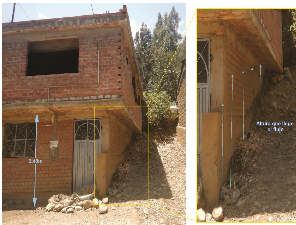
Figura 17. En la actualidad se visualiza la altura a la que llego el flujo, teniendo en referencia que la la frontera de la vivienda tiene una altura de 2.45 m; se evidencia bloques de 25 a 45 cm.
