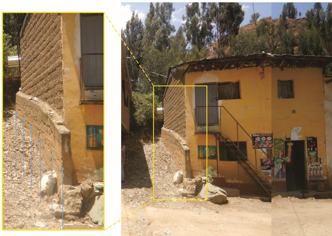
Figura 18. Vista de vivienda de adobe de dos pisos, ubicado en la margen izquierda de la quebrada S/N, el cual cuenta con un muro de contención de concreto de 7 m. longitud, 1.6 m. alto.
