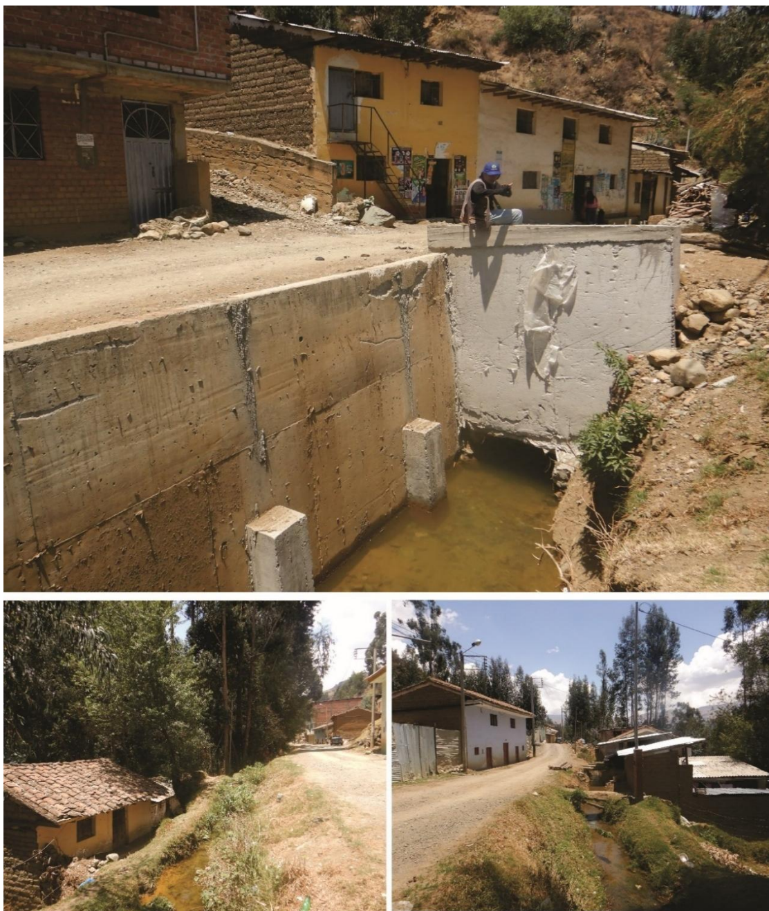
Figura 19. Canal de riego sin revestimiento, ubicado entre la vía, a 5 m de las viviendas y postes de tendido eléctrico, en un tramo del canal de riego el cual fue afectado por el huaico, se construyó un muro de concreto. Metros abajo se observa que algunas viviendas cuentan con pases de madera de acceso vehicular a sus viviendas
