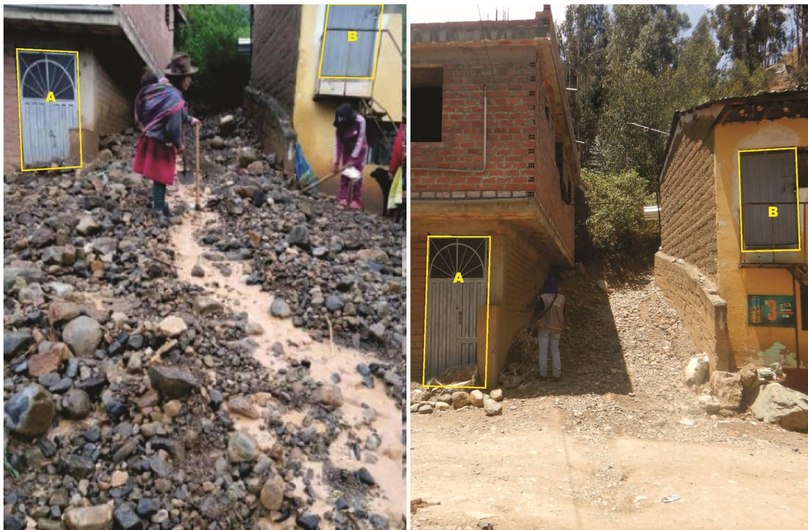
Figura 15. Vista donde de la quebrada reactivada el 25 de diciembre del 2023, según información del Diario Santo Domingo (lado izquierdo de la imagen), donde se evidencia el material removido desde la parte alta de la quebrada; así mismo se observó que el huaico llegó a 1.80 m según los rasgos evidenciados en las paredes de las viviendas ubicadas en sus márgenes, a lado derecho de la imagen actual de la quebrada, donde se observó que la quebrada había pasado por un proceso de limpieza de la quebrada y la vía.
