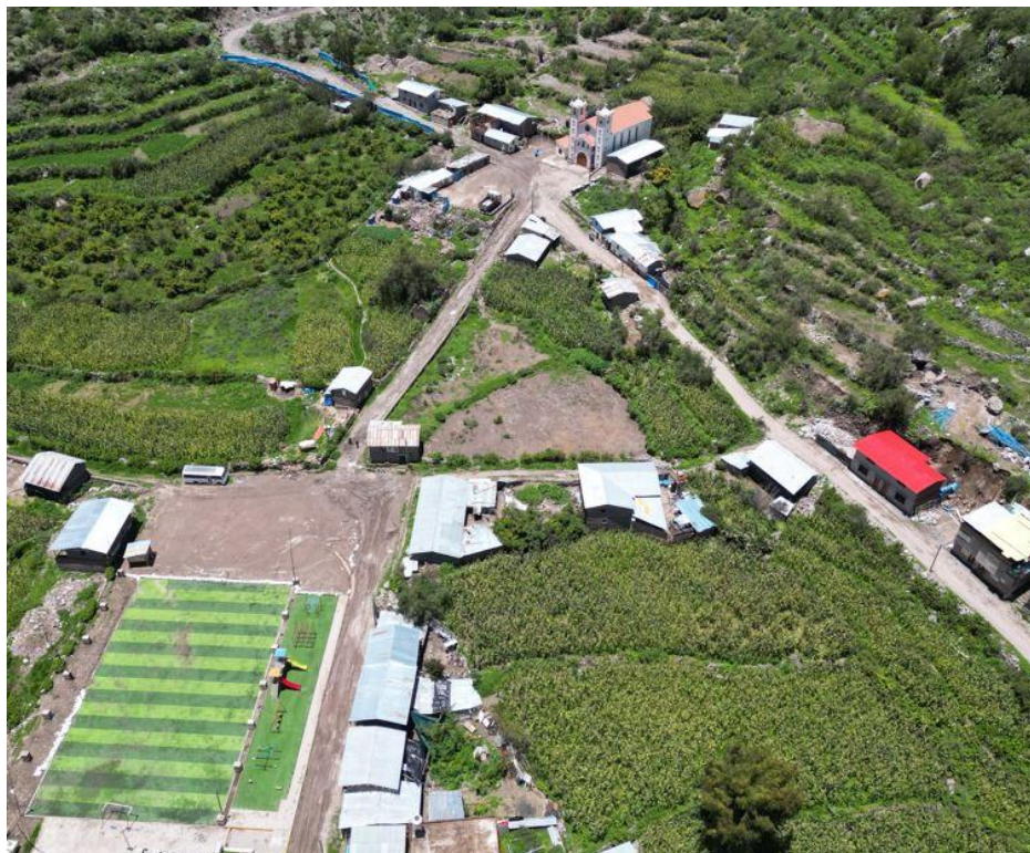
Fotografía 28. Afectación del flujo de detritos al distrito de Tauria.
