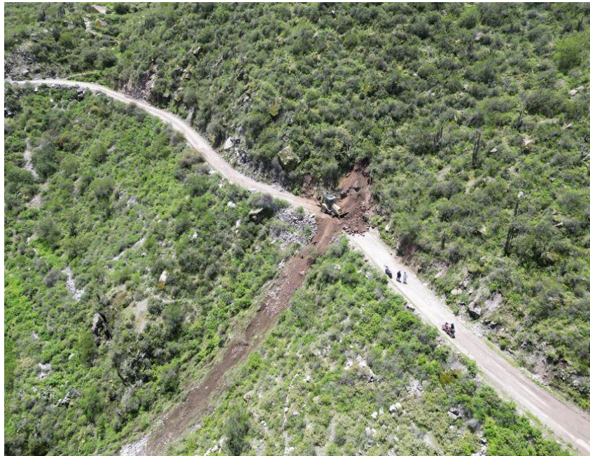
Fotografía 27. Obstrucción de la carretera de Sayla a Tauria por derrumbe.
