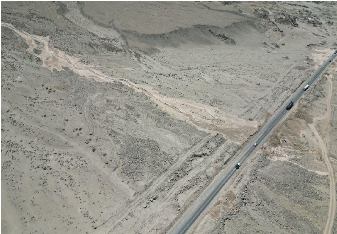
Fotografía 12. Trazo dejado por el flujo de detritos en el km 691, sector de Chorrillos - Atico. Asimismo se diferencian abanicos de flujos de detritos pasados que comprometen un tramo mayor de la carretera.
