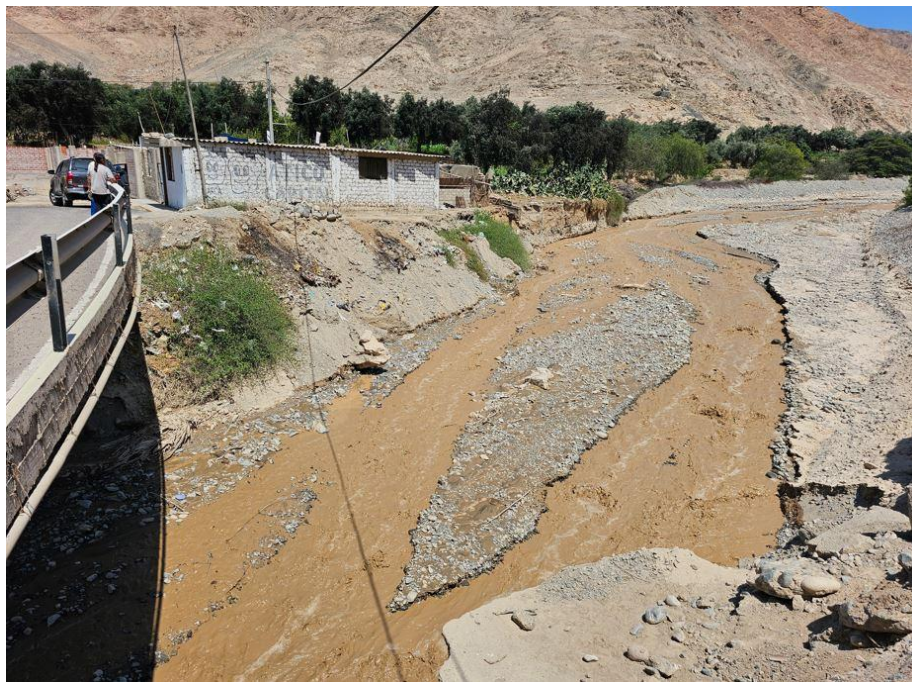
Fotografía 8. Flujos de detritos en las inmediaciones de la quebrada de Atico Antiguo.
