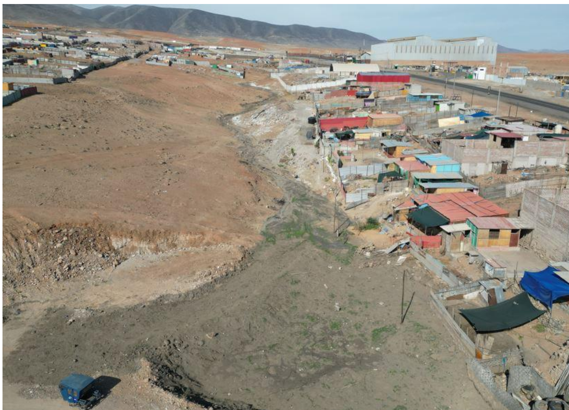
Fotografía 4. Flujos de detritos en las inmediaciones de la quebrada Matarani, ocurrido el 11 de febrero y afectó la Asociación de Vivienda de Alto Matarani.
