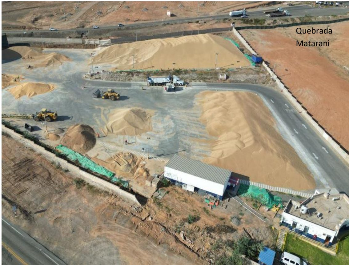
Fotografía 5. Flujos de detritos que afectó a infraestructuras.
