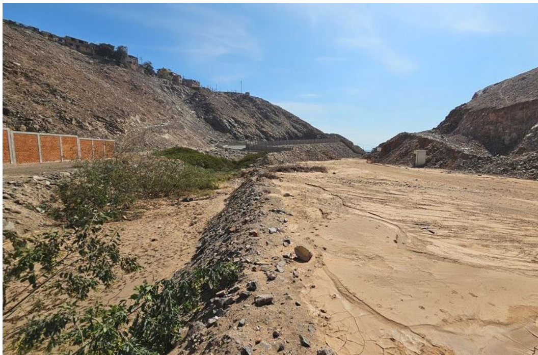
Fotografía 2. Quebrada Matarani, por donde discurrió un flujo de detritos el 11 de febrero 2025.
