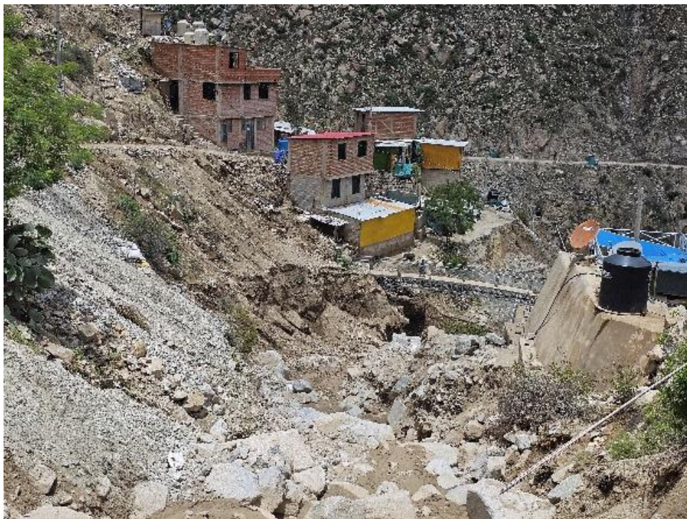
Fotografía 22. Sector de Base Rey, Cerro Rico, donde se emplazó un flujo de detritos.
