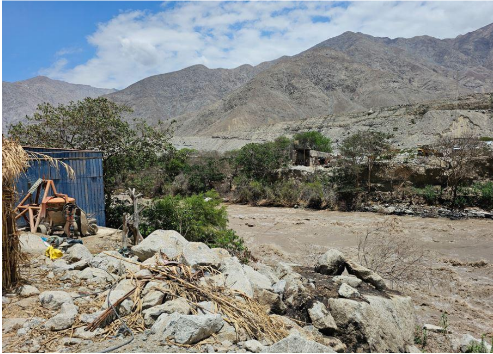
Fotografía 15. Aumento del caudal del río Ocoña que afectó la carretera en dirección a Chaucalla.
