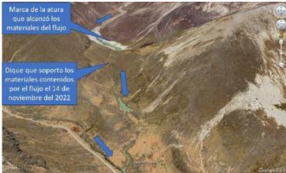
Figura 11. Imágenes del dique natural de más de 30 m que podría romperse con eventos futuros sumado a la escorrentía superficial que presenta, imagen tomada de Google Earth.
