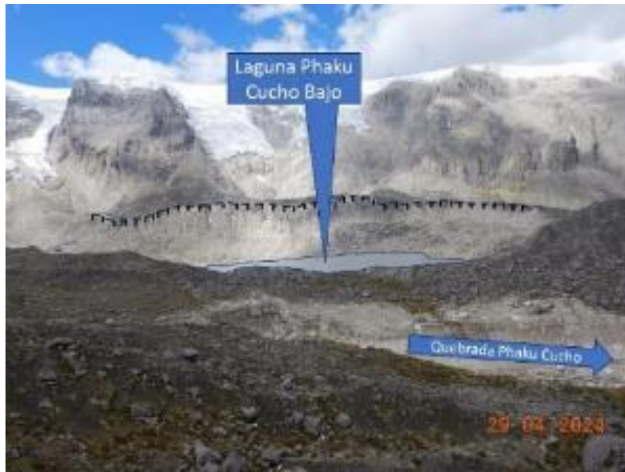
Figura 13. En la margen izquierda de la laguna Phaku Cucho Bajo se aprecia la zona de arranque de un derrumbe inactivo latente el cual podría llegar a la laguna.
