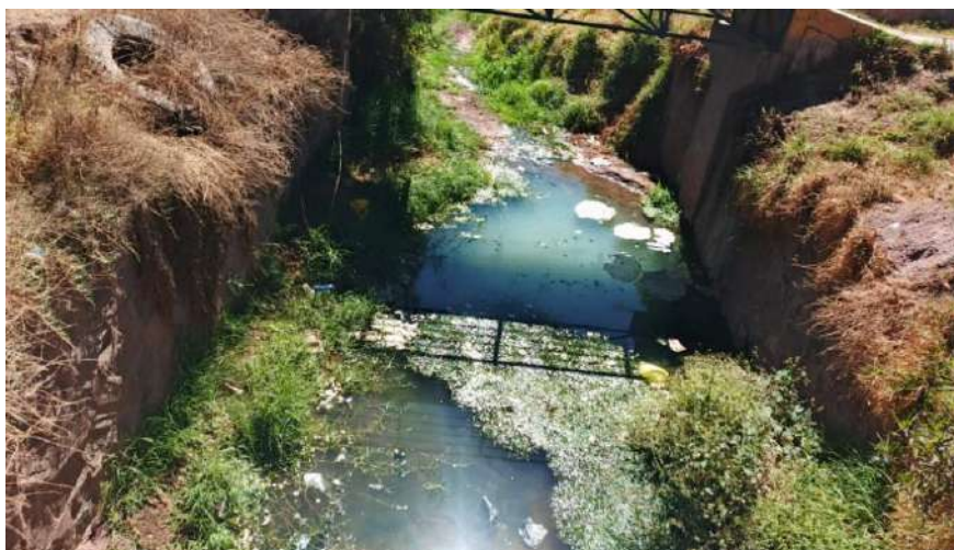
FOTOGRAFÍA 2: CANAL DE RIEGO AFECTADO POR RESIDUOS Y DESMONTE EN EL SECTOR DE CHINGO
