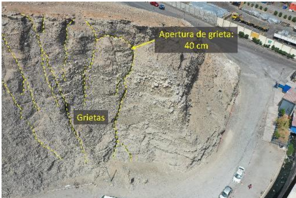
Figura 9. Sistema de grietas (líneas amarillas) y aperturas de hasta 40 cm. en el sector Muelle Pesquero Matarani.
