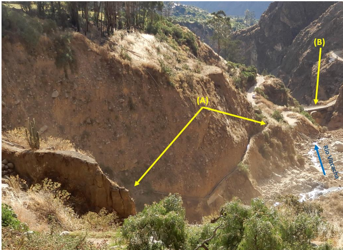
Figura 23. (A): Muestra parte del canal de regadío, en la margen izquierda del río Vizcacha. (B): Puente que une Huaytará con Quito Arama.
