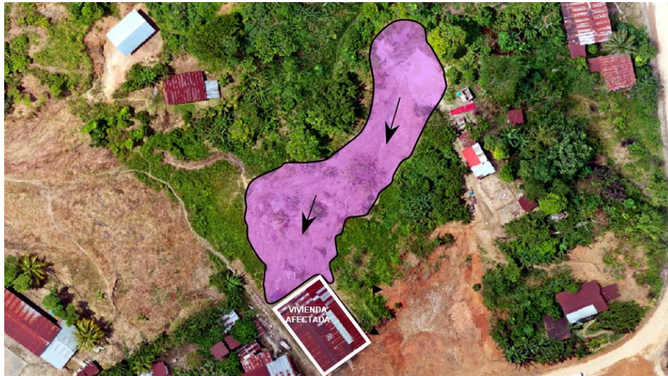
Figura 12. Se delimita la zona de flujo de detritos (en violeta).
