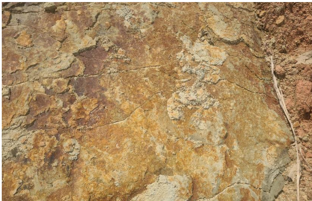
Fotografía 1. Limolitas de coloración rojiza a amarillentas, medianamente fracturada, moderadamente meteorizada.
