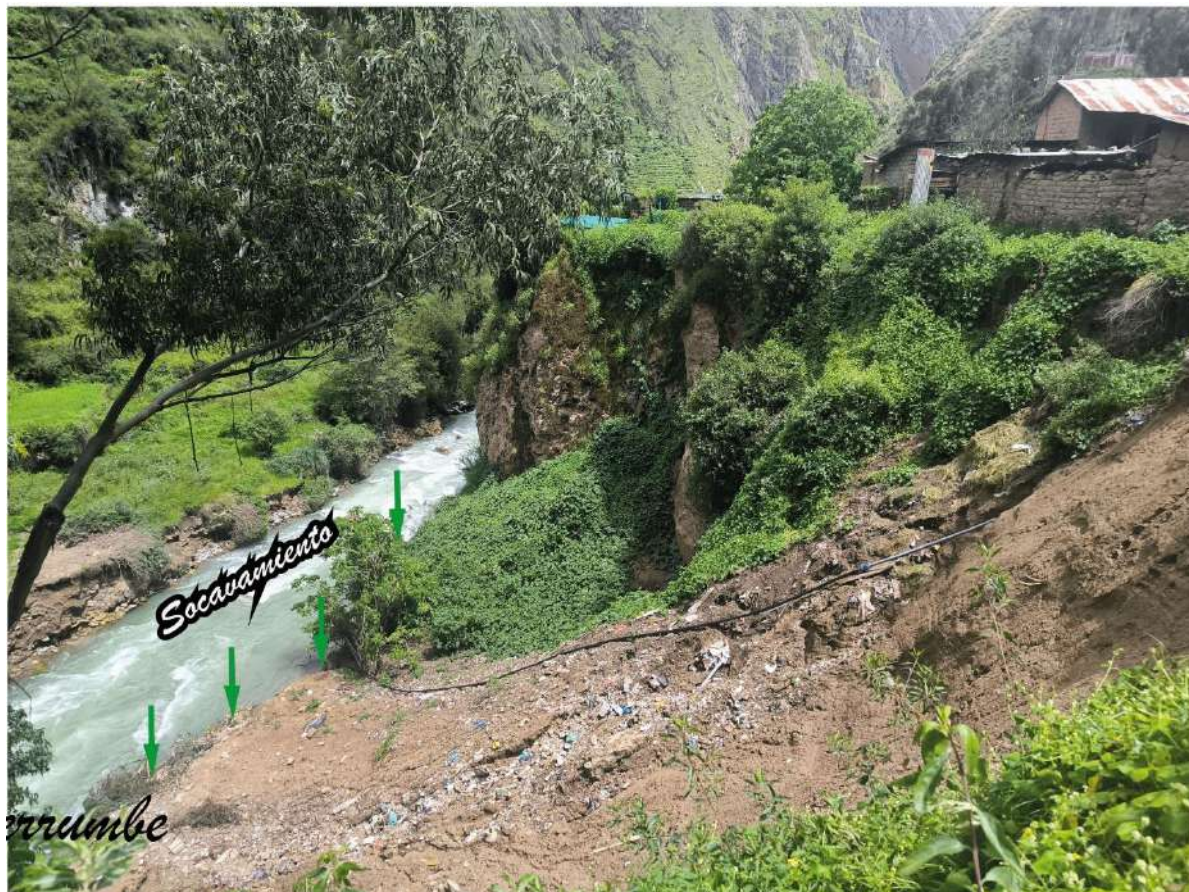
Figura 19. Vista del proceso de socavamiento en el sector Alis, que habría sido parte condicionante de la ocurrencia del mismo.
