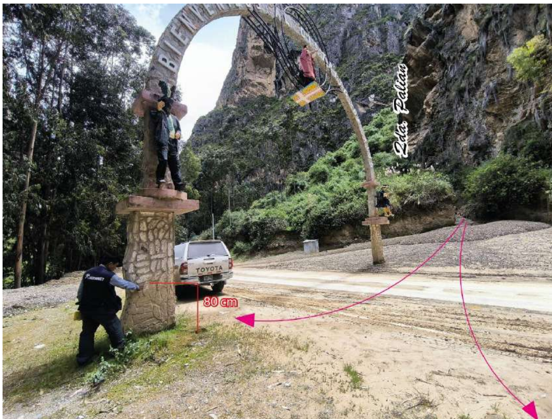
Figura 16. Flujo de detritos en el sector 3; donde se puede distinguir en el muro la altura alcanzada por el flujo.
