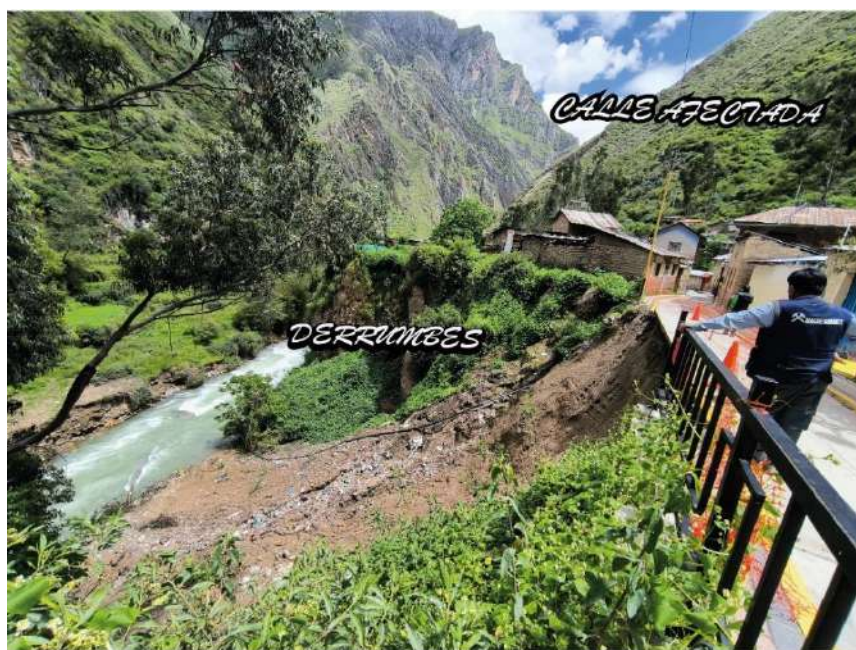
Figura 18. Vista general del derrumbe en el centro poblado Alis.
