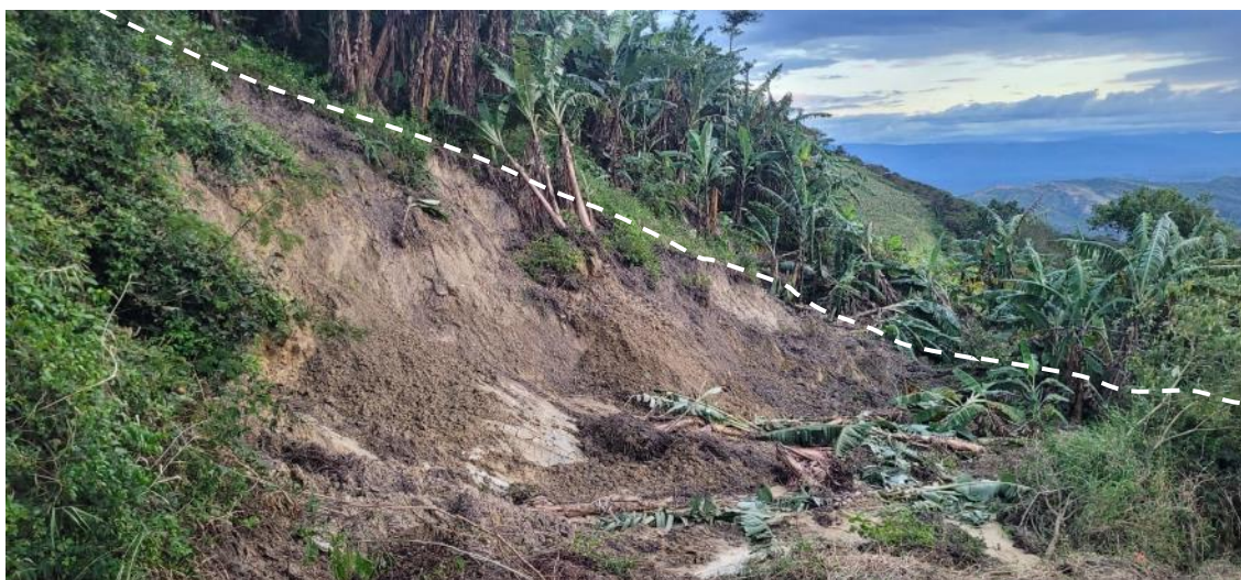
Figura 19. Escarpe de deslizamientos rotacional activo DR-aM2 en el caserío Mel.
