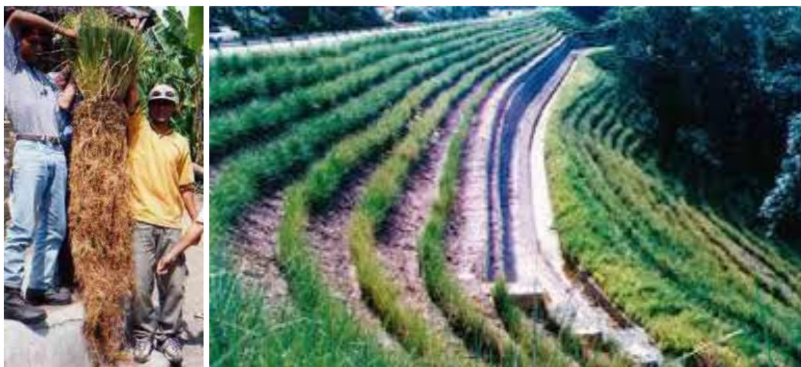
Figura 28. Ejemplo de bioingeniería con arbusto (vetiver) en taludes de materiales sueltos.
