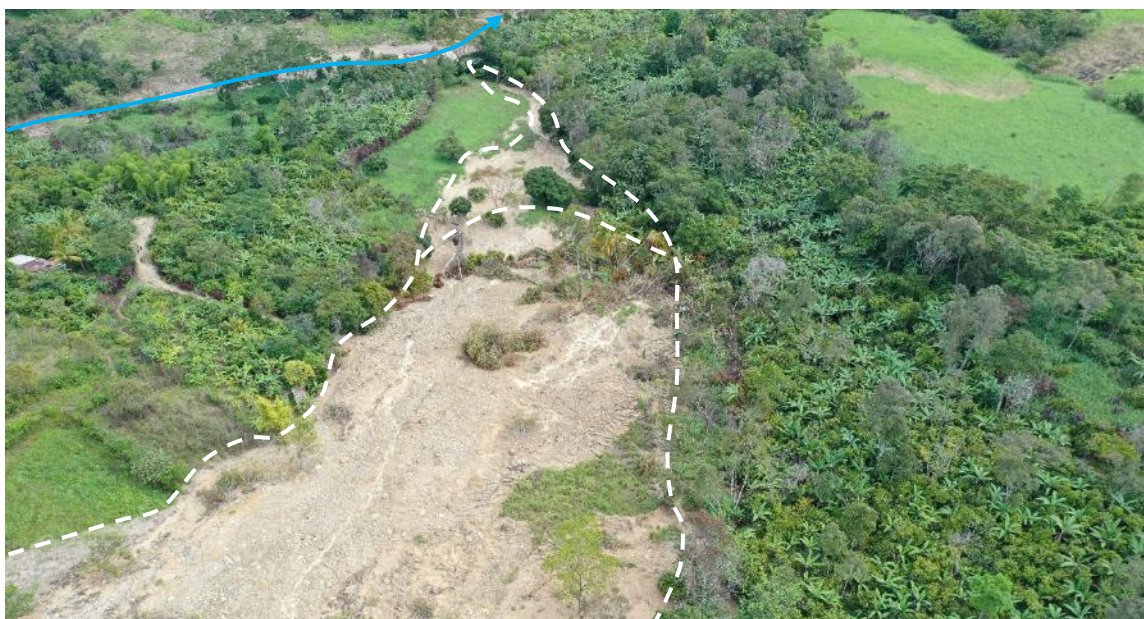
Figura 6. Vista de los depósitos coluviales originadas por el deslizamiento en el CP. Churiaco.
