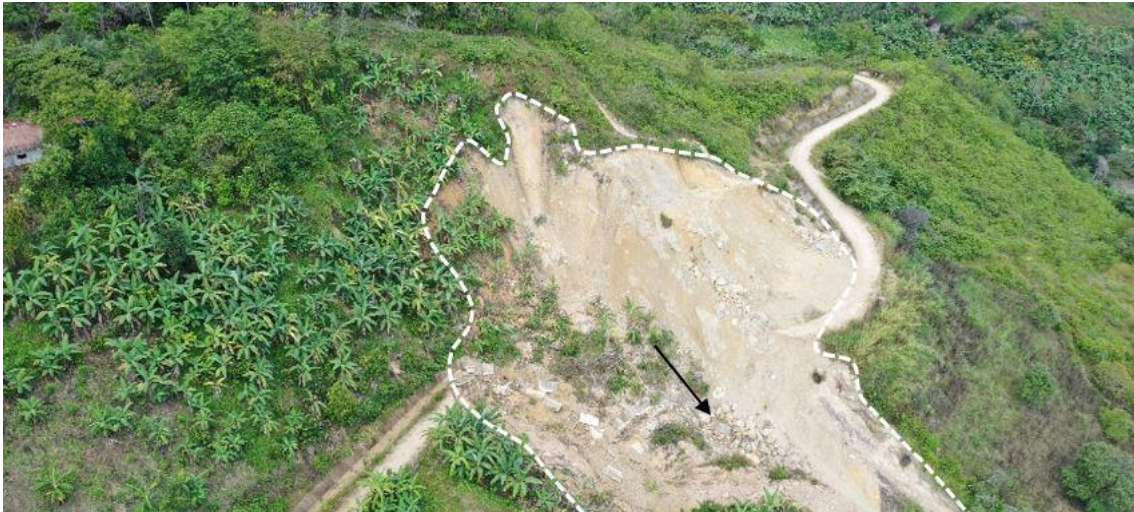
Figura 13. Vertiente con depósito de deslizamiento en el caserío Churiaco.
