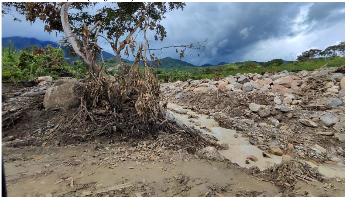
Fotografía 8. Tramo de 55 m de la vía de acceso del caserío Churiaco hacia Nueva Florida, afectado por flujo de detritos.
