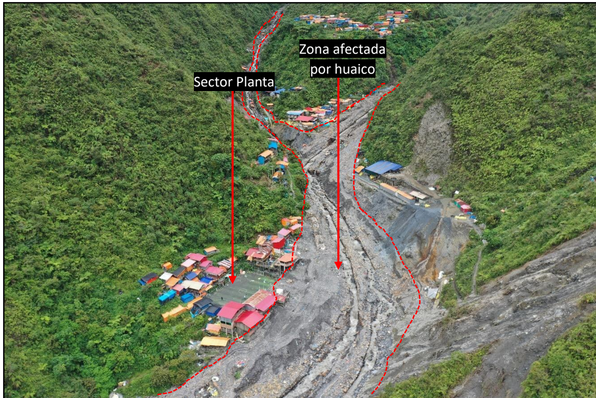
Figura 6. Cauce de la quebrada en el sector Planta.
