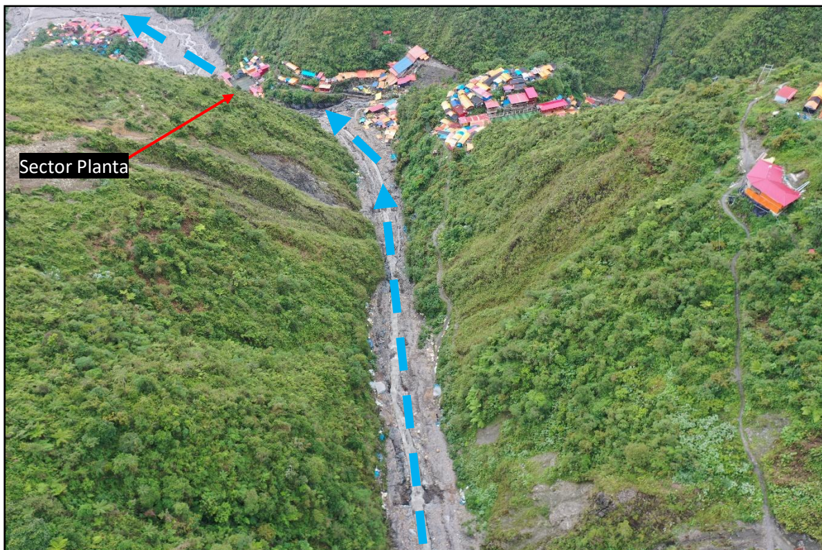
Figura 9. Quebrada Buena Vista, por donde descendió el flujo el principal flujo de detritos. al fondo se ve el sector Planta.
