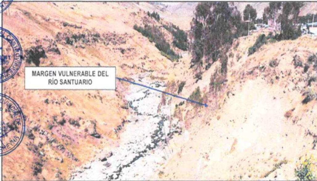
Fotografía 04: Tramo crítico por erosión fluvial en el río Santuario.
