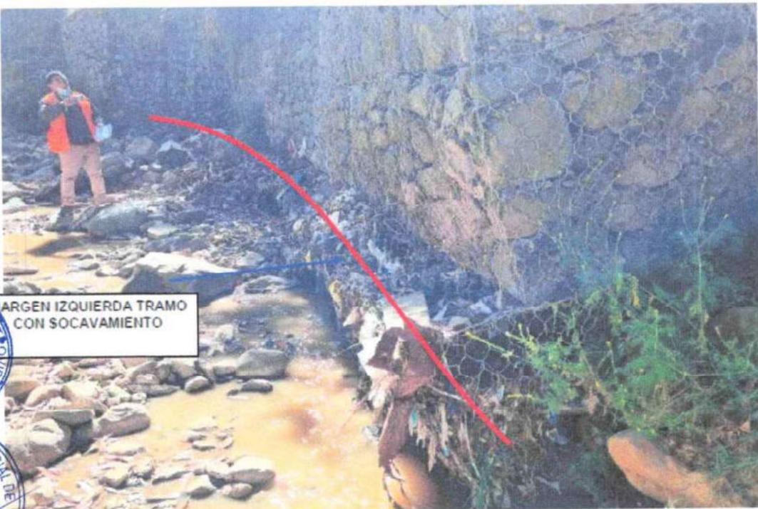
Fotografía 02: En la vista se observa la afectación por erosión fluvial en el rio Florido.
