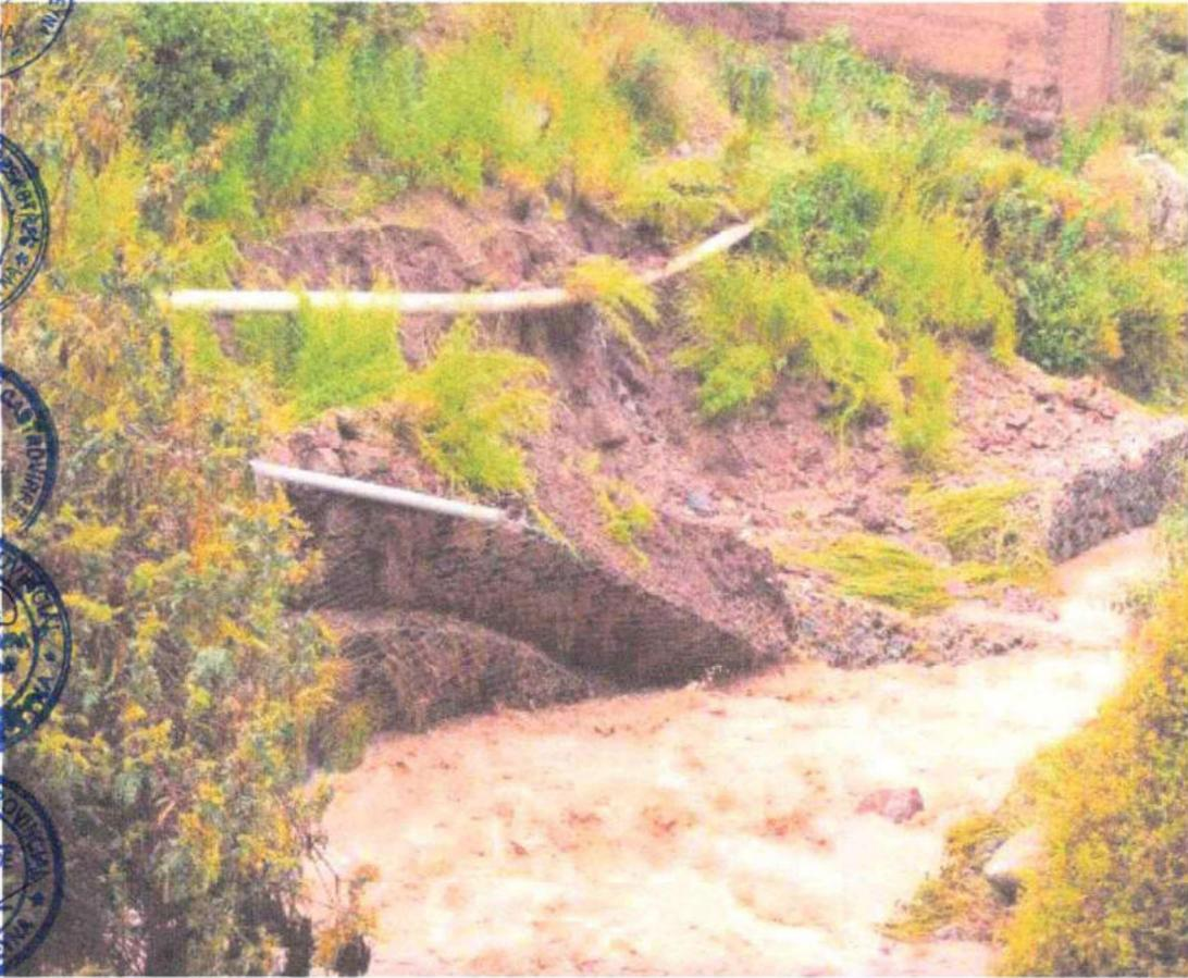
Fotografía 03: Afectación de gaviones por erosión fluvial en el río Santuario.
