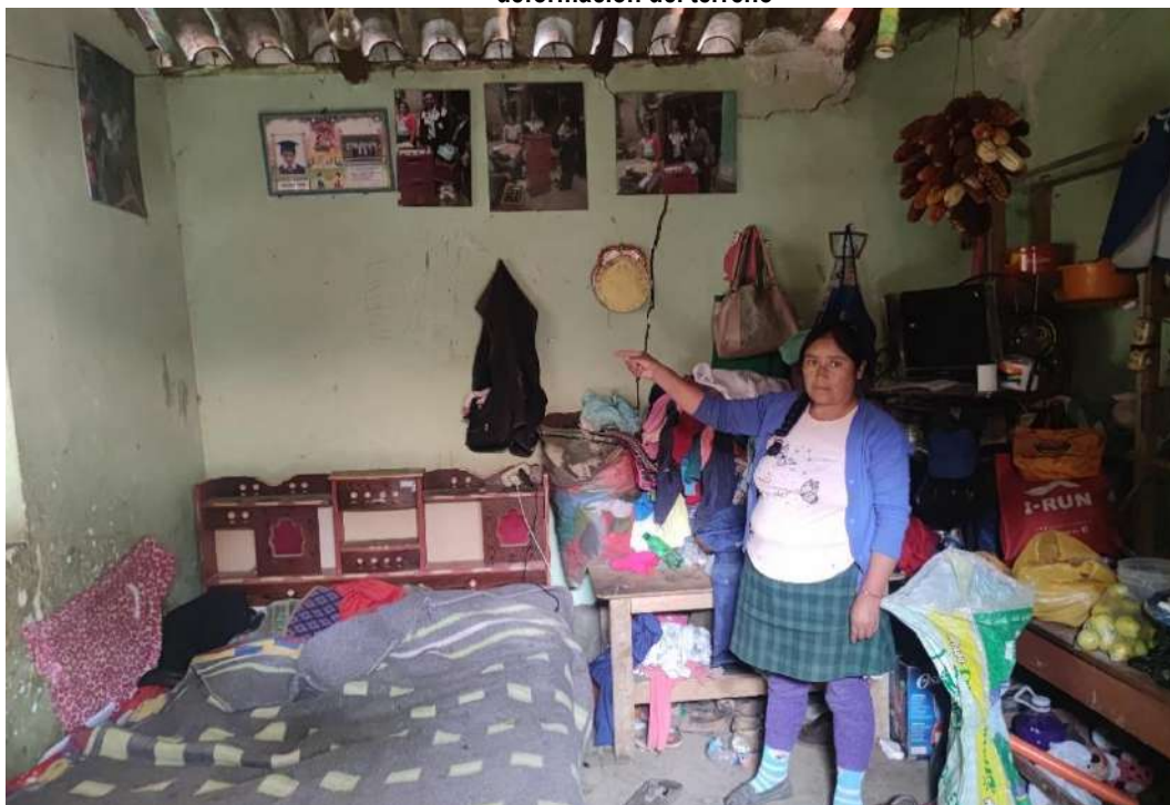
Figura N° 24. Grieta en el interior de una vivienda en el centro poblado Nunupata, producto de la deformación del terreno
