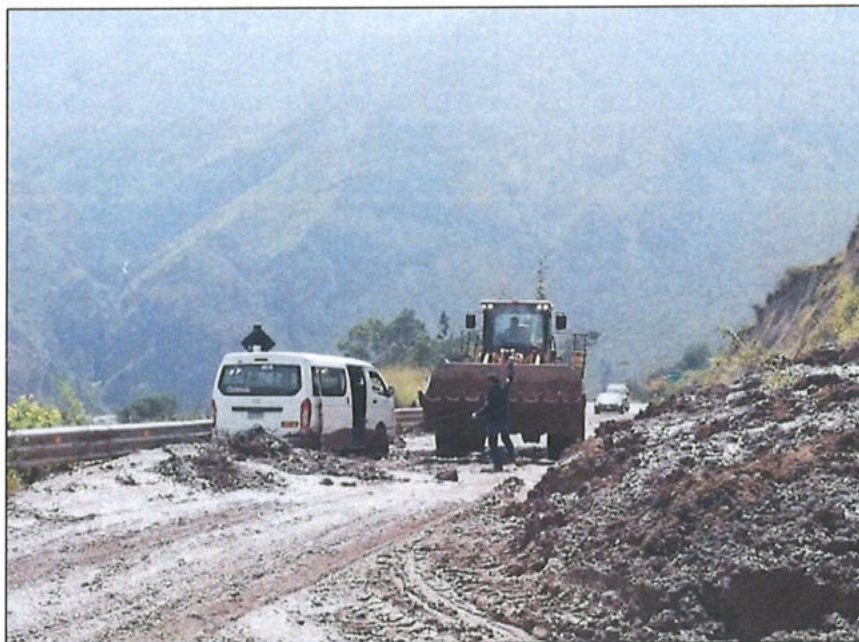
Fotografía 17. Derrumbe en el tramo Lima – Canta, Sector Matupampa
