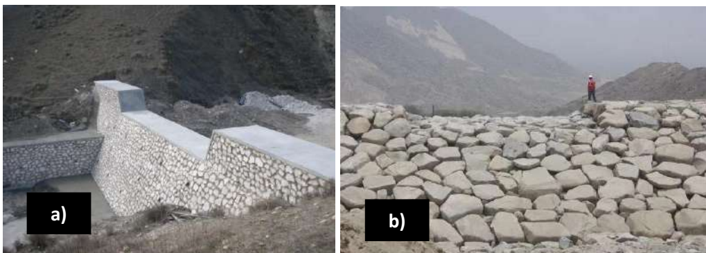
Figura N° 2. Dique de retención de sólido de mampostería (a) y roca (b)
