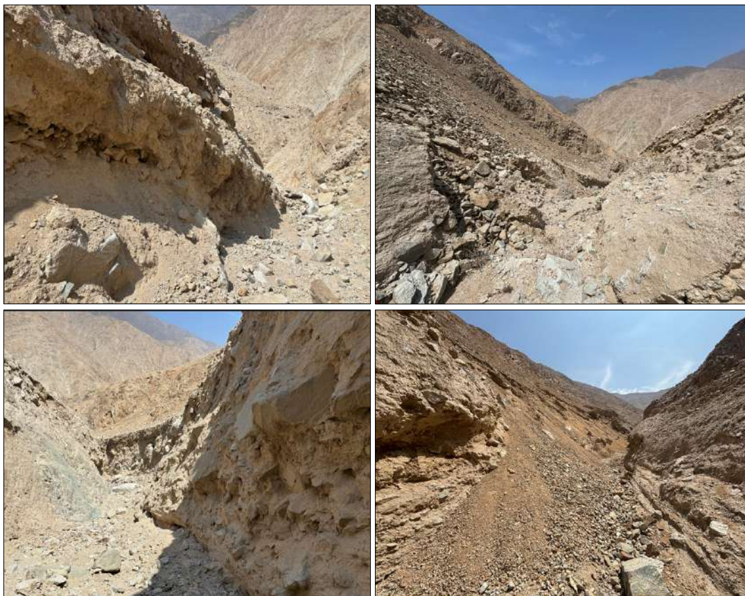
Imagen N° 001: Se observa la propuesta de ubicación de algunos hitos de la faja marginal de la Quebrada Corral Quemado en ambas márgenes.
