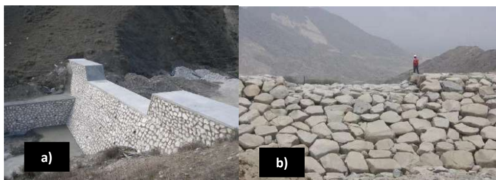
Figura N° 9. Dique de retención de sólido de mampostería (a) y roca (b)
