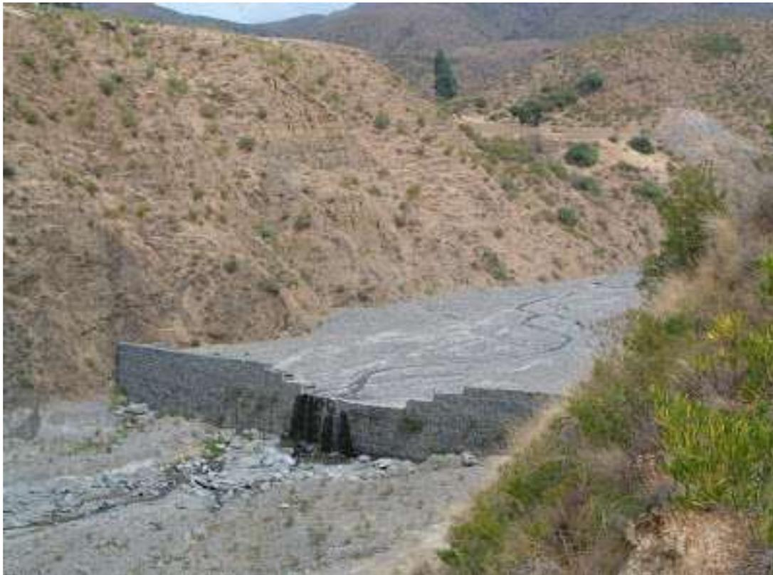
Foto 3. Presa gaviones utilizada para controlar flujo de detritos.
