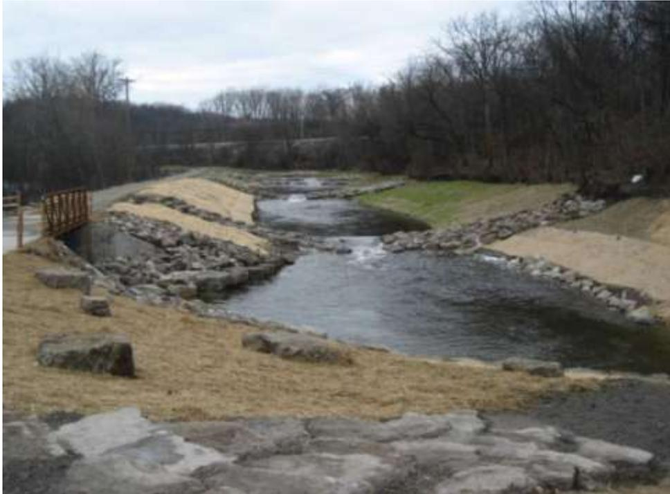
Foto 8. Vista de espigones usados en el re direccionamiento del flujo.
