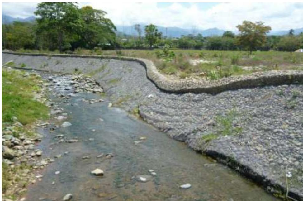
Foto 7. Canalización de cauce teniendo como elemento estructural celda de Colchonetas.
