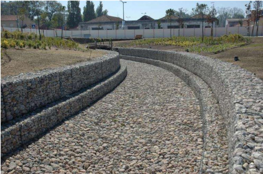
Foto 5. Canalización de cauce teniendo como elemento estructural celda de gaviones.
