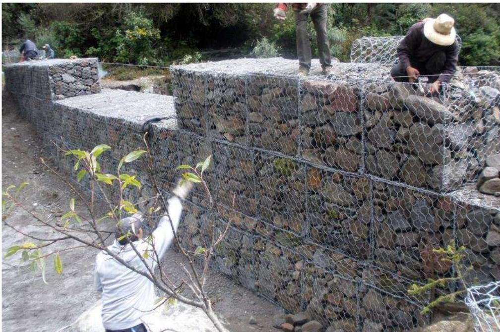
Foto 2. Muro de gaviones en pleno proceso constructivo.
