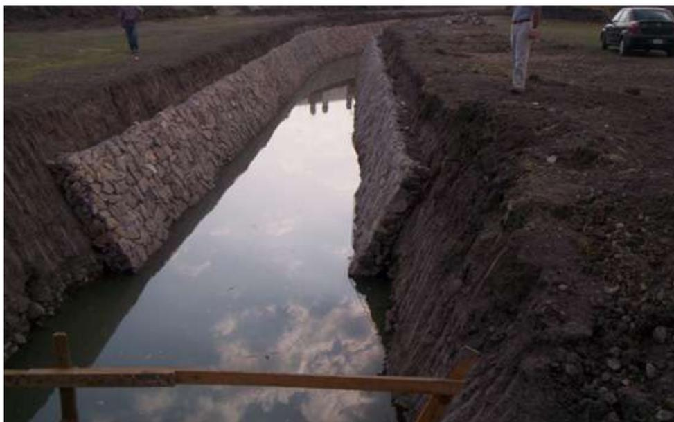
Foto 6. Canalización de cauce teniendo como elemento estructural celda de Colchonetas.
