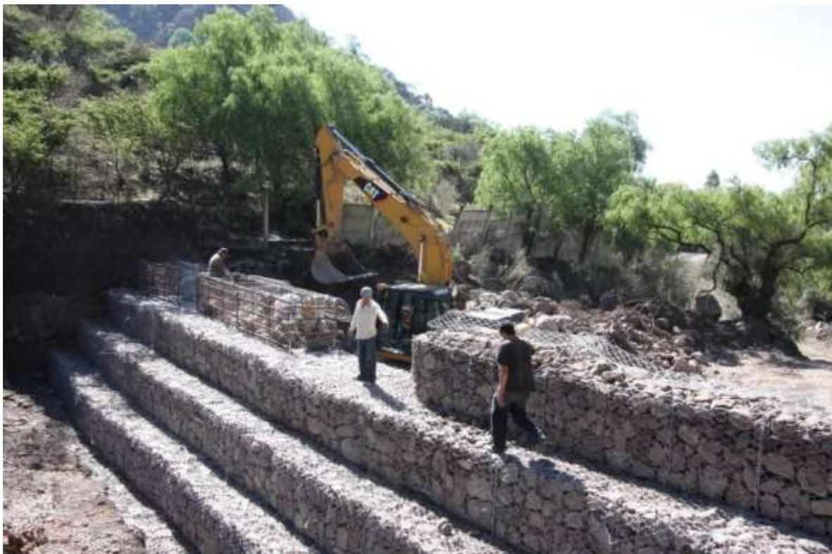
Foto 4. Construcción de una presa de gaviones
