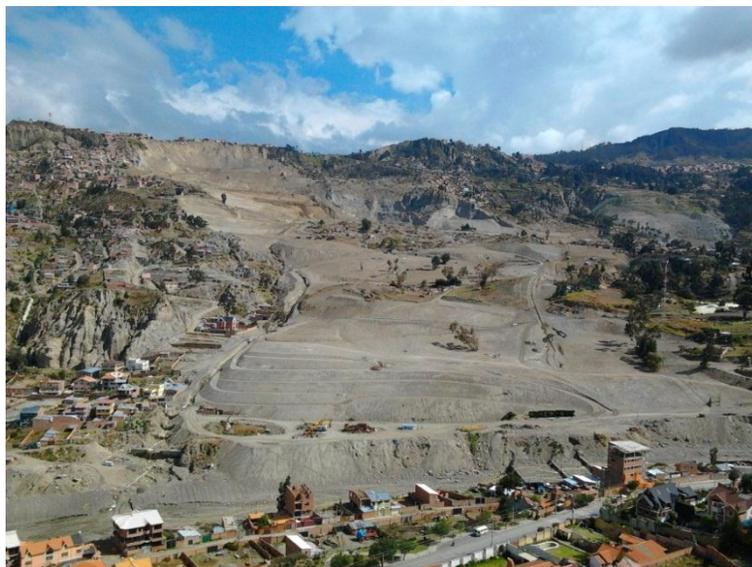
**Ilustración 32. Vista del deslizamiento de Pampahasi bajo Central a los tres meses después del suceso.**
