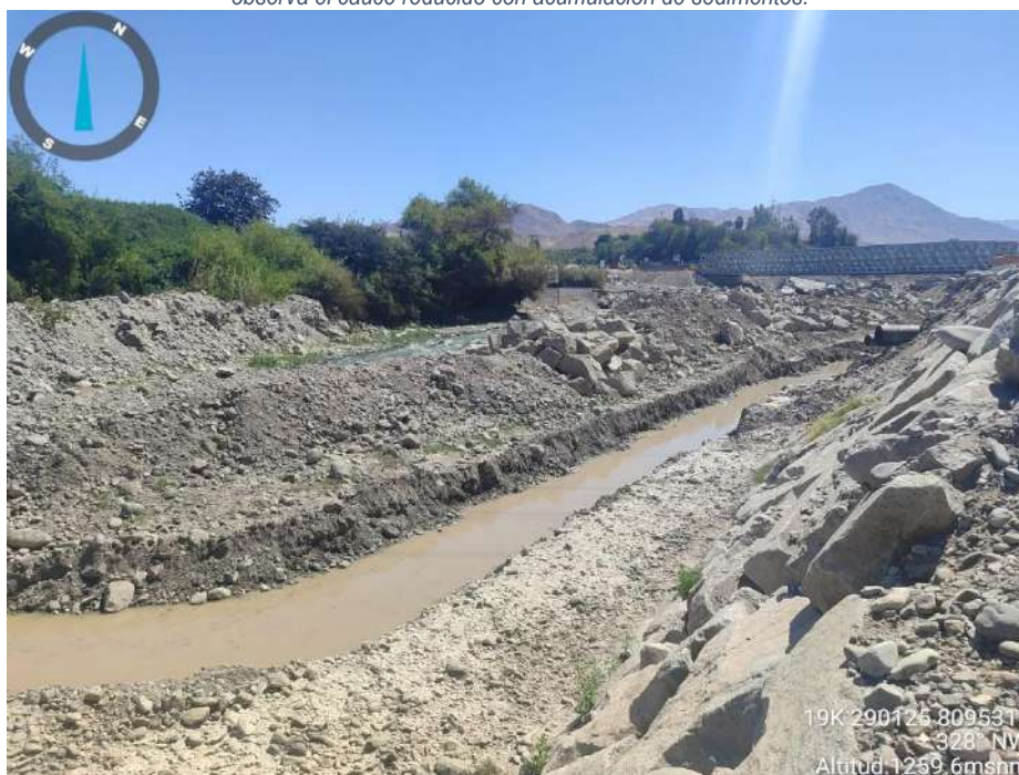
Foto 8: Vista aguas abajo del puente metálico tipo Bailey provisional en el sector Montalvo, donde se observa el cauce reducido con acumulación de sedimentos.
