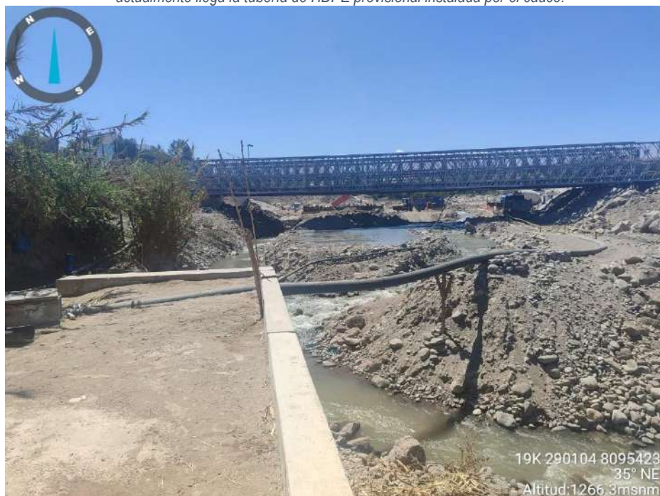
Foto 16: Muro de contención que protege el canal de ingreso en el sector Montalvo, donde actualmente llega la tubería de HDPE provisional instalada por el cauce.
