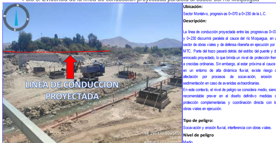
Foto 5: Evidencia de la línea de conducción proyectada paralela al cauce del río Moquegua
