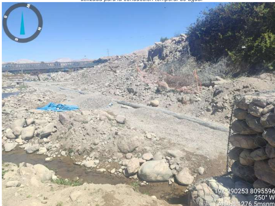
Foto 14: Tubería de HDPE instalada de forma provisional dentro del cauce del río Moquegua, utilizada para la conducción temporal de agua.
