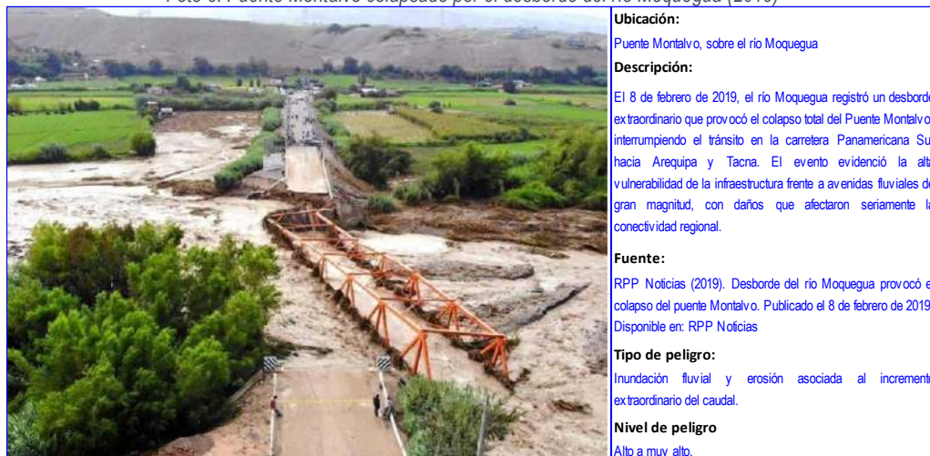
Foto 6: Puente Montalvo colapsado por el desborde del río Moquegua (2019)
