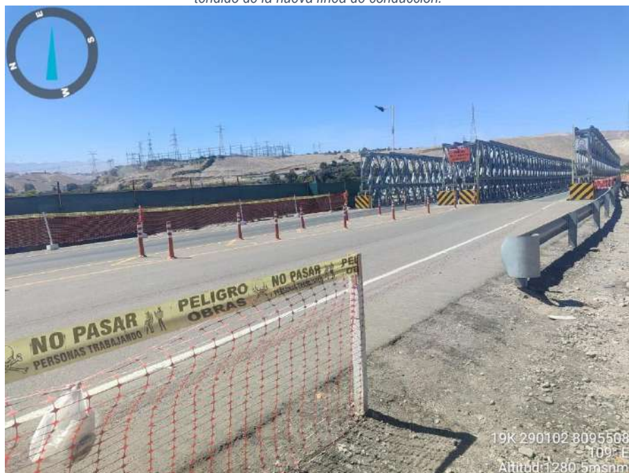
Foto 10: Zona de acceso vial antes del puente metálico provisional tipo Bailey, prevista para el tendido de la nueva línea de conducción.
