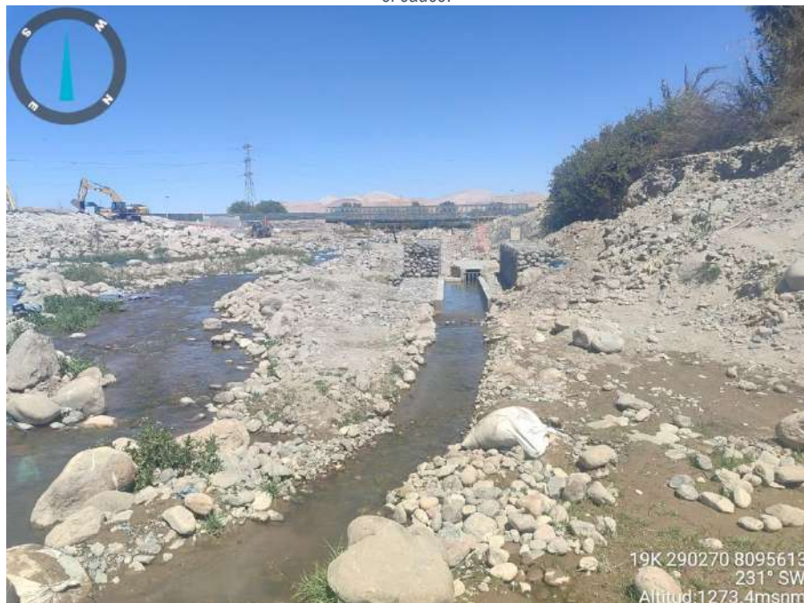
Foto 13: Se aprecia el canal de ingreso protegido con gaviones y la conducción temporal instalada en el cauce.
