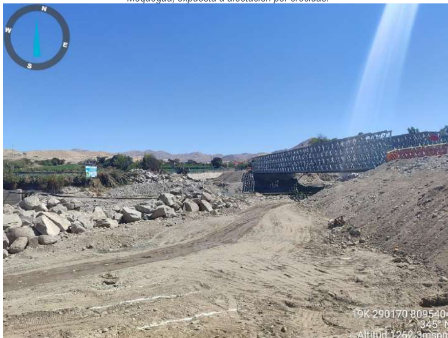
Foto 8: Vista aguas abajo del puente metálico tipo Bailey provisional en el sector Montalvo, donde se observa el cauce reducido con acumulación de sedimentos.
