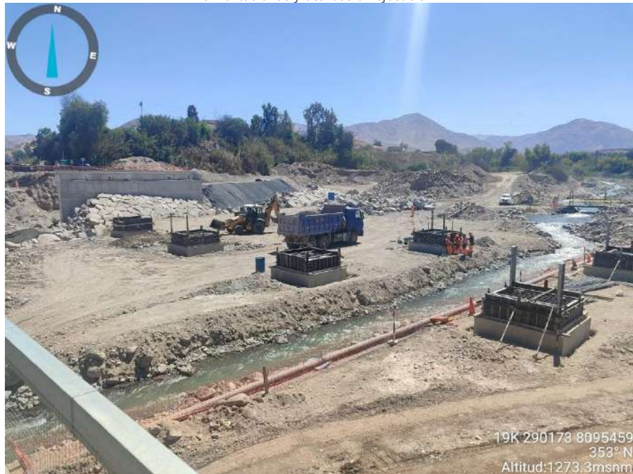
Foto 9: Construcción del nuevo puente vehicular en el sector Montalvo a cargo del MTC, con cimentaciones y estribos en ejecución.
