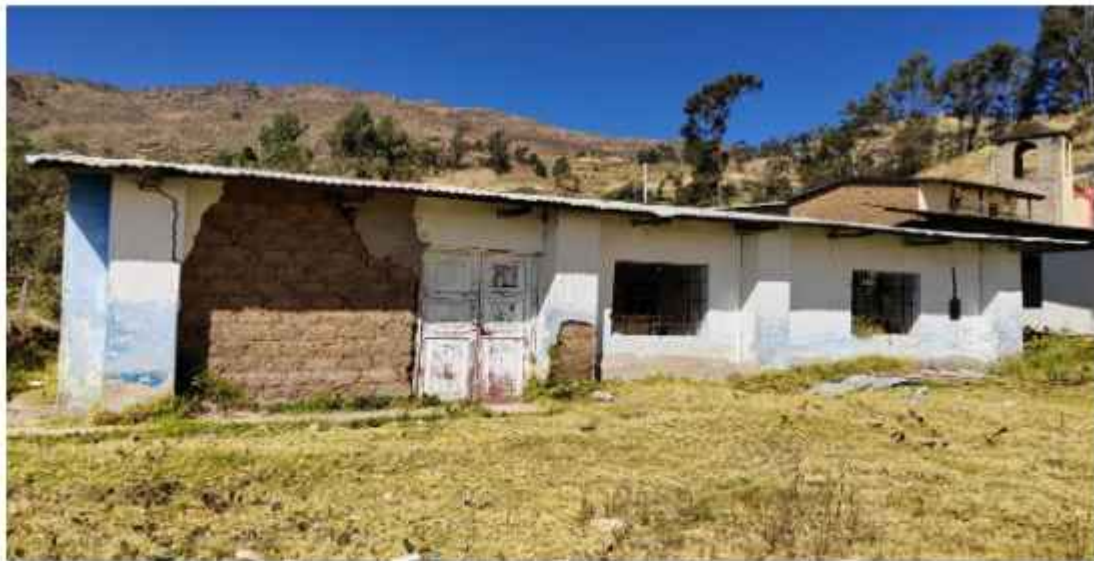
Foto 5. Agrietamiento en viviendas
