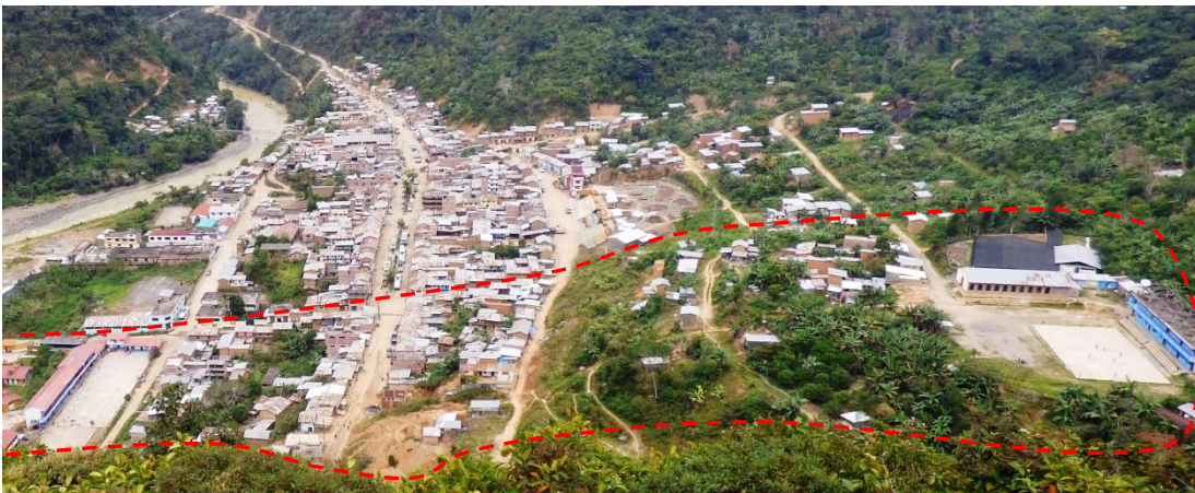
Foto 12. Delimitada con líneas discontinuas de color rojo se observa la actividad antrópica del Barrio Selva Alegre (deforestación, cortes de talud, etc) y el área susceptible a procesos de movimientos en masa.
