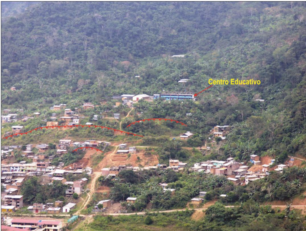
Foto 7. Vista panorámica de las escarpas de deslizamiento activos ubicados en el Barrio Selva Alegre. También se observa el centro educativo afectado por fisuras en sus paredes.
