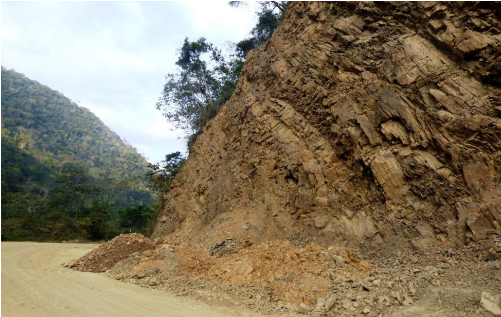
Foto 1. Afloramiento rocoso de la Formación Sandia conformado por pizarras y areniscas delgadas ubicado a la entrada del pueblo San Pedro de Putina Punco.
