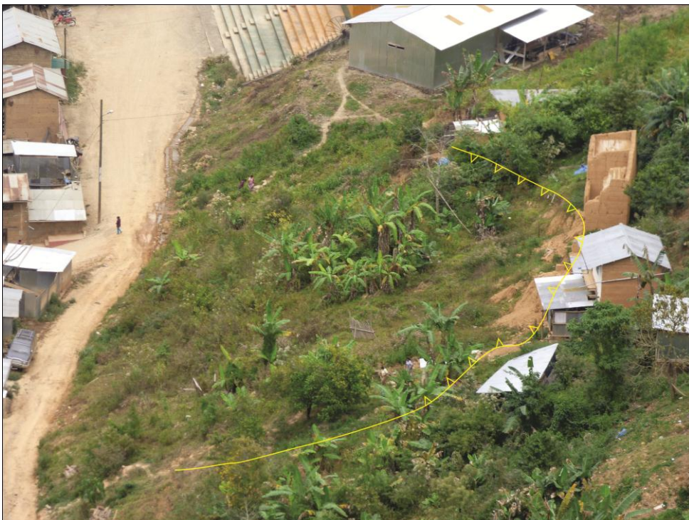
Foto 8. Vista de una de las escarpas de deslizamiento activo ubicado en el Barrio Selva Alegre.
