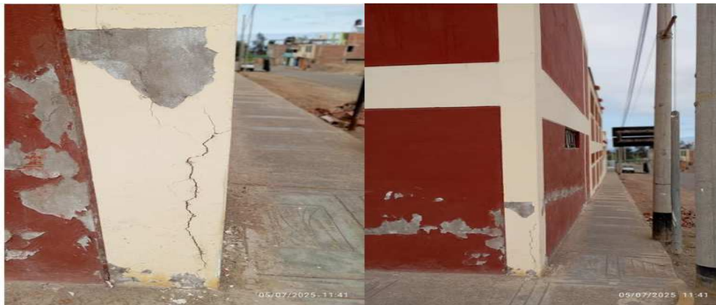
Fotografía N° 5. Fisura en columna del Bloque 8 – Depósitos (I.E. N.° 42003 “José Carlos Mariátegui”), julio 2025
