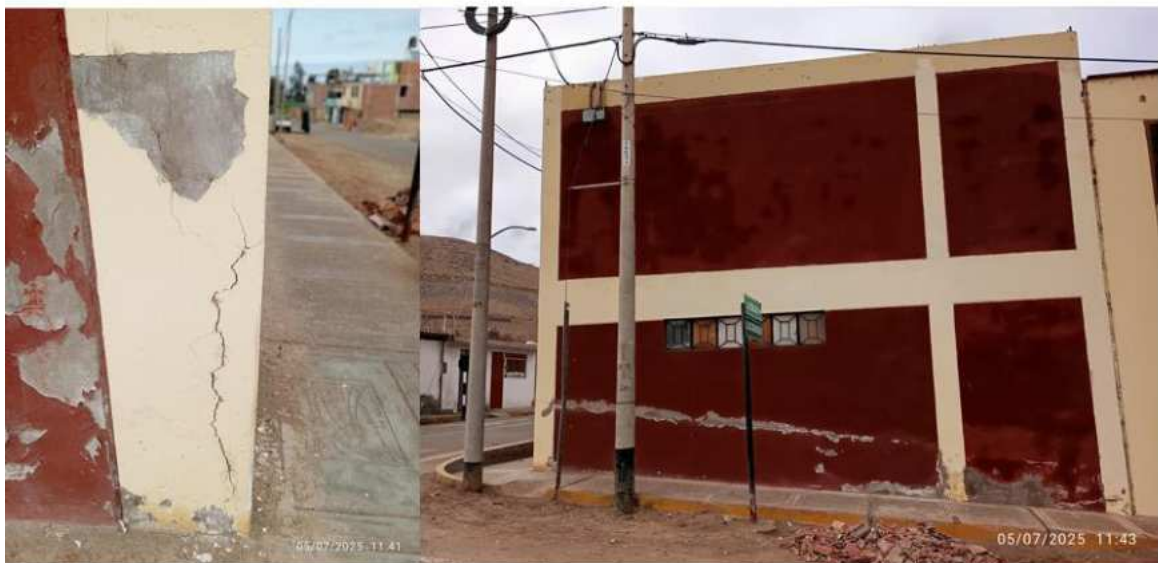
Fotografía N° 8 Fisura en columna Bloque 8 utilizada como almacén dentro de la I.E. N° 42054
