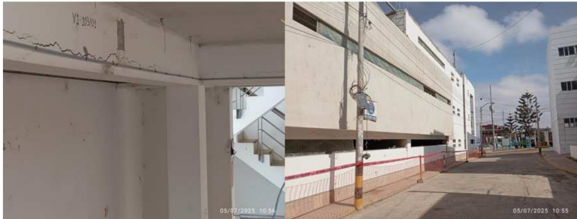
Fotografía N° 7 Fisuras estructurales en columna y viga de una edificación pública fuera del área de intervención directa.
