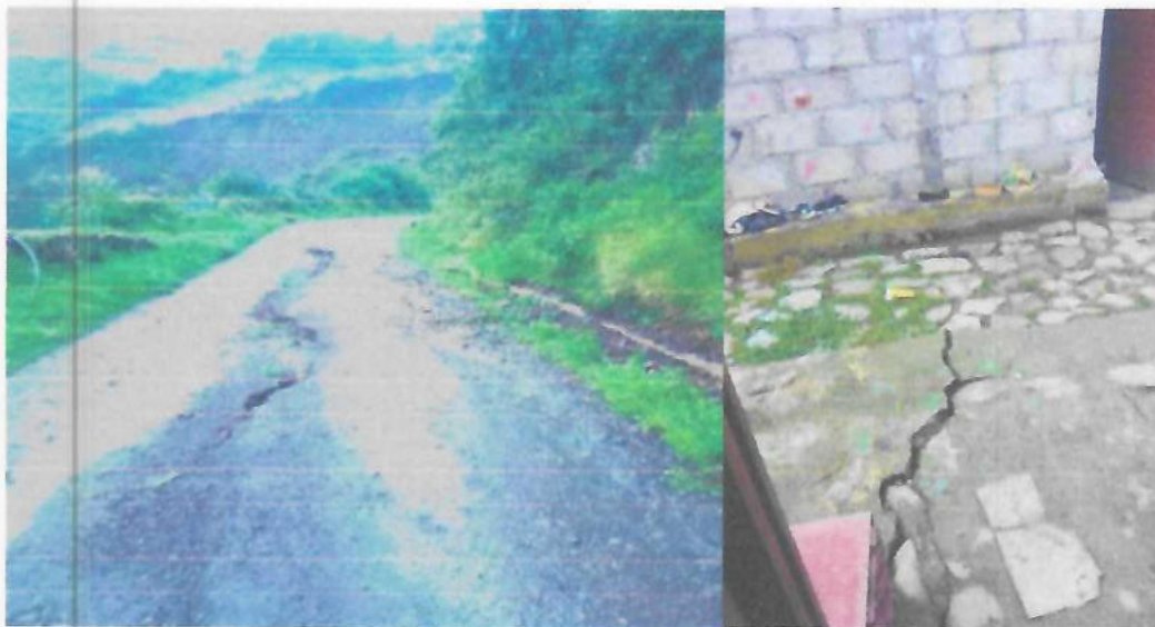
Fotografía 03: Fisuras y grietas en los caminos del centro poblado San Isidro a causa de deslizamientos.
