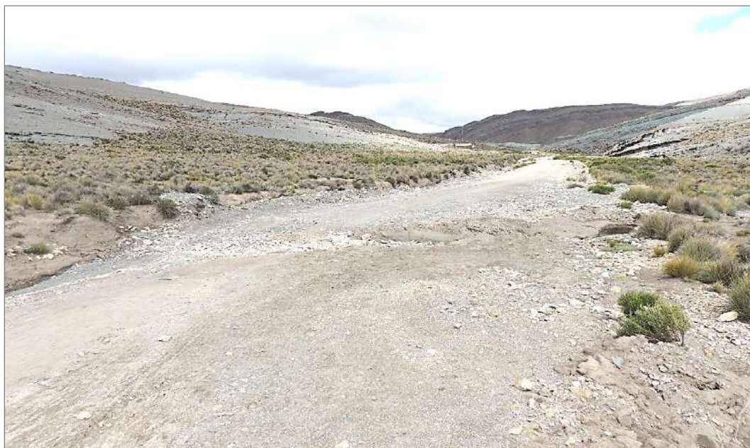
Figura 29: Cuneta en mal estado por colmatación de flujo de detritos
