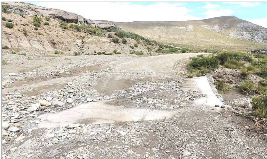
Figura 28: Baden existente progresiva 9+720
