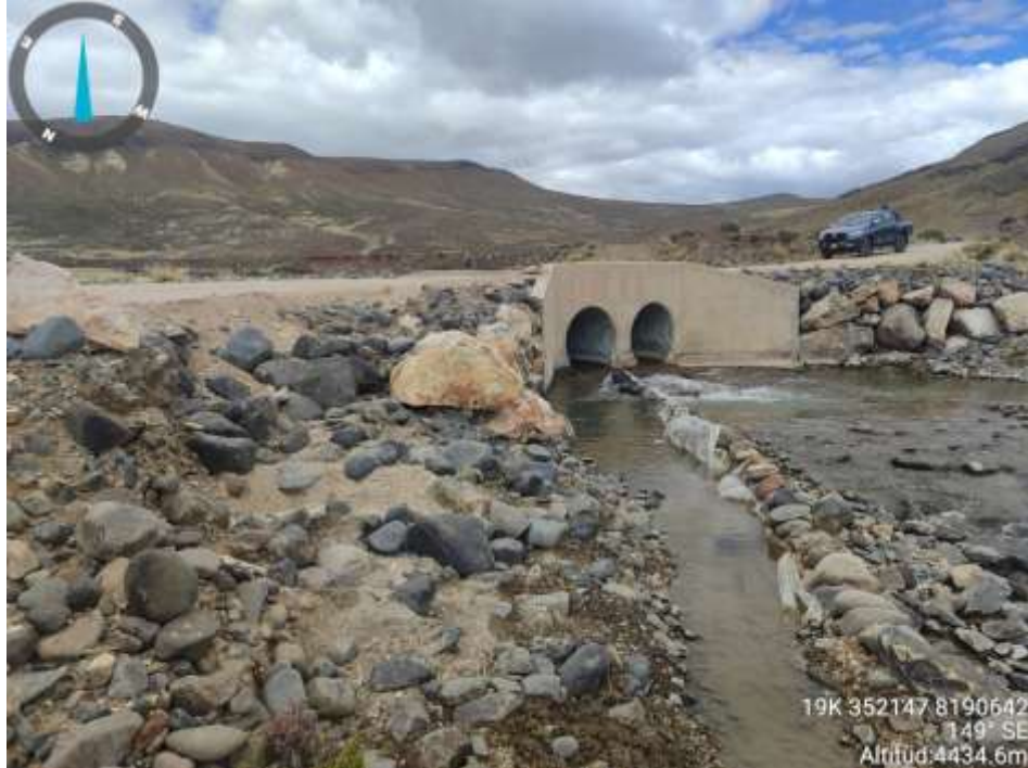
Foto 7: Vista de alcantarilla existente Km 10+880
