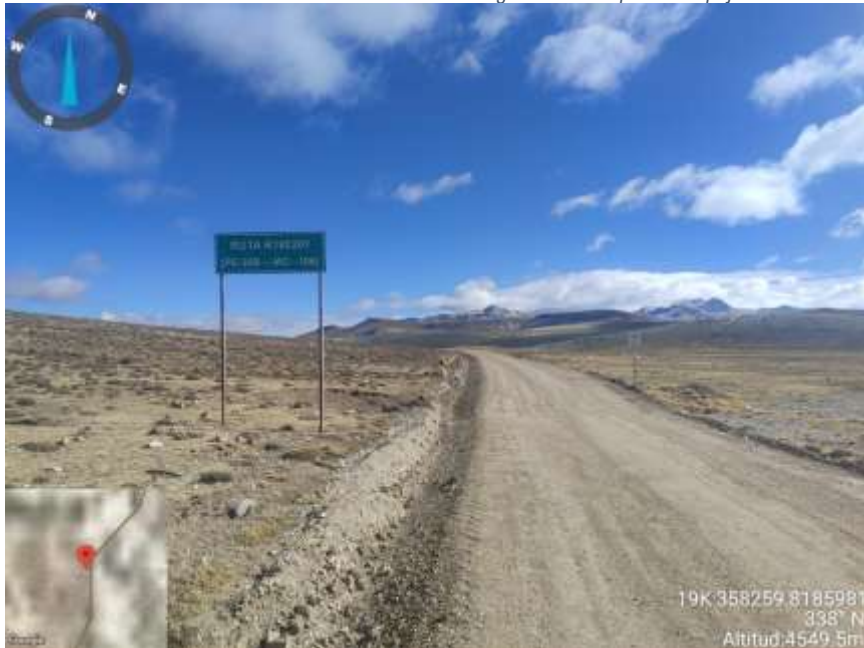
Foto 1: Vista de inicio de tramo 0+000 - Ingreso a la vía por Jancopujo
