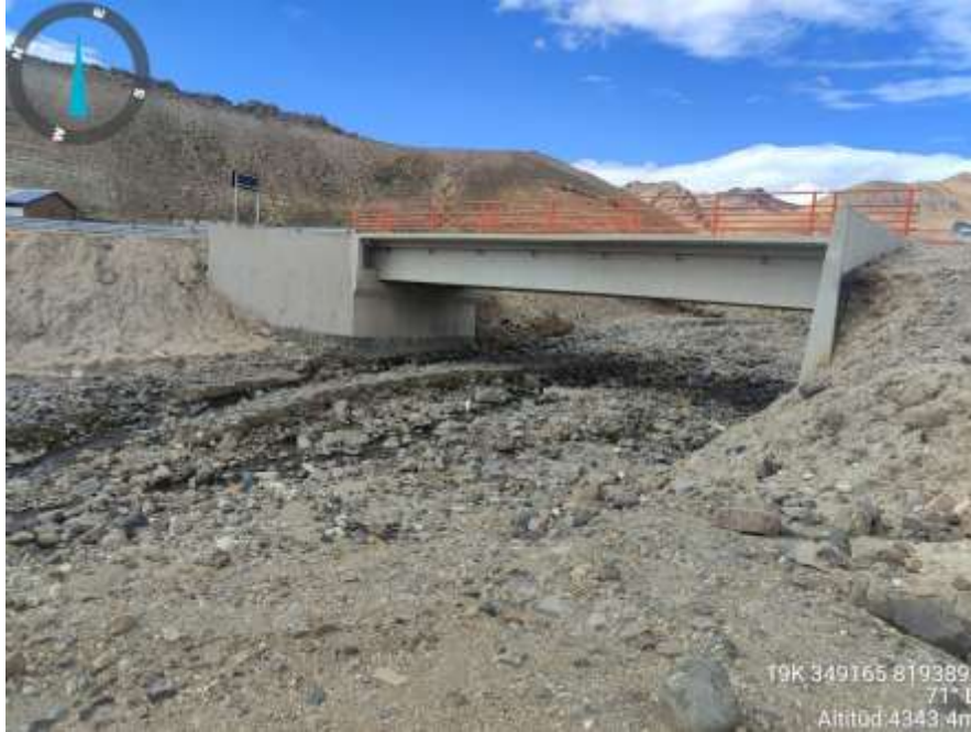
Foto 9: vista de Puente Bertani km 15+700
