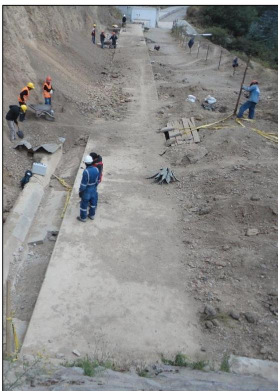
Foto 3: Canal de aducción de la central hidroeléctrica de Huanchor, muestra pendiente muy baja
