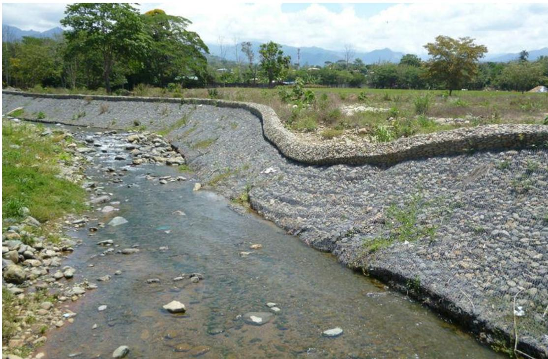
Fotografía 8. Colchonetas de piedra y gaviones para la protección de erosión lateral y/o socavamiento.
