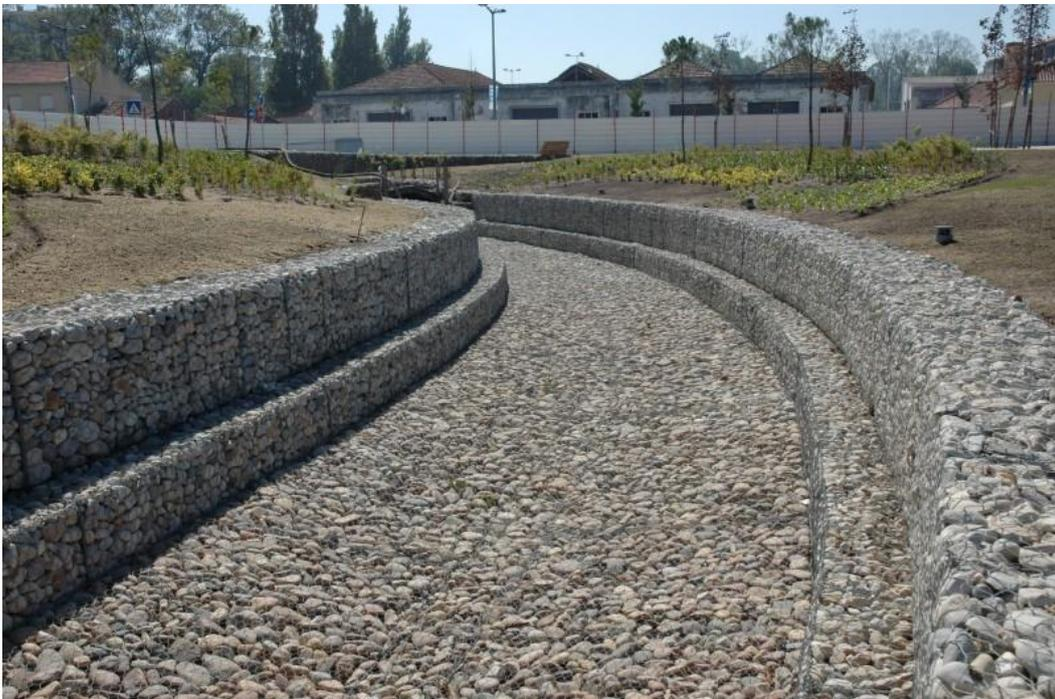
Fotografía 6. Canalización de cauce teniendo como elemento estructural celda de gaviones.
