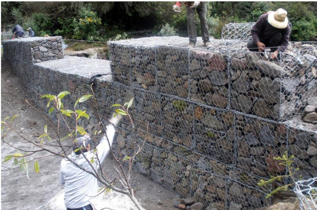
Fotografía 2. Muro de gaviones en pleno proceso constructivo.
