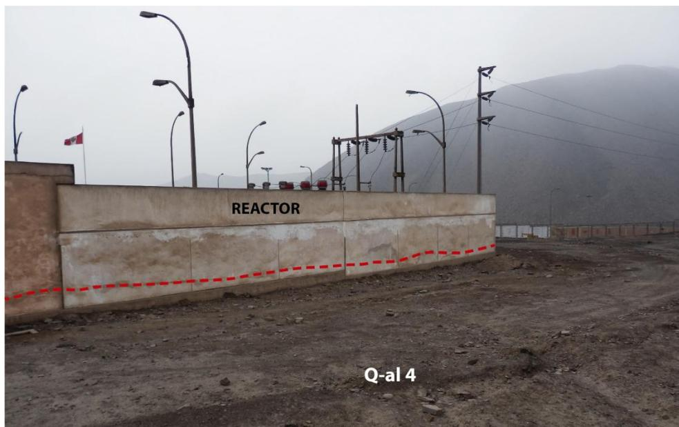
Figura 10. Se observa el reactor y el flujo del 2002. La línea roja muestra el nivel donde llegó el flujo de detritos del año 2002.
