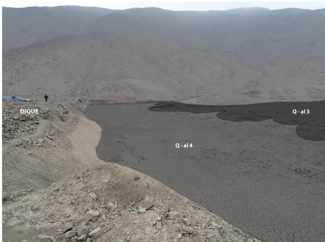
Figura 8. Se observa el dique construido y los depósitos retenidos del flujo de detritos que descendieron de la quebrada San Juan el año 2002.
