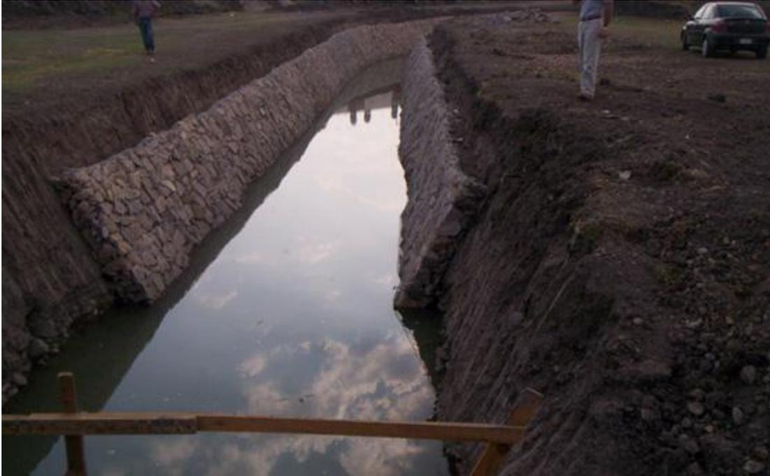
Fotografía 7. Canalización de cauce teniendo como elemento estructural celda de Colchonetas.
