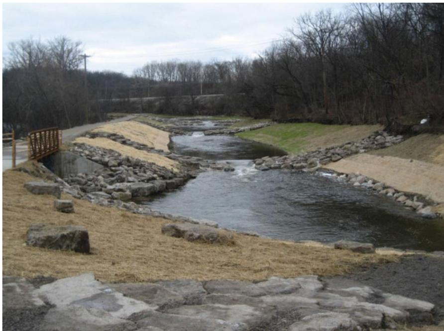
Fotografía 9. Vista de espigones usados en el re direccionamiento del flujo.
