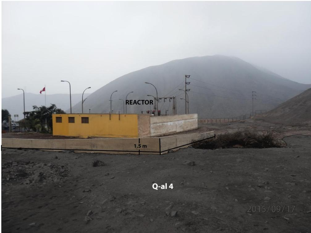
Figura 9. Se observa el muro de contención protegiendo el reactor, soporto en parte el flujo de detritos del año 2002.
