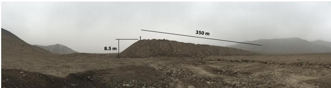
Figura 7. Se observa el dique construido para protección contra flujos de detritos. Sus dimensiones son 30 x 350 x 8.5m.
