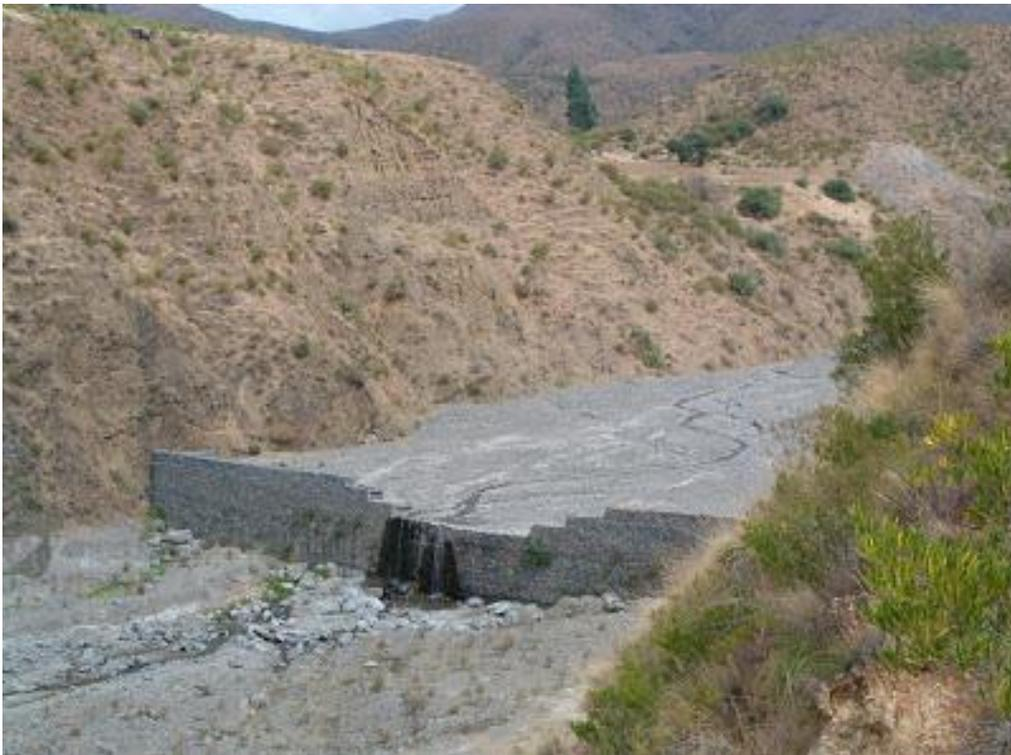
Fotografía 2. Presa gaviones utilizada para controlar flujo de detritos.
