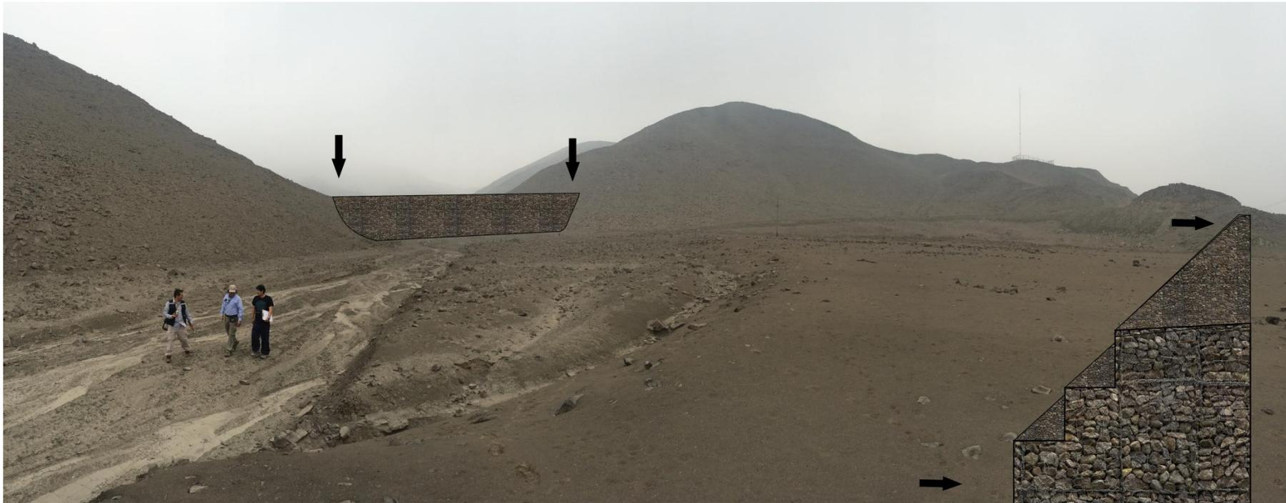
Anexo 3. Modelo para la construcción de dique y muro de contención, las construcciones puede ser con gaviones o mampostería. El dique debe de tener sumideros para que discurran los excedentes (agua) y el muro de contención debería de ir reforzado con espigones para controlar los flujos de detritos (huaycos) futuros.
