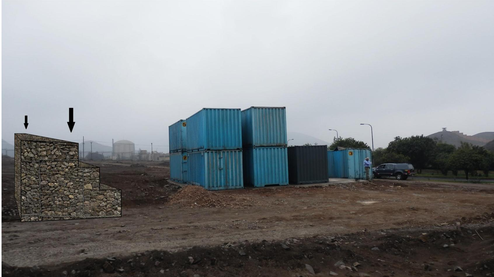
Anexo 4. Modelo para la construcción muro de contención, para la protección de los container de Ingemmet y el Reactor que se ubica en el ingreso a las instalaciones Estos servirán para controlar los flujos de detritos (huaycos) futuros.
