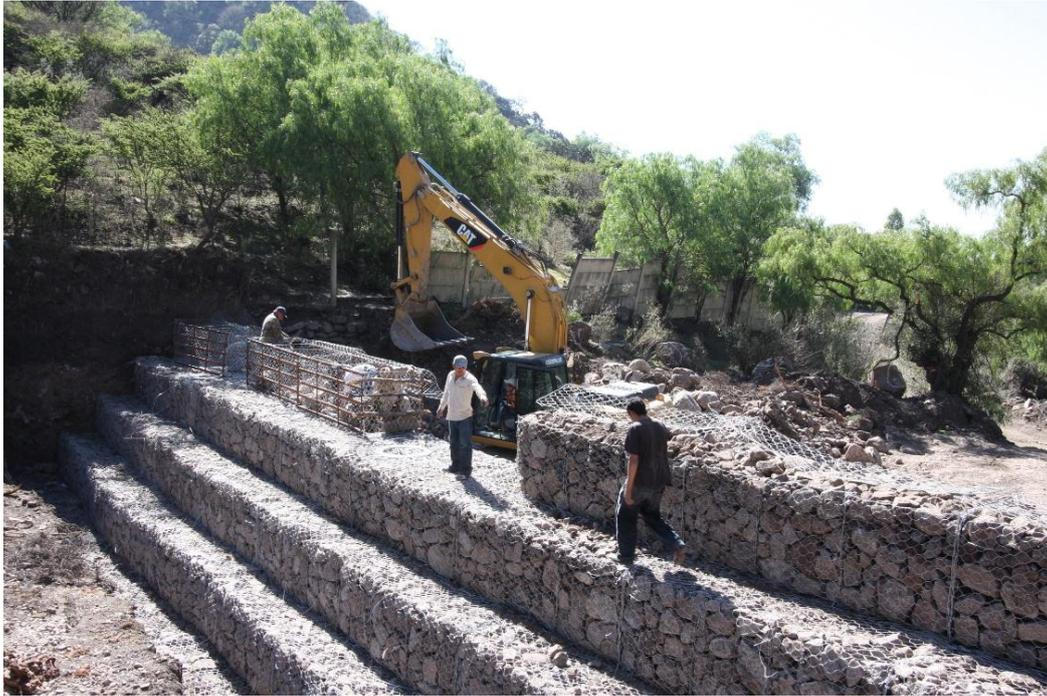
Fotografía 4. Construcción de una presa de gaviones
