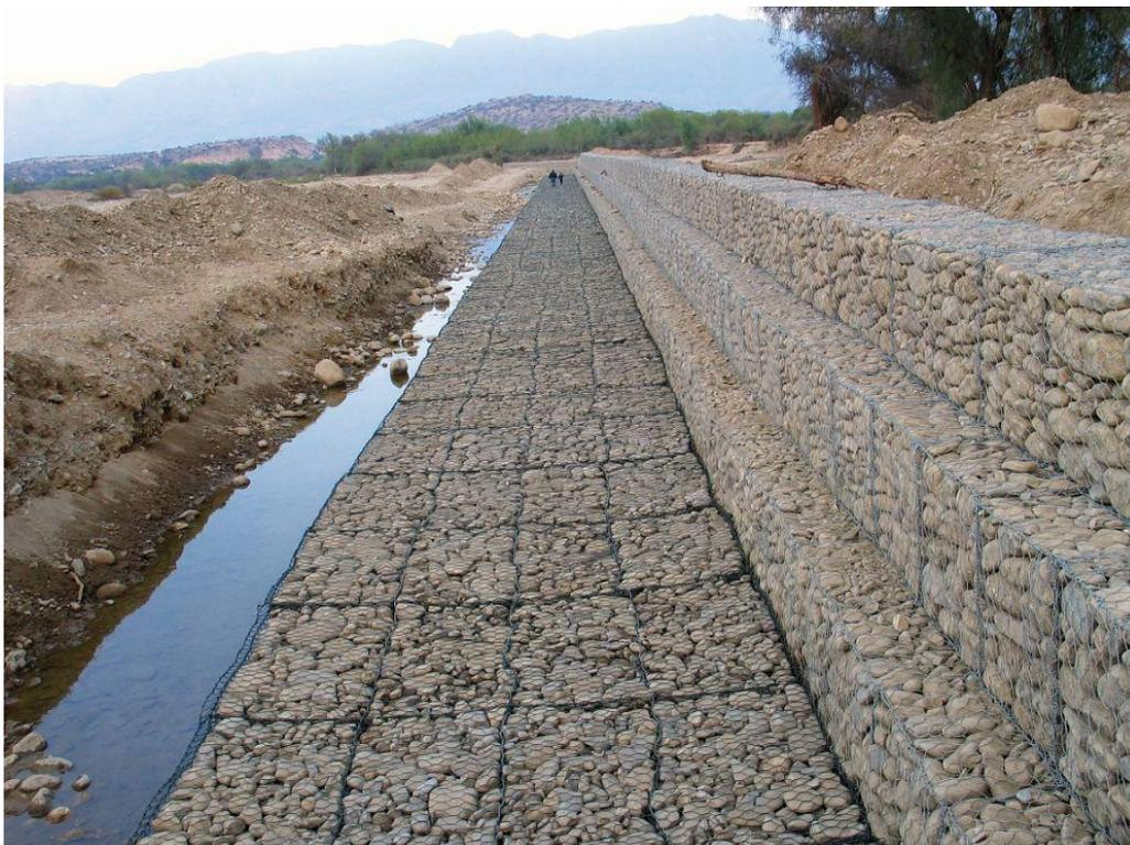
Fotografía 5. Ejemplo de construcción de muro con gaviones y colchoneta de gaviones para evitar el socavamiento y conservar el muro.
