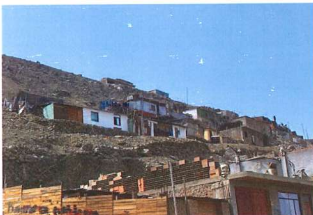
VIVIENDAS PRECARIAS SOBRE PIRCAS SUPERPUESTAS EN TALUDES INESTABLES EN EL CP. EL ÁNGEL MACATON
