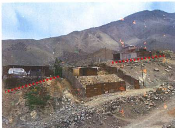
VIVEINDAS ASENTADAS SOBRE PIRCAS EN ZONAS INESTABLES
