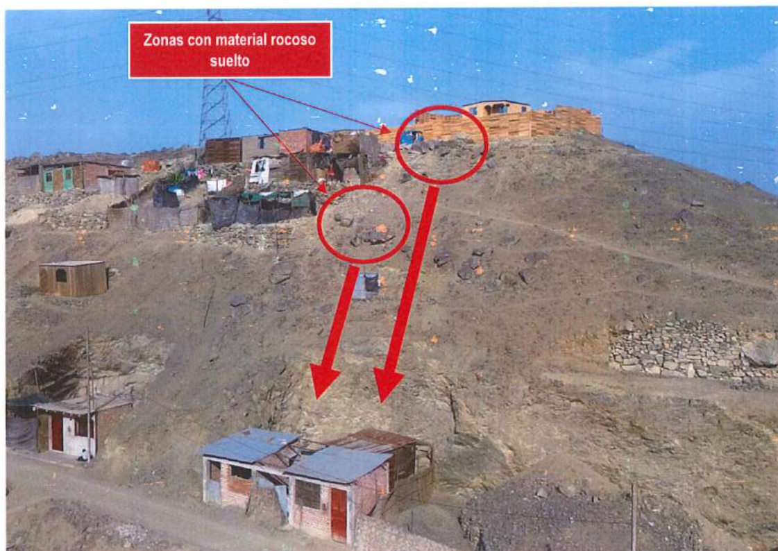
Ilustración 6: Laderas con rocas sueltas en la parte norte del CP. El Ángel Macaton que se muestra como peligro latente para las viviendas ubicadas en la parte baja.
