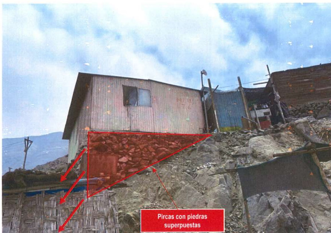
Ilustración 8: La construcción de pircas sin ningún tipo de criterio y asesoramiento técnico pone en riesgo las viviendas, más que una solución se convierte en un problema.
