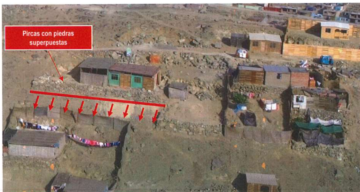
Ilustración 7: Viviendas asentadas sobre pircas superpuestas sin ningún tipo de mezcla, son estructuras inseguras que al movimiento sísmico pueden colapsar afectando a las viviendas de la parte baja.
