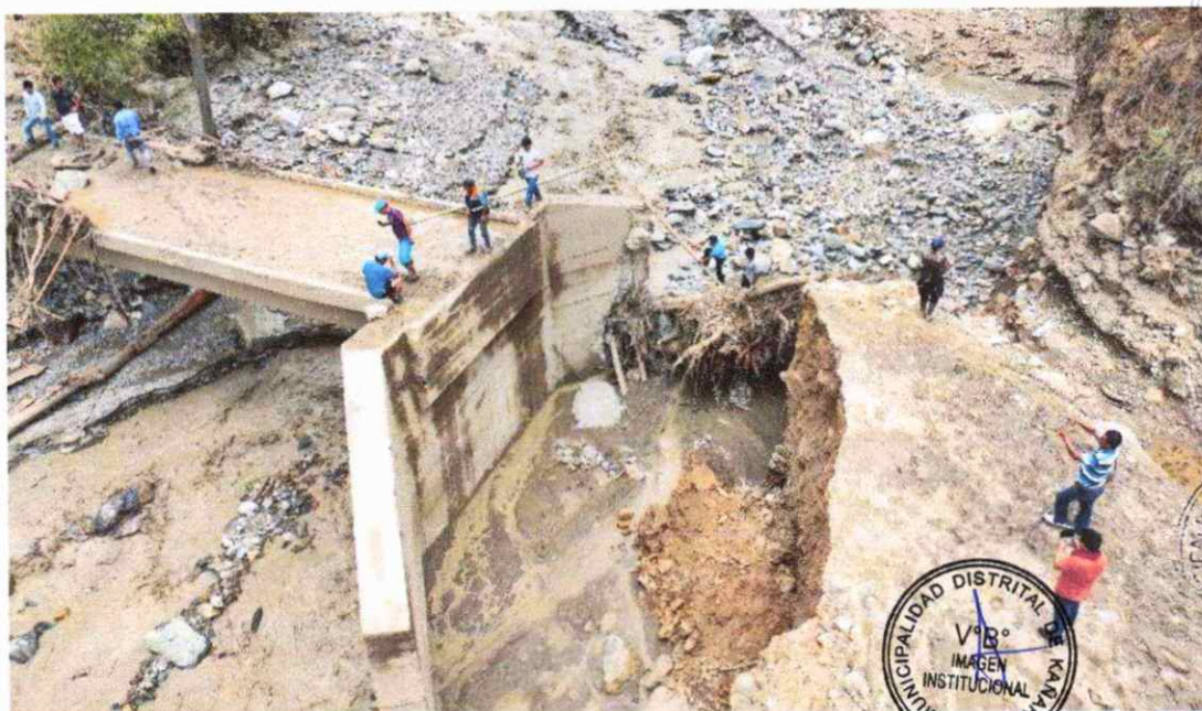
Foto N°02: Punto Crítico n°002 – Tramo Chillasque - Pishcolpampa. (Desborde/Inundación/Erosión/Socavación)
