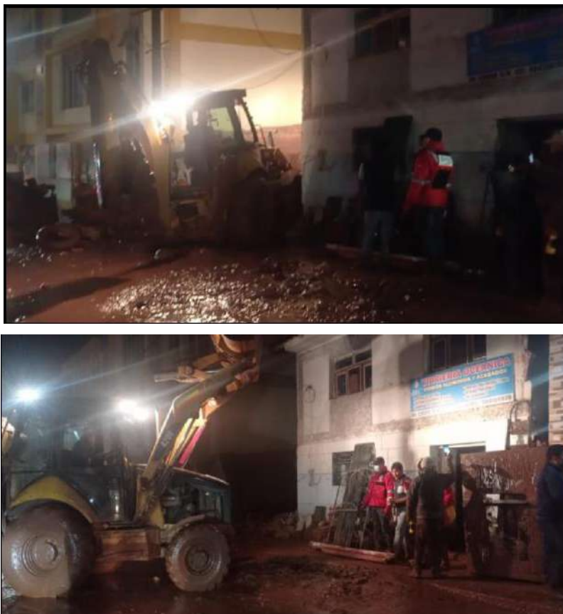
FOTOGRAFÍA 29: TRABAJOS DE LIMPIEZA DE FLUJO DE DETRITOS DE LA QUEBRADA ALFAHUAYCO, AFECTACIÓN DE LAS POSTA Y VIVIENDAS.
