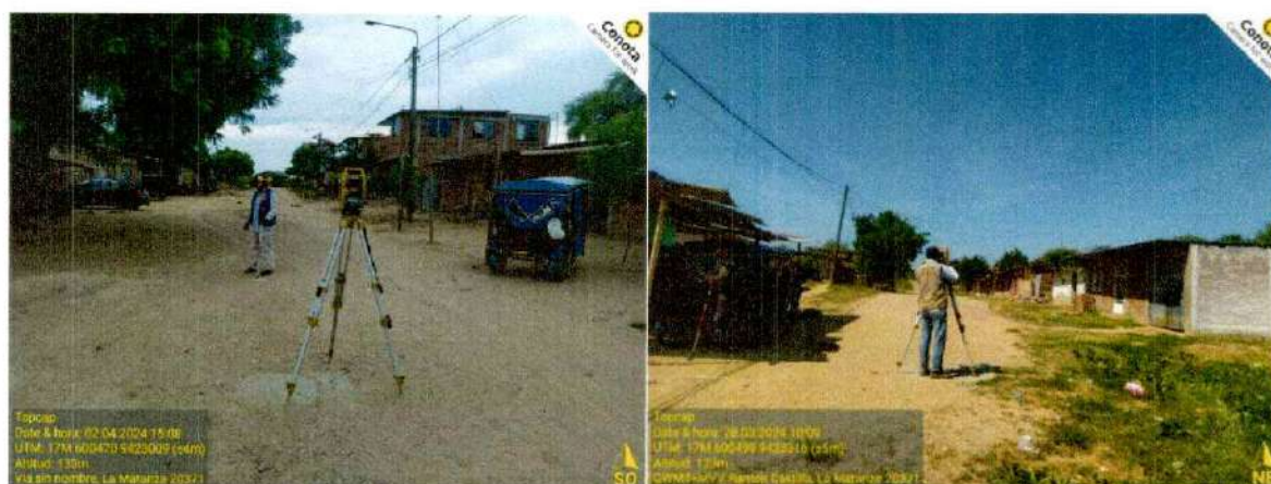
Foto 1 Realización del levantamiento topográfico de las calles del A.H. Santa Rosa
