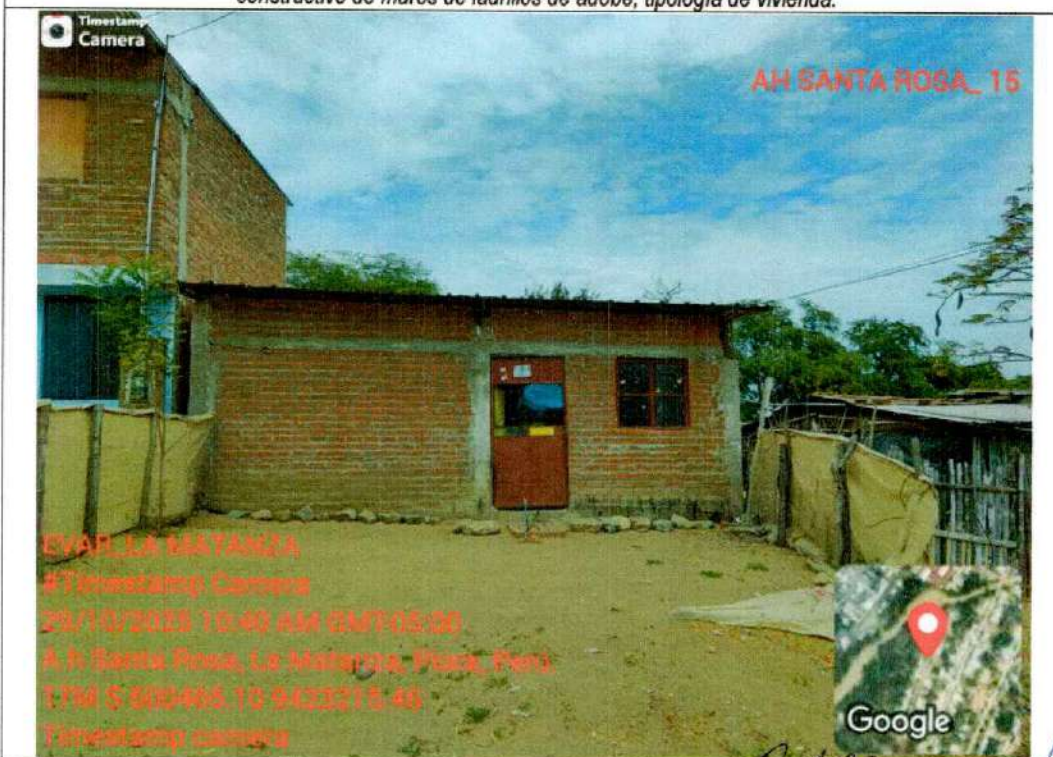
Fotografía 010: La fotografía muestra un inmueble está estado de conservación regular, edificado en sistema de albañilería confinada, tipología de vivienda.
