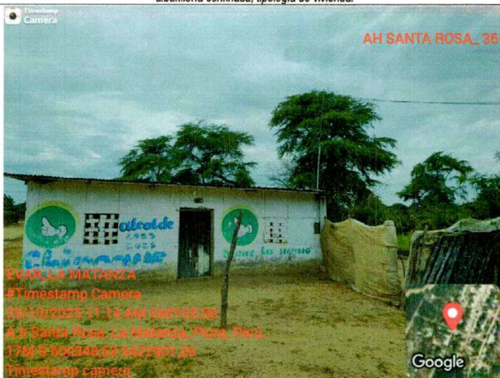
Fotografía 022: La fotografía muestra un inmueble está estado de conservación regular, edificado en sistema constructivo de Quincha (Caña con Barro), tipología de vivienda.
