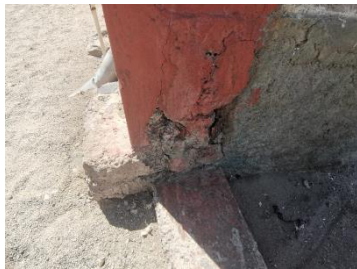
Fotografía N° 4 Columnas de cerco perimétrico deterioradas
