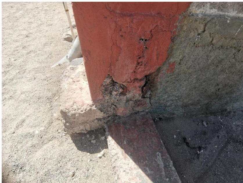
Fotografía N° 8-6: Evidencias de deterioro de concreto en columna.
