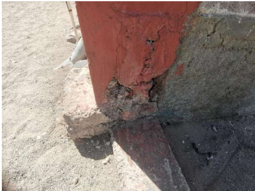
Fotografía N° 8-6: Evidencias de deterioro de concreto en columna.
