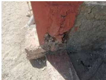
Fotografía N° 4 Columnas de cerco perimétrico deterioradas
