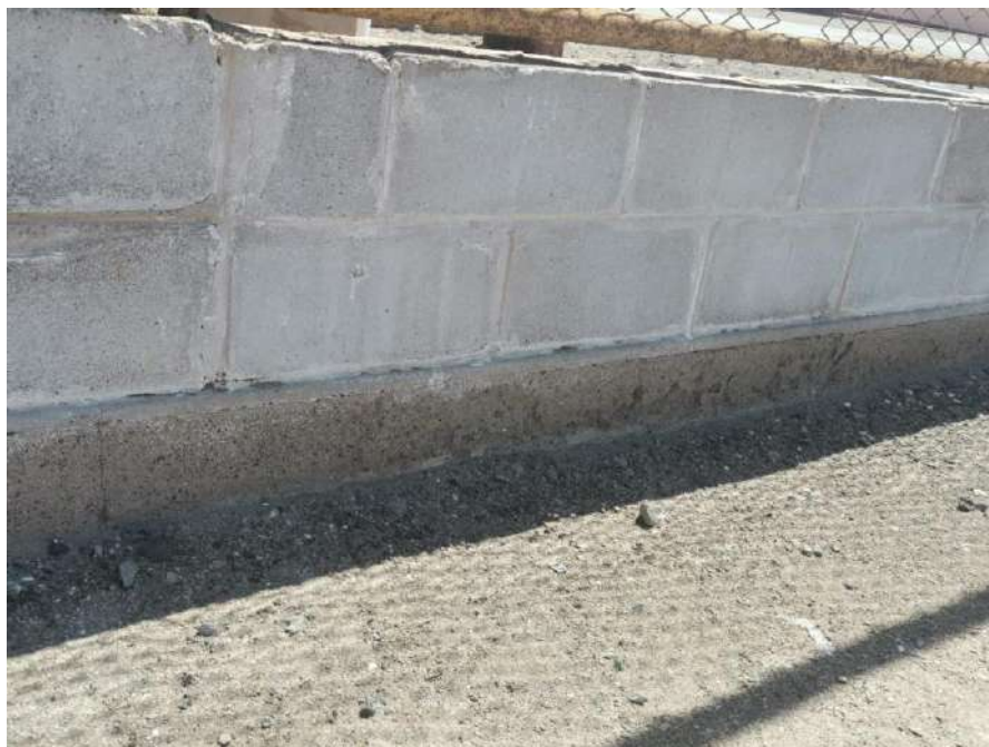
Fotografía N° 8-7: Evidencias de deterioro de concreto en columna.
