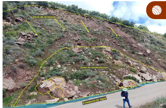
Figura 28. Derrumbes identificados en el sector Kumurumuy. La caída de materiales afecta la seguridad física de la carretera de la vía CU-117 en Paruro.
